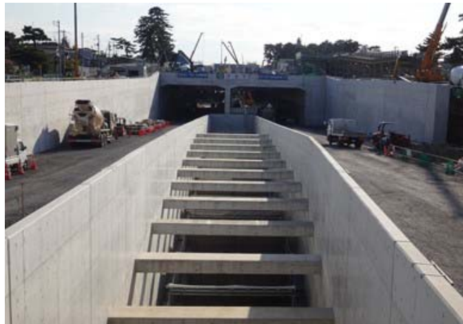
進捗状況：函体完成 地上で埋戻し中
