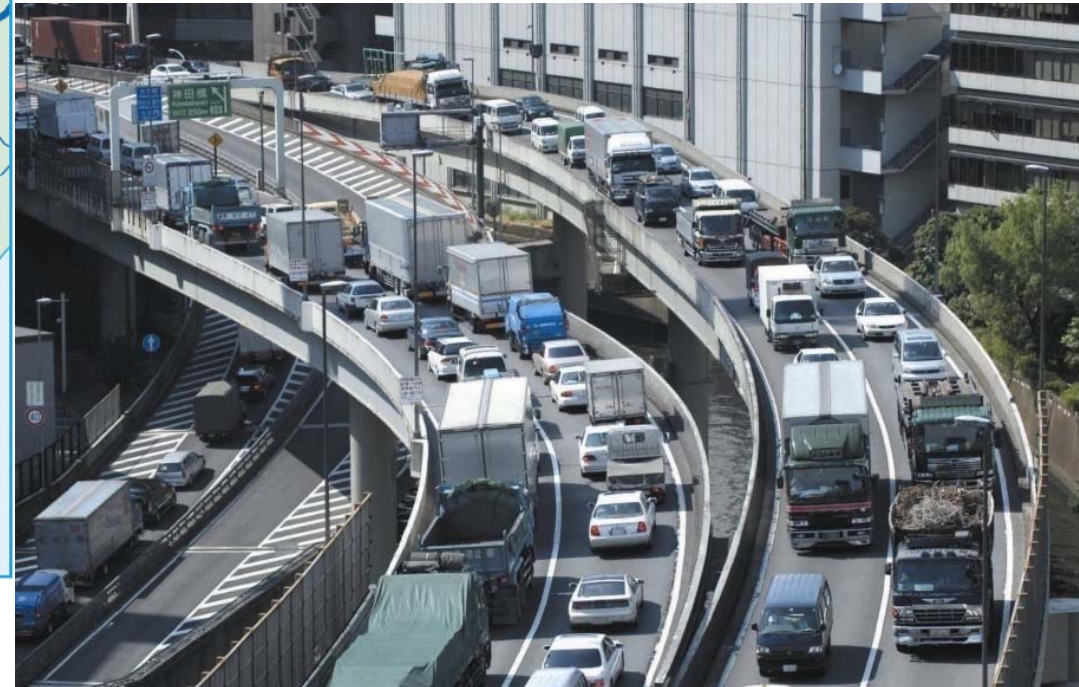
首都高速道路神田橋 J C T 付近
