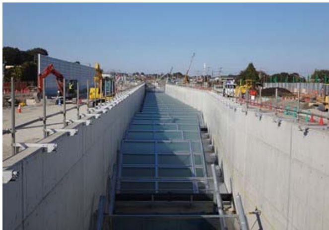
進捗状況：函体完成 地上で埋戻・眩光対策工施工中
