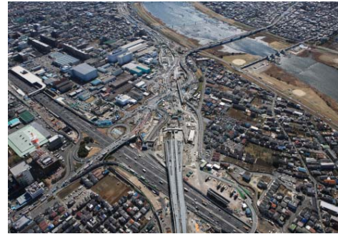
写真②:京葉JCT付近
