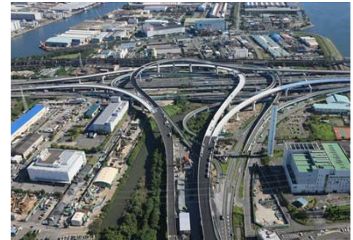
進捗状況：橋梁架設完了 舗装施工中
