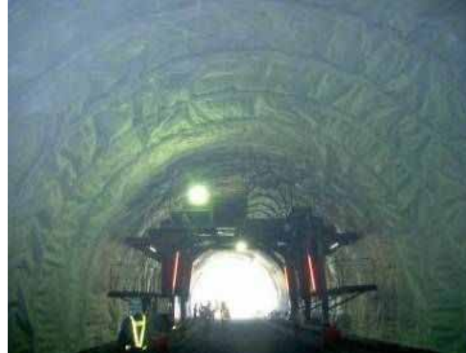
【防水シート取付】
