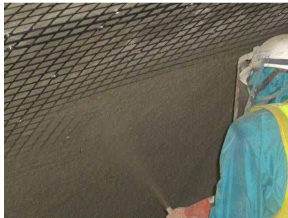
【ポリマーセメントモルタル吹付け状況】
