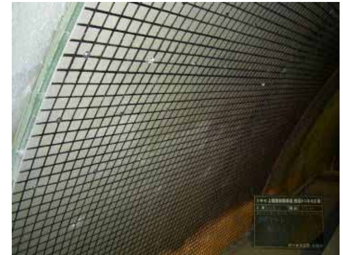
【FRPグリッド取付】
