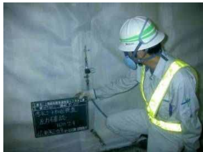
【防水シート溶着部検査】
