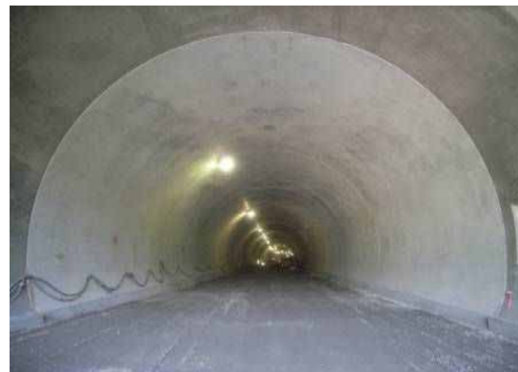
【覆工コンクリート再施工】
