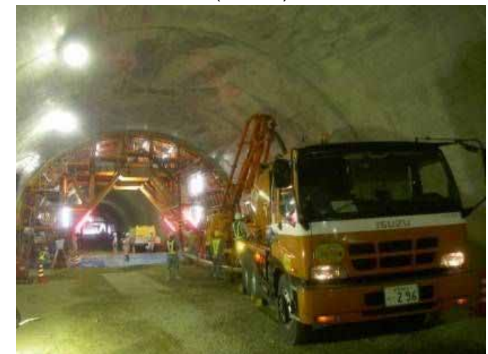
【コンクリート打設 (高強度)】
