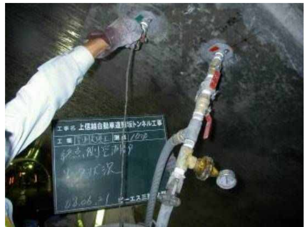
【空隙充填完了】
