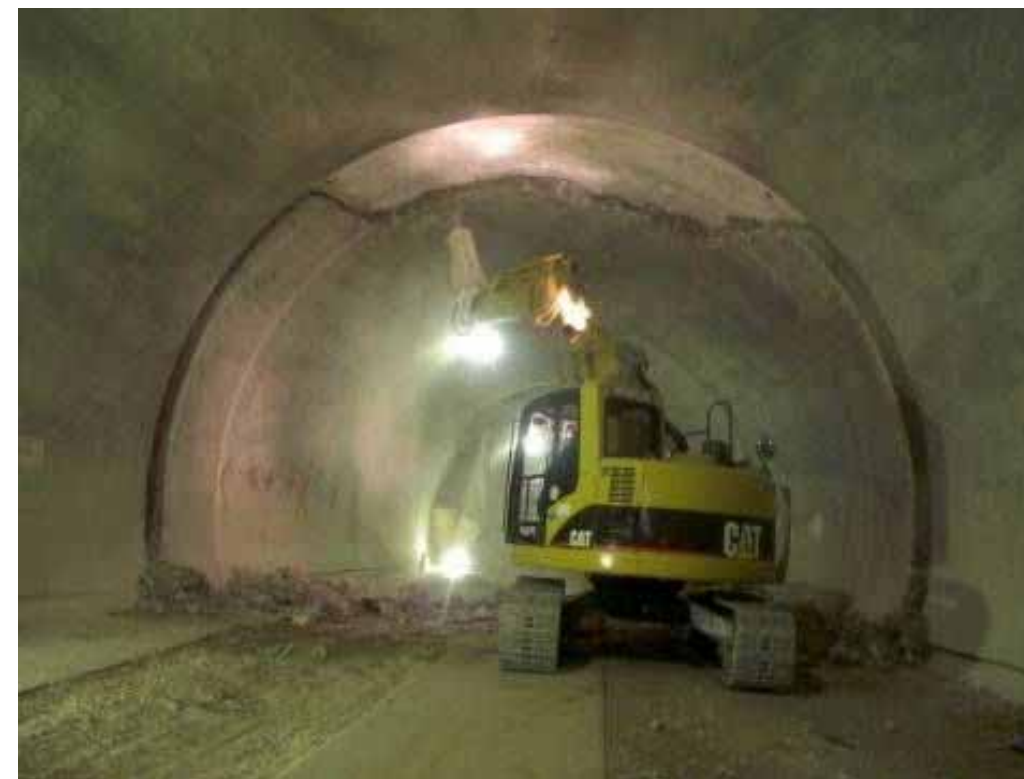
【覆工コンクリート取壊し】
