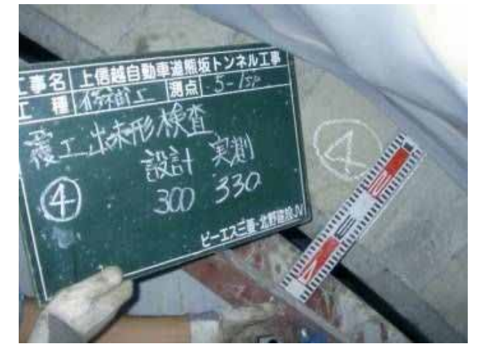
【覆工厚出来形検査】
