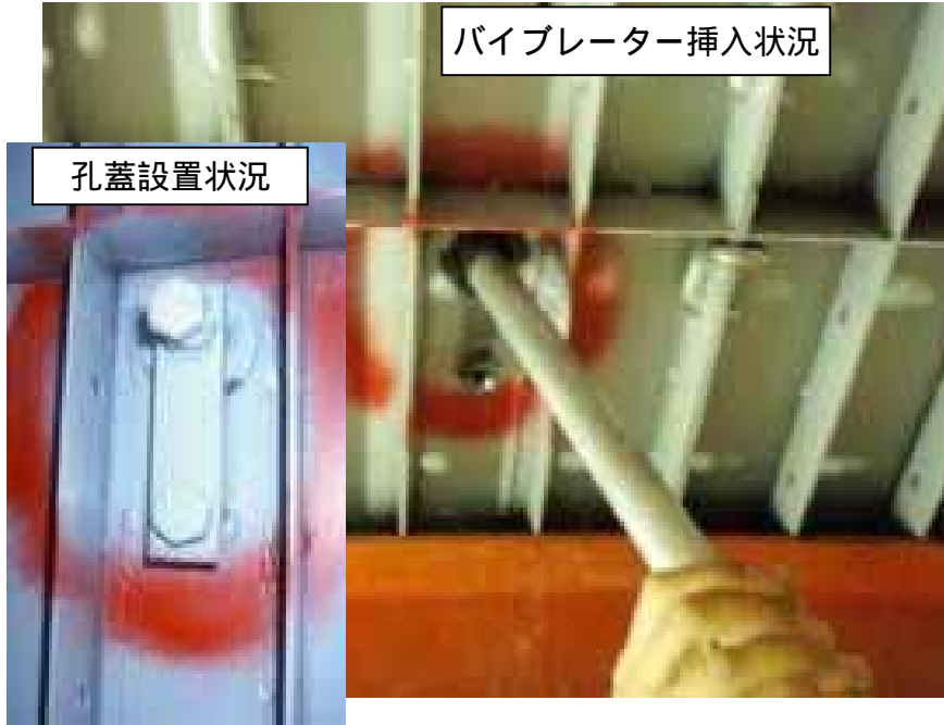
1)- バイブレーター挿入孔の追加
