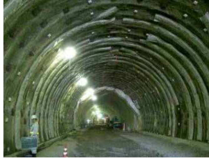
【既設防水シート撤去・下地処理完了】
