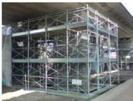
《施工状況》 道央道 大谷地高架橋
