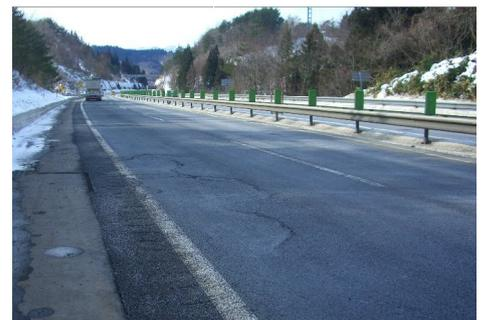
凍上による路面損傷 (八戸道)
