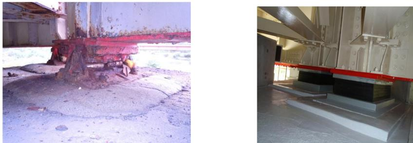
支承の腐食部の補修
