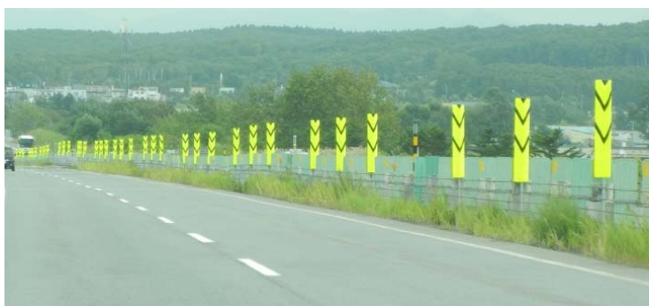
施工例:アイマーク
