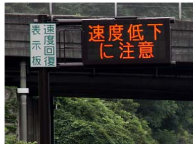
【NEXCO 東日本管内 設置箇所】
