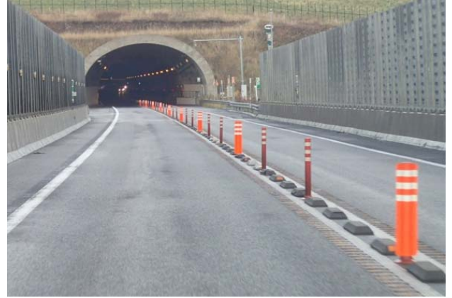
暫定 2 車線区間の車ラバーポール強化
