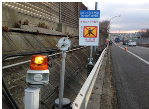
赤外線カメラで自転車や歩行者を識別する取組み
