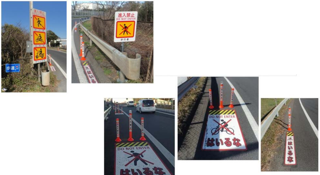
【IC 入口部の路肩に設置した進入禁止ポール、進入禁止看板、通行禁止路面標示】
