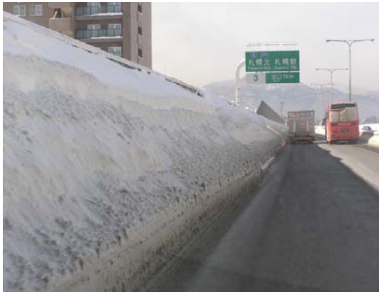
【路肩に溜まった雪堤の状況】
