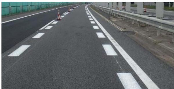
【導流レーンマーク】
