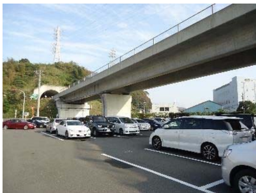
【横浜横須賀道路高架下(駐車場として活用)】
