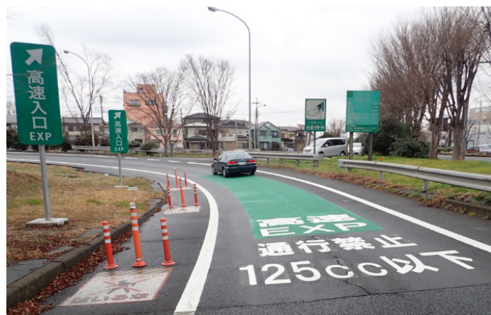
【IC 入口部の路面標示等による注意喚起】
