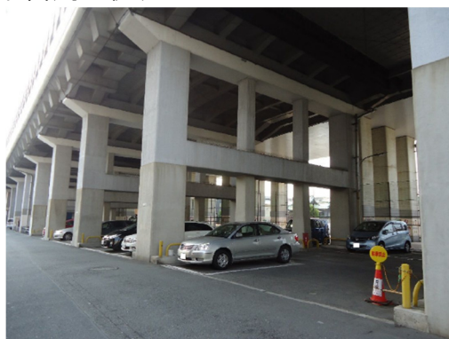
【横浜新道高架下（駐車場の活用例）】
