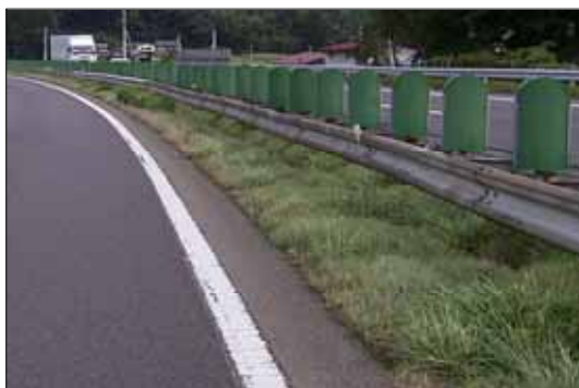
《中分防護柵（整備前）》
