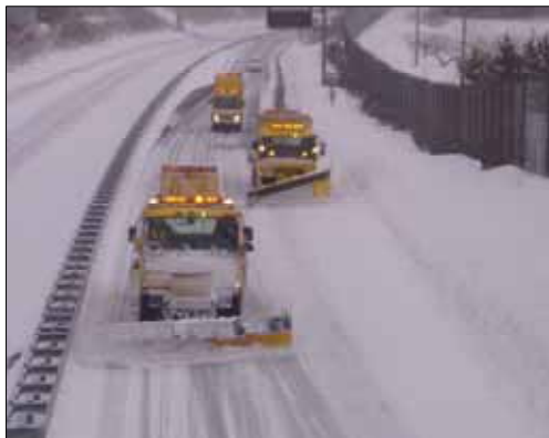
《除雪作業状況》
