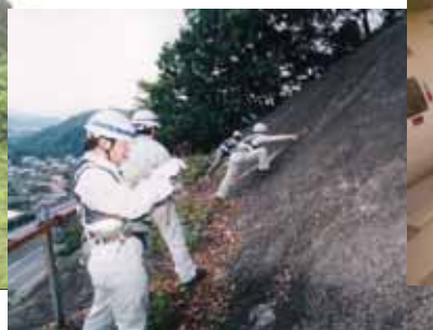
《のり面の点検》
