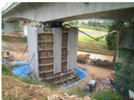
《橋脚耐震補強工事の状況》
