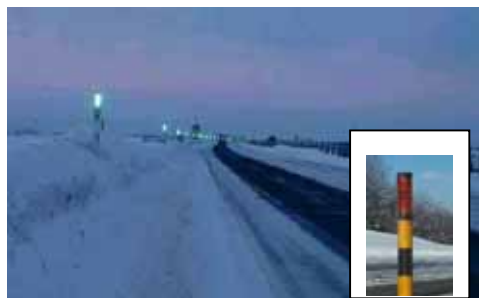
従来舗装 高機能舗装 冬期走行支援としての自発光スノーポール
