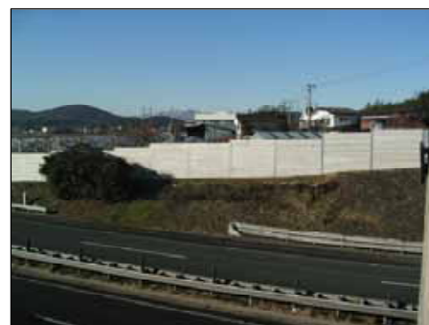
《遮音壁設置状況》
