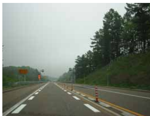
《導流レーンマーク》
