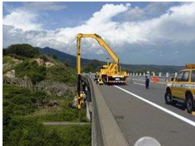
《橋梁の点検》道央道 登別室蘭IC～登別東IC間
