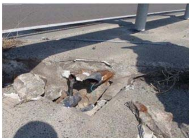
【道路付属物(照明損傷)】 東関東道 水戸大洗～ひたちなか 仙台東部道路 仙台北～仙台港北
