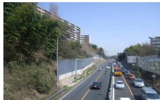
《遮音壁設置状況》 横浜新道 (川上IC～終点)
