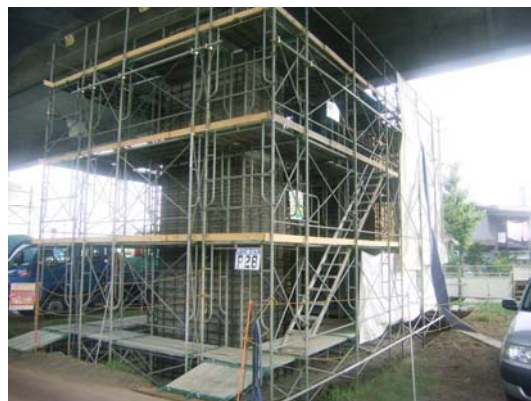
《施工状況》 道央道 白石高架橋
