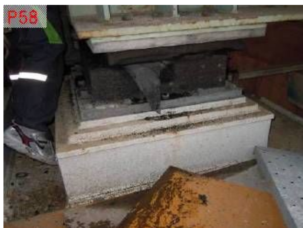
【橋梁損傷(ゴム支承・対傾構の損傷)】 仙台東部道路 東部高架橋
