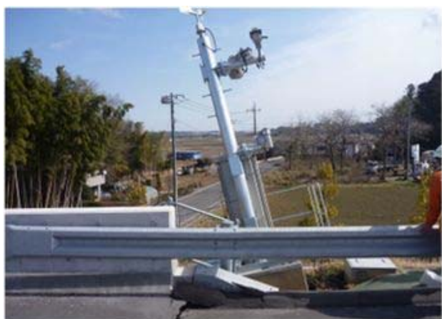
【道路付属物(照明損傷)】 東関東道 水戸大洗～ひたちなか 仙台東部道路 仙台北～仙台港北
