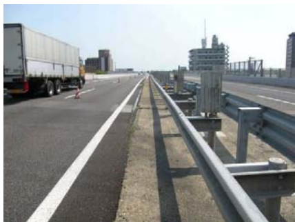
《中分防護柵(整備前)》
