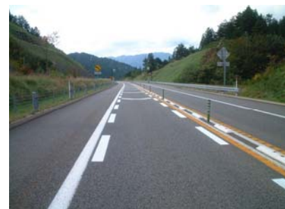
《速度抑制を促す導流レンマーク》
