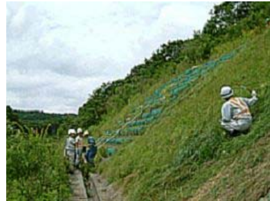
《のり面の点検》上信越道 吉井IC～富岡IC間
