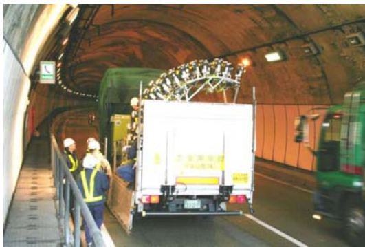
《計測状況》 長野道 一本松TN
