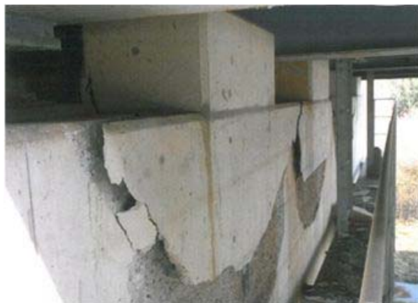
【橋梁損傷(ジョイント・落橋防止装置の損傷)】 東水戸道路 新那珂大橋、勝田高架橋
