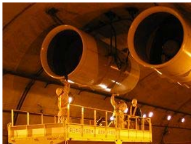
《トンネル換気設備の点検》富津館山道路 鋸山トンネル
