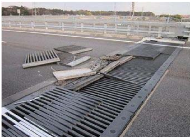
【橋梁損傷(ジョイント・落橋防止装置の損傷)】 東水戸道路 新那珂大橋、勝田高架橋
