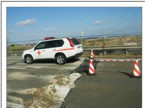
仮復旧の状況 合材による段差すりつけ
