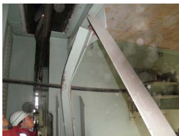
【橋梁損傷(ゴム支承・対傾構の損傷)】 仙台東部道路 東部高架橋
