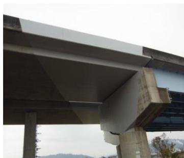
塩害損傷部の補修
