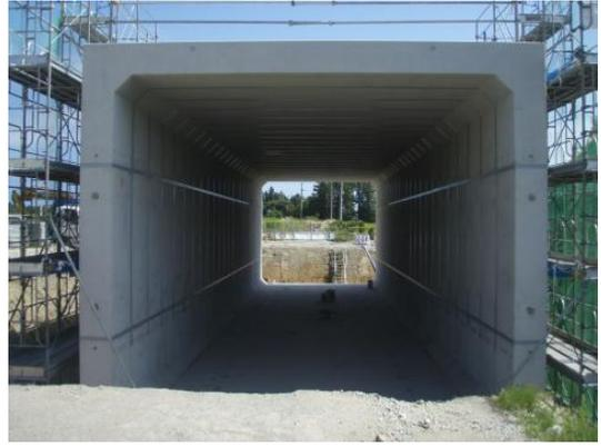
カルバートボックスの損傷補修(全面取替)
