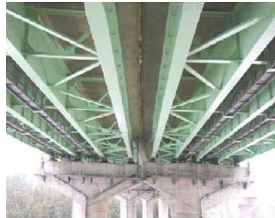
塗装劣化部の塗替塗装 山形道 宮城川崎 IC～笹谷 IC
