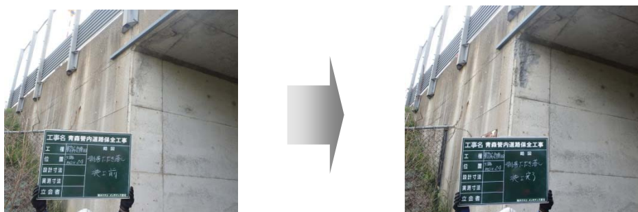
(土木)緊急対応が必要な損傷の補修状況
