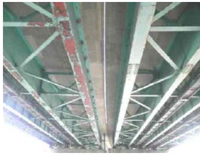
塗装劣化部の塗替塗装 山形道 宮城川崎 IC～笹谷 IC
