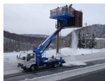
雪氷対策作業状況 (情報板雪落とし)
