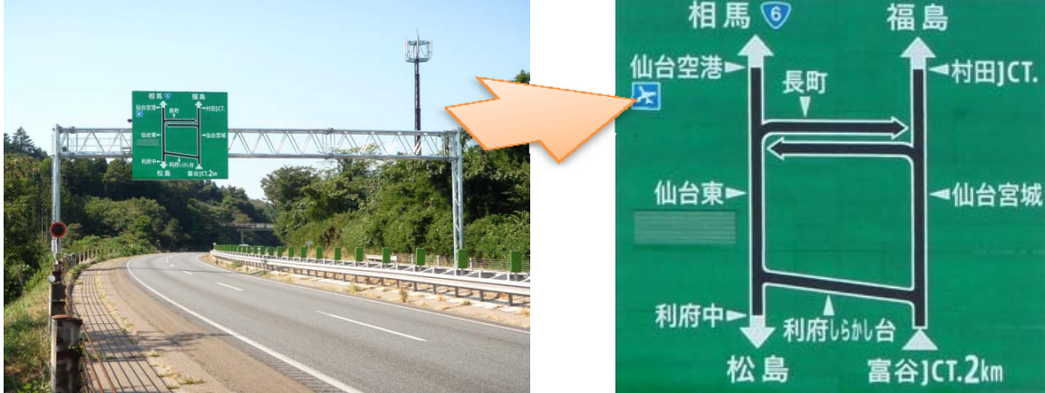
図形情報板(東北道(上り)富谷 JCT 付近)の運用状況
