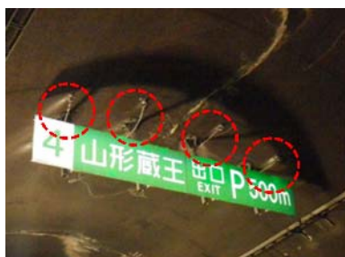
道路標識の第三者被害防止対策
