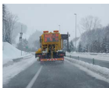
雪氷対策作業状況 (凍結防止剤散布)
