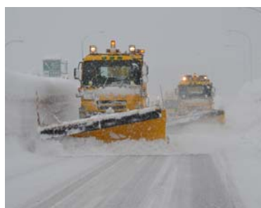
雪氷対策作業状況(除雪)
