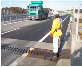
(土木)日常点検
