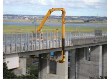
(土木)詳細点検
