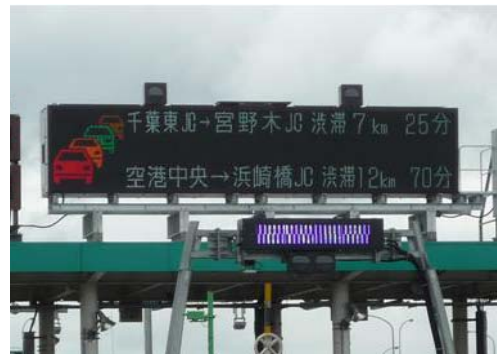
可変式道路情報板の更新
