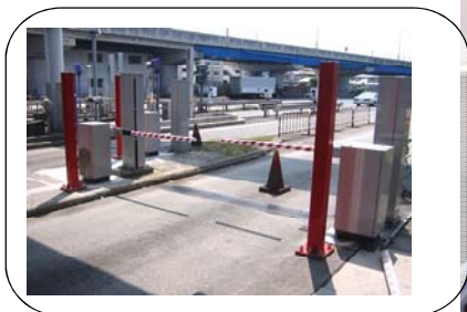
【一般レーンへのバー設置】
