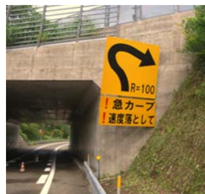
急カーブ注意喚起看板(6か所設置)
