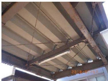
駐車场上屋塗装劣化部の塗装塗替
