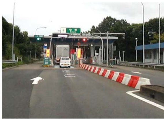
【料金所プラザ部締切対策】
