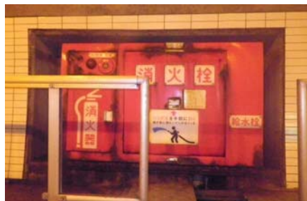
トンネル非常用設備劣化部の取替
