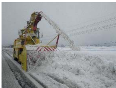
【雪氷対策作業状況(路肩除雪)】
