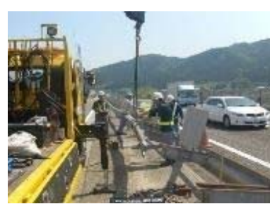
【緊急作業及び事故復旧作業状況】
