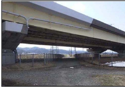
塗装劣化部の塗替塗装
