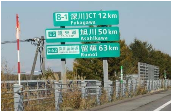
【確認標識の対応例(道央道 深川 JCT 手前)】
