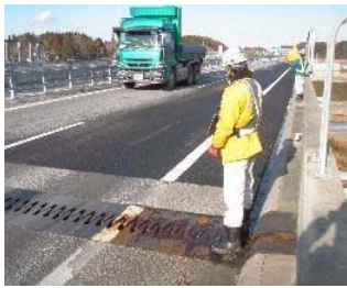
【(土木)日常点検】
