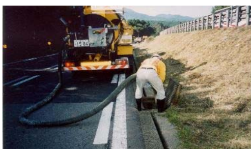
【排水設備清掃状況】
