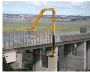
【(土木)詳細点検】
