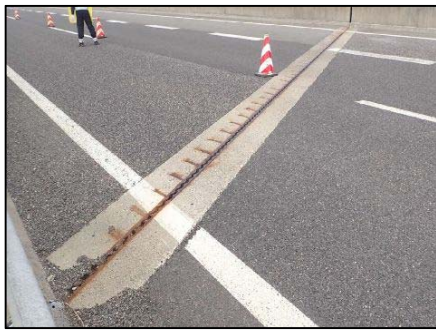
伸縮装置の取替
