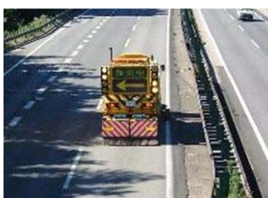
【路面清掃状況】
