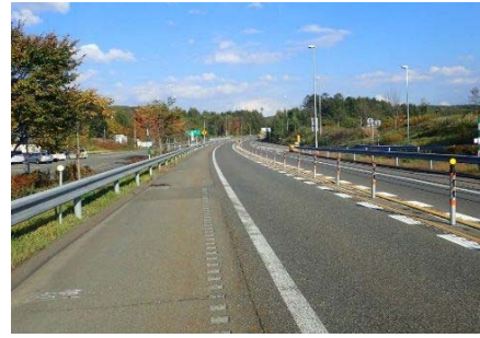
【施工事例(道東道 音更帯広 IC～池田 IC)】
