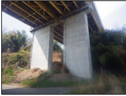
下部工損傷部の補修
