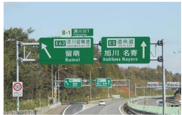
【JCT 案内標識の対応例(道央道 深川 JCT 手前)】
