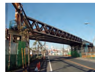
産業道路上に設置された工事用仮橋
