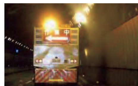
高速清掃車（時速50km）でのトンネル照明清掃
