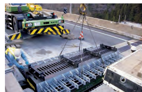
伸縮装置の取り替え
