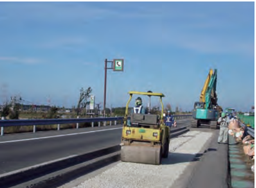
沈下対策に使用した軽量骨材(廃ガラスを用いたリサイクル材)
