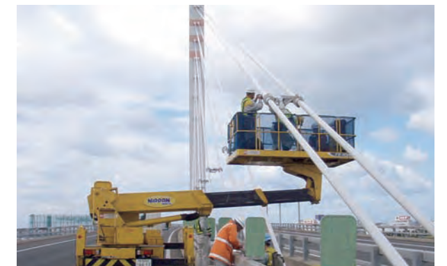
斜張橋のケーブル点検
