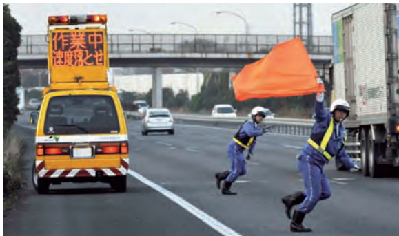
落下物の処理作業
