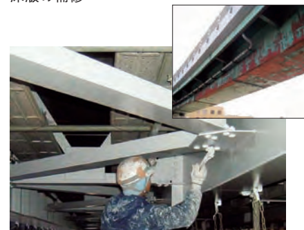
橋梁の塗り替え塗装
