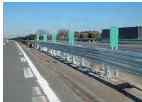
強化型防護柵(中央分離帯)
