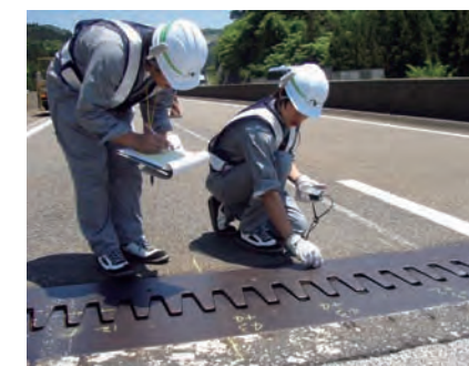
超音波による 橋梁ジョイントの健全度調査
