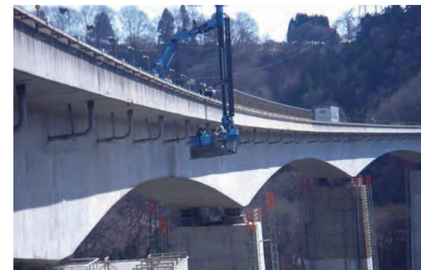
橋梁点検車による点検
