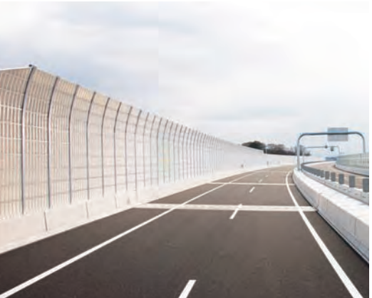
遮音壁の設置（圏央道）
