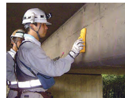
超音波による 内部鉄筋の健全度調査
