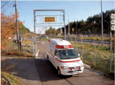
太平山PA 緊急入退出路
