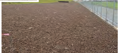
建設現場に敷設(防草対策)
