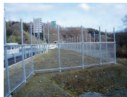
動物侵入防止柵の改良（かさ上げ）
