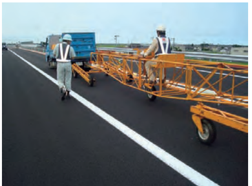
舗装路面の平坦性確認試験
