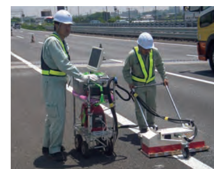
電磁波による 橋梁床版の劣化度調査（試行中）
