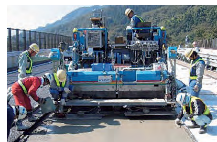
舗装の打ち替え
