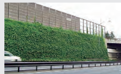
道路の壁面緑化 (京葉道路)
