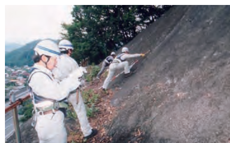
のり面の点検
