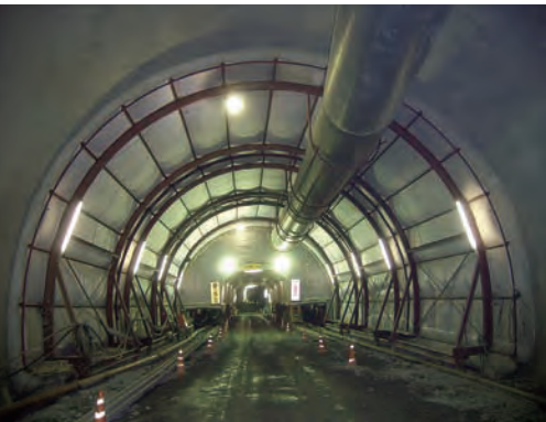
入札前の技術提案(コンクリートの養生方法)を採用した工事
