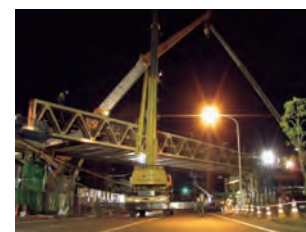
工事用仮橋の設置工事は夜間行いました。
