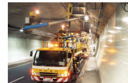
トンネル設備の保守作業
