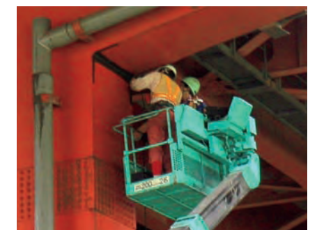
超音波による 鋼製橋脚の健全度調査
