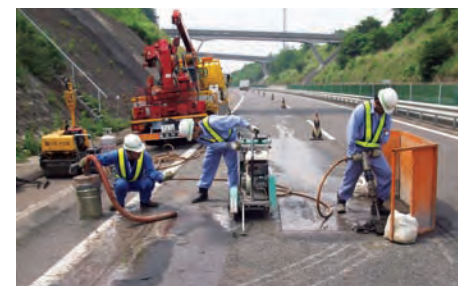
路面に生じた小穴（ポットホール）の補修
