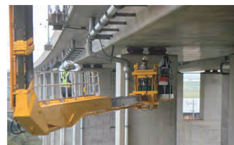
橋梁点検車による点検
