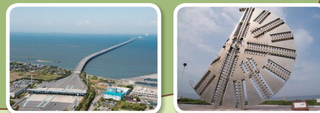
東京湾アクアラインは、平成9年に開通した東京湾を横断する全長15kmの道路だよ。4.4kmが橋で、残りの9.5kmが海底トンネルになっているよ。建設には、世界最大級の大きさのシールドマシンが使われたんだ。海ほたるPAでは、当時実際に使われたシールドマシンの地面を掘っていた部分(カッターフェイス)を復元したものが飾ってあるんだ。立ち寄った時にはぜひ見てみてね！
