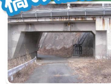
左の写真の橋は、長年の雨や雪などにさらされて橋の表面がボロボロになってしまった状態。ボロボロになったところを直し、表面に特殊な素材を塗ってきれいにしたよ
