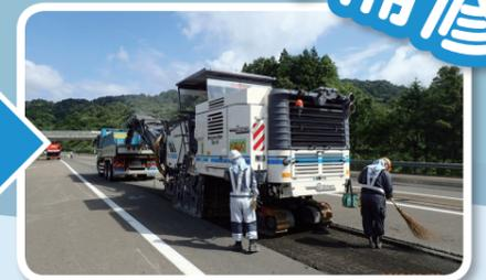
切削機という機械でアスファルトを削る
