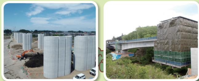
桁式の橋は、大きく分けると、橋の土台となる橋脚と、その上に架ける橋桁に分かれるよ。桁橋を造るには、まず橋脚を作り、それから橋桁を造っていくんだ。橋脚から左右に橋桁を伸ばすように造っていく方法と、工場であらかじめ造った橋桁を橋脚に乗せる方法があるんだよ。
