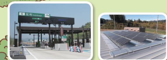
さいきん最近の料金所では、エコにも力を入れているんだ。電気の消費が少ないLEDを使ったり、ソーラーパネルが設置されていて発電できる料金所もあるんだよ。
