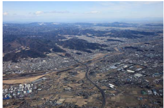
北関東道(太田桐生から栃木県側を望む)
