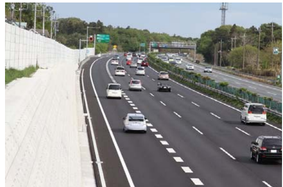
関越道花園IC付近(上り)付加車線
