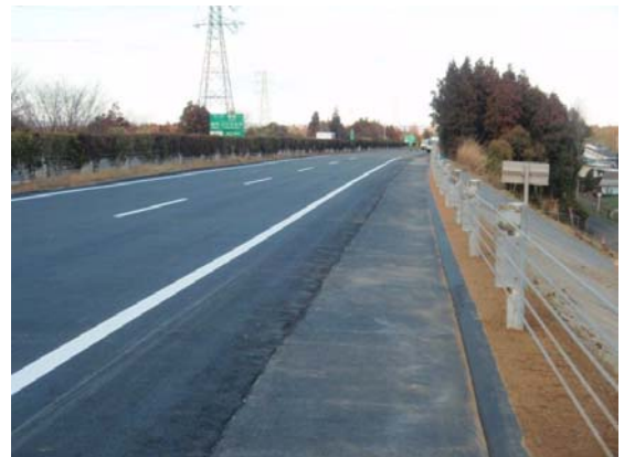
応急復旧後の状況 (3月17日)
