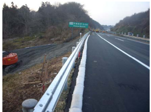
応急復旧後の状況 (4月10日)
