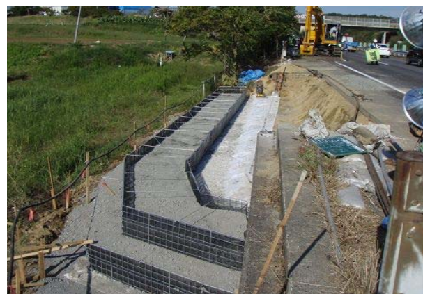
盛土復旧工事の状況(東北道)
