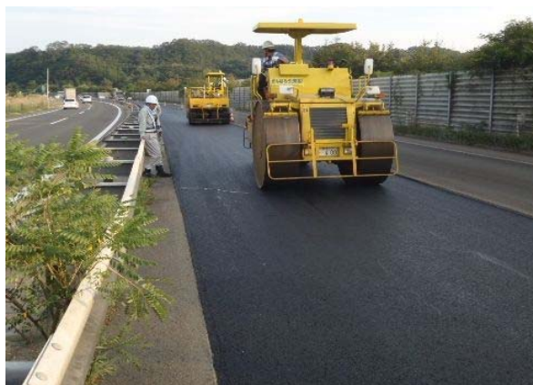
舗装復旧工事の状況(山形道)
