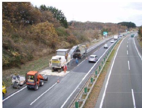
東北道(宮城県大崎市)舗装本復旧工事
