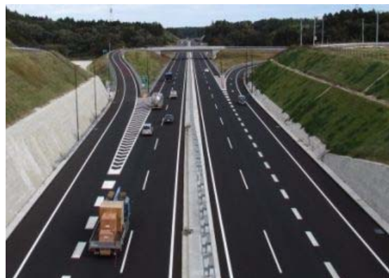
開通後の様子(茂原北 IC 付近)
