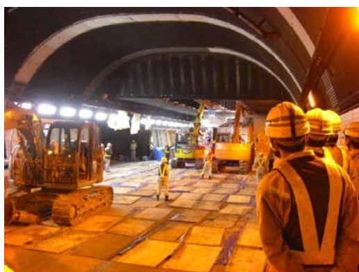
撤去の状況(関越道 関越トンネル)
