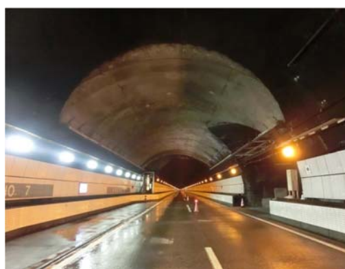
撤去後(関越道 関越トンネル)
