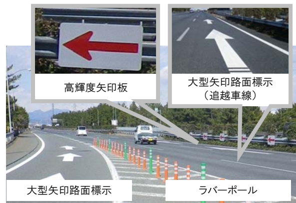
本線合流部の対策事例(関越道 高崎IC)
