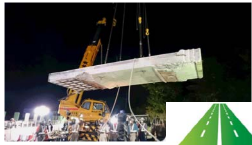
高速道路リニューアルプロジェクト ～床版取替工事(東北道)～
