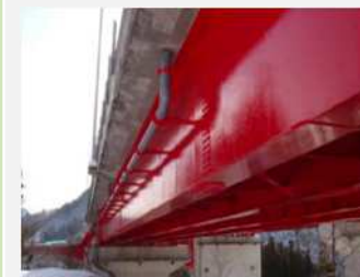
鋼桁塗装（塗替塗装）
