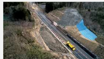
常磐道 切土のり面崩落箇所 応急復旧
