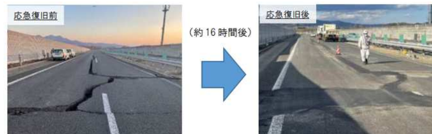
東北道 国見IC～白石ICにおける被災箇所への応急復旧状況（2022年3月 福島県沖地震）
