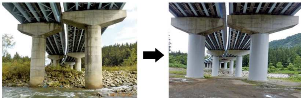
橋脚の耐震補強状況
