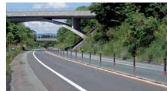
暫定2車線区間におけるワイヤロープ設置
