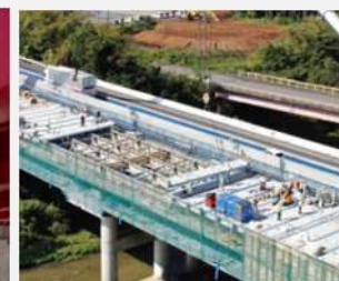
橋梁の床版の修繕
