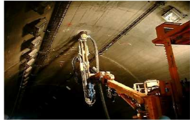
覆工背面空洞注入対策状況
