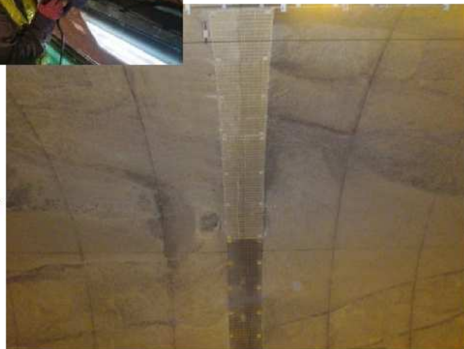
対策状況(目地部はく落対策)
