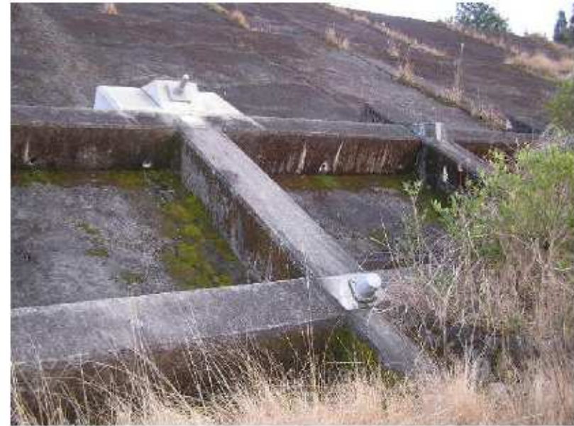
アンカー増打ちなど補強アンカー
