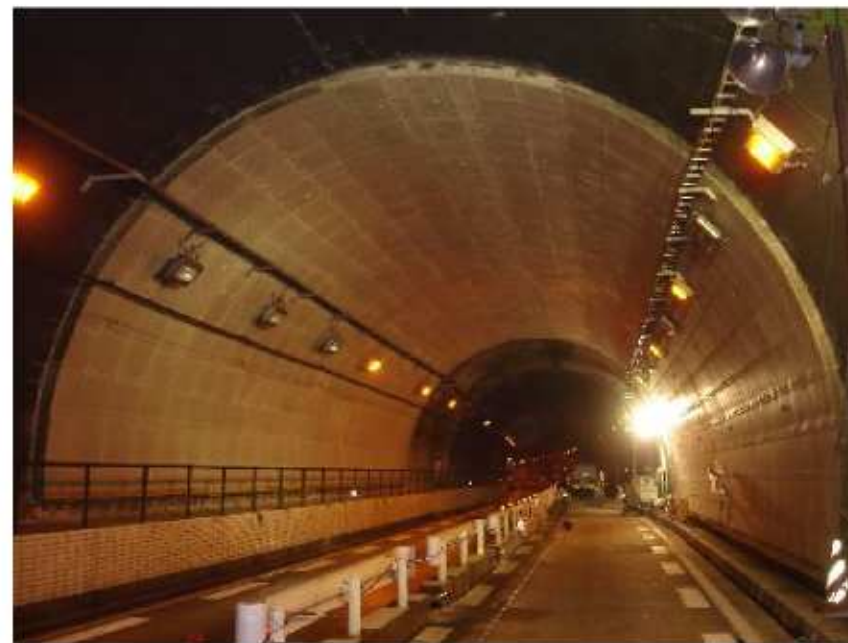
内面補強対策工による対策状況
