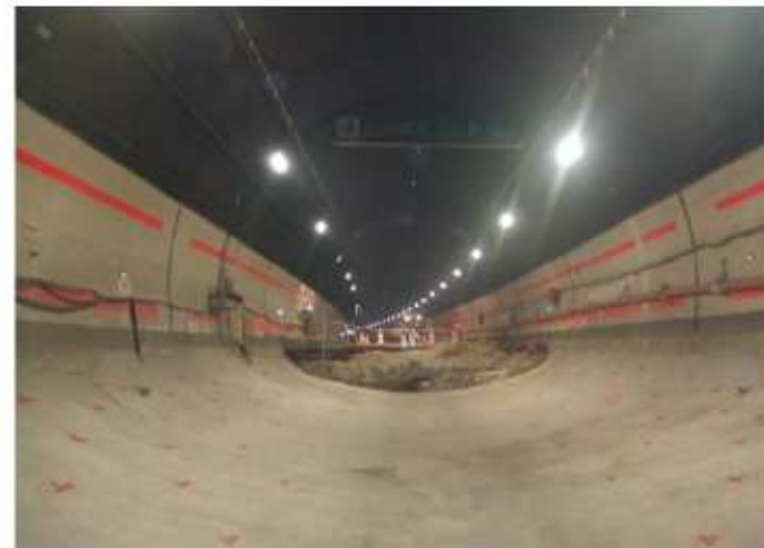
インバート設置による対策状況
