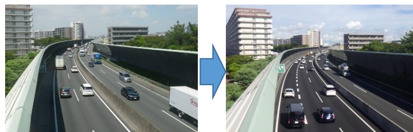
付加車線の設置 (E14京葉道路(上り)武石IC→船橋IC)
