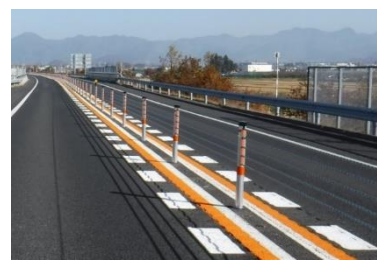
暫定2車線区間の安全対策の推進 (ワイヤロープの設置)
