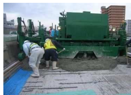
床版上面の 増厚コンクリートの打設
