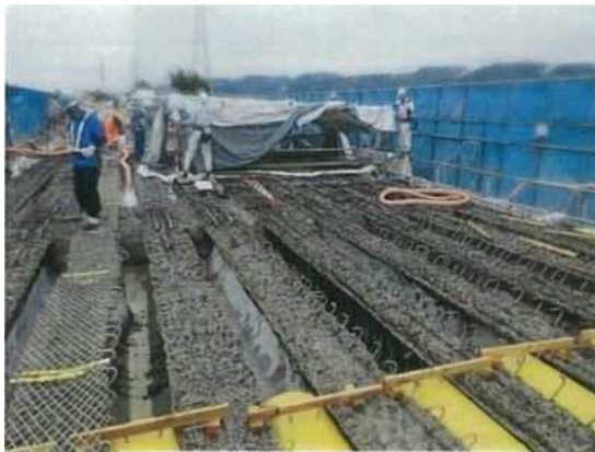
全面的な上面補修
