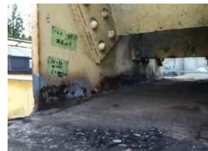
下弦材格点部のガセットの腐食（滞水の影響）
