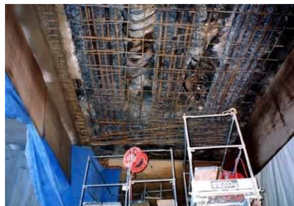
全面的な下面補修
