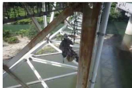
ロープアクセスによる近接点検
