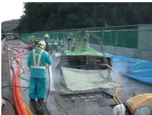
ウォータージェット工法 によるはつり作業
