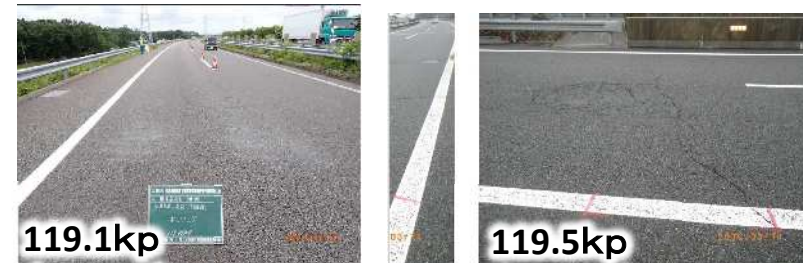
ポンピングや亀甲状のひび割れ発生 部分打換工実施
