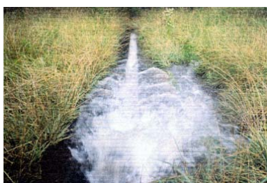
図 4.4.9 排水溝の溢水
