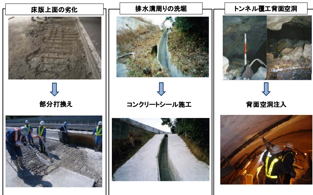
図 2.4.2 代表的な補修事例
