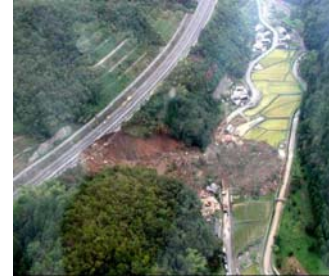
(のり面災害状況)
