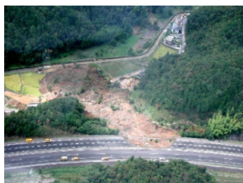
図 4.4.8 異常降雨に伴う崩壊
