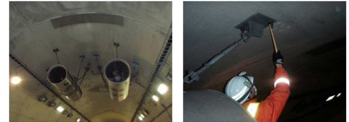
●ジェットファンの点検状況 北関東道 唐沢山城跡トンネル(上り線)
