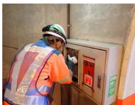
トンネル非常電話設備点検実施状況写真
