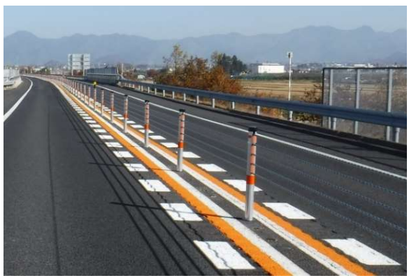
・ワイヤロープ設置区間における効果 設置後の正面衝突死亡事故 0件 (H29～R5年度)
