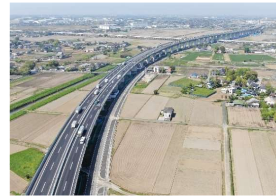
圏央道の4車線化(久喜白岡JCT～幸手IC間)
