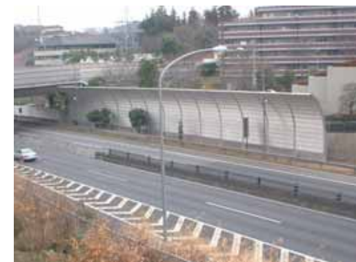
《遮音壁の設置》
