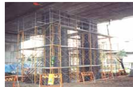
《橋脚の耐震補強》
