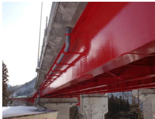
鋼桁の塗替塗装
