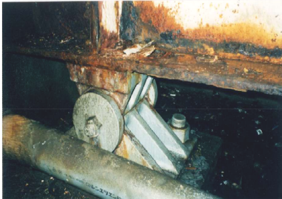
鋼桁の劣化
