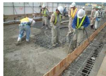
床版上面の部分打替
