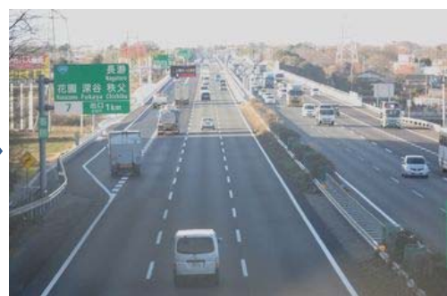
運用後(平成30年12月撮影)
