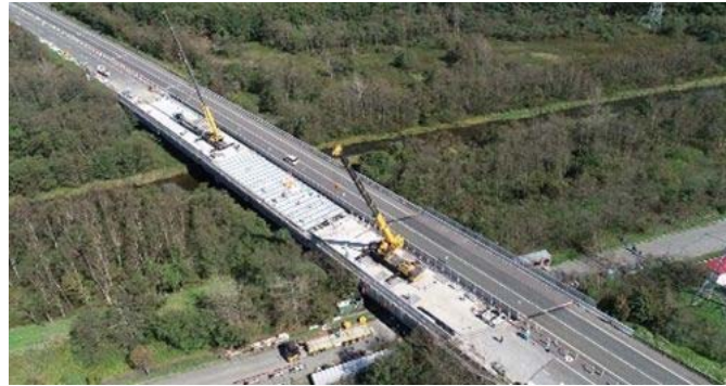
道央道 ゆうふつがわ 勇払川橋床版取替工事
