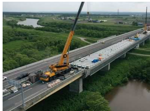
道央道 千歳川大橋床版取替工事
