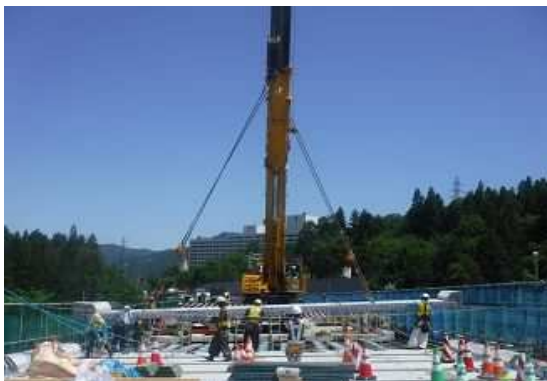
関越道 松川橋床版取替工事
