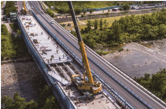
橋梁リニューアル工事(例)
