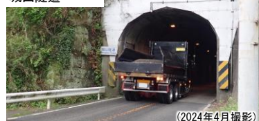
(2024年4月撮影) 狭隘トンネルを通過する大型車
