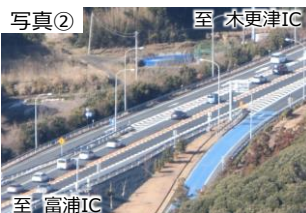
暫定2車線区間における渋滞(富津金谷IC付近)
