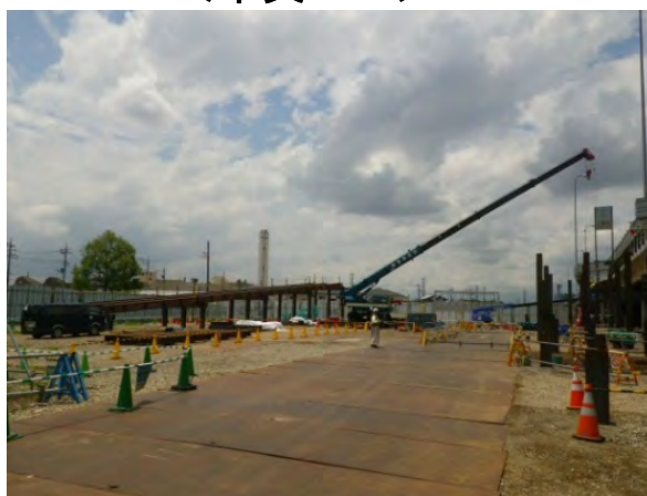
中央道へ出入りする工事用仮橋などを施工中 ※③
