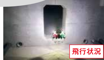
実証例：箱桁内部の点検
