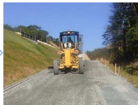
簡易舗装路盤工
