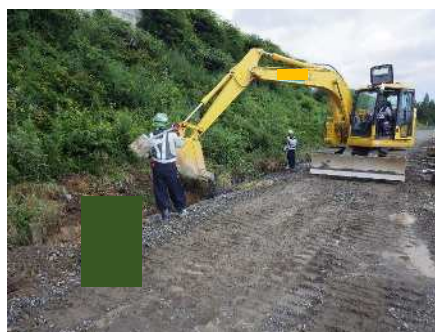
掘削・整正（床付）
