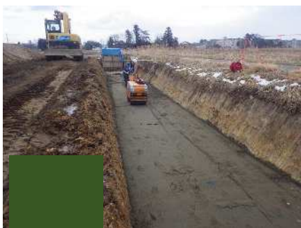
基礎材敷均し・締固め
