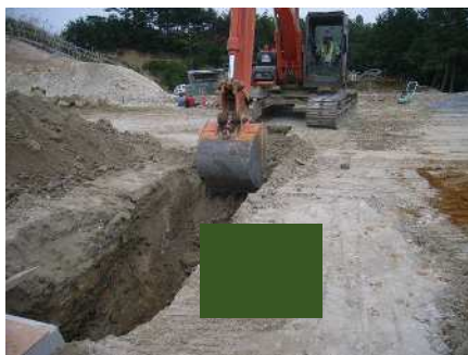
掘削・整正（床付）
