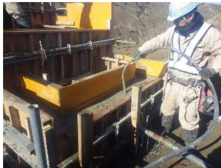
コンクリート打設
