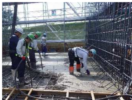
底版コンクリート打設
