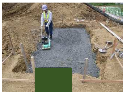
基礎材敷均し・締固め
