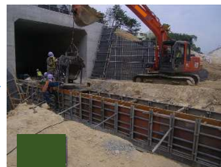
コンクリート打設
