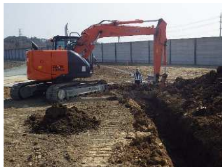
掘削・整正（床付）
