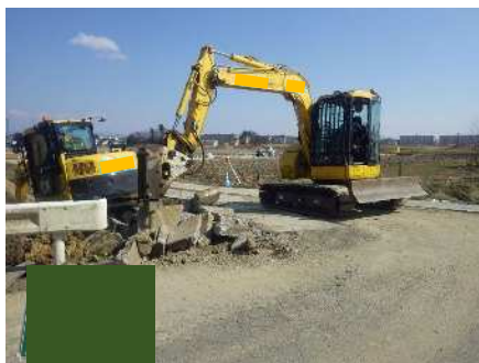
取壊し（大型ブレーカ）
