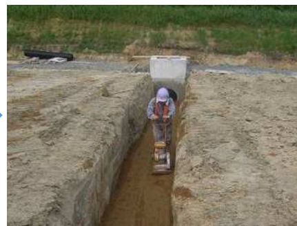
基礎材敷均し・締固め
