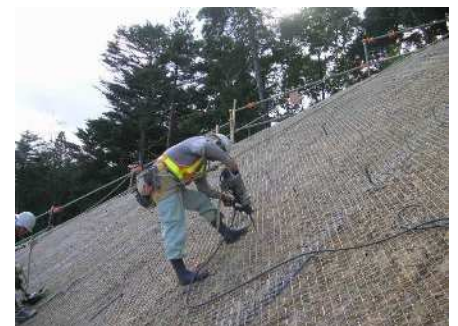
アンカーピン設置
