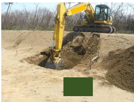
掘削・整正（床付）
