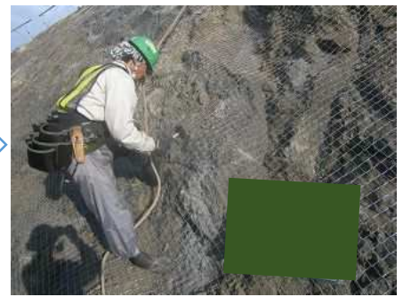
アンカーピン設置
