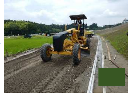
簡易舗装路盤工
