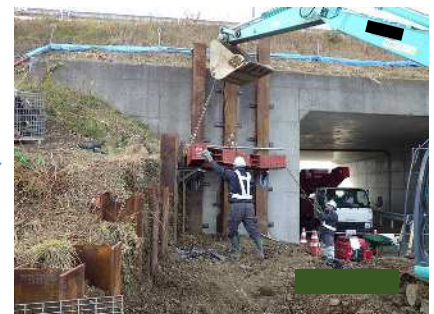
鋼製山留材設置
