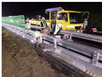
固定用アンカーピン打込み
