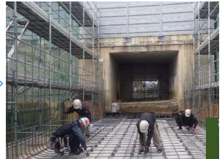
底版鉄筋加工・組立て
