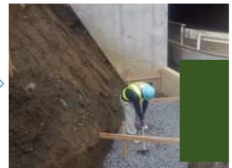
基礎材敷均し・締固め
