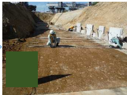
補強材設置
