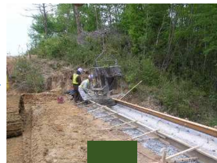
天端コンクリート打設
