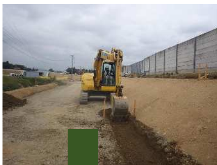
掘削・整正（床付）
