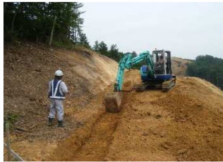
掘削・整正（床付）
