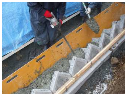
胴込め（※コンクリート打設の場合）
