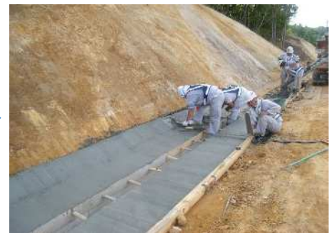
コンクリート打設
