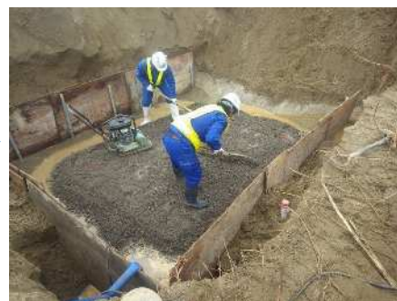
基礎材敷均し・締固め
