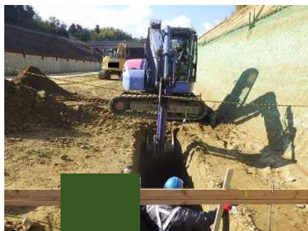
掘削・整正（床付）
