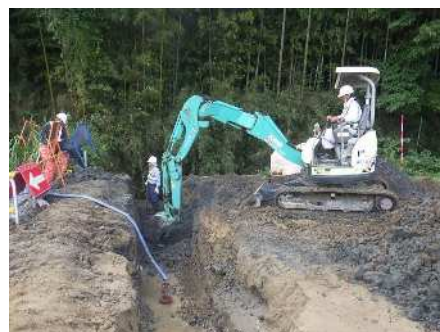
掘削・整正（床付）
