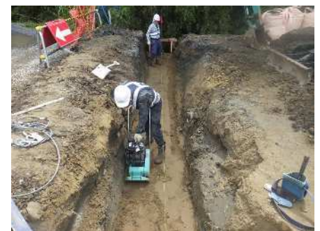
基礎材敷均し・締固め
