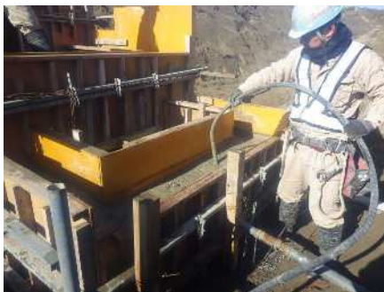
コンクリート打設
