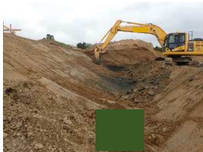
切土のり面仕上げ（土砂）
