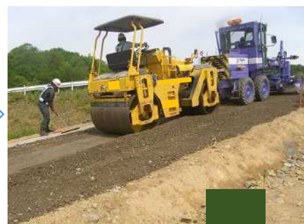
簡易舗装路盤工 (転圧)
