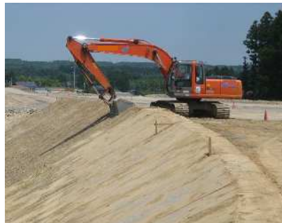
盛土のり面仕上げ（削取り）
