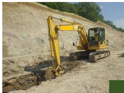
掘削・整正（床付）
