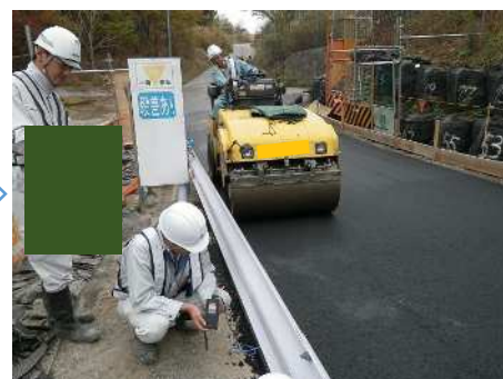
簡易舗装工 (締めめ)
