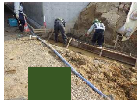
コンクリート打設
