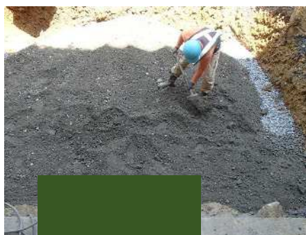
基礎材敷均し・締固め
