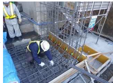
底板鉄筋加工・組立て
