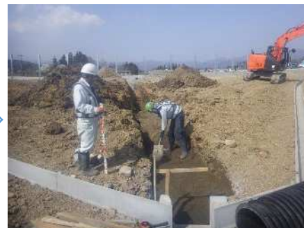
基礎材敷均し・締固め
