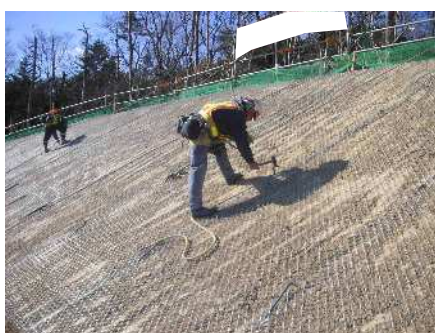
アンカーピン設置
