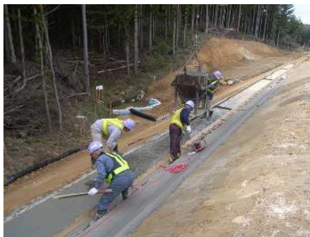
コンクリート打設
