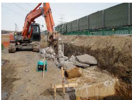
取壊し（大型ブレーカ）
