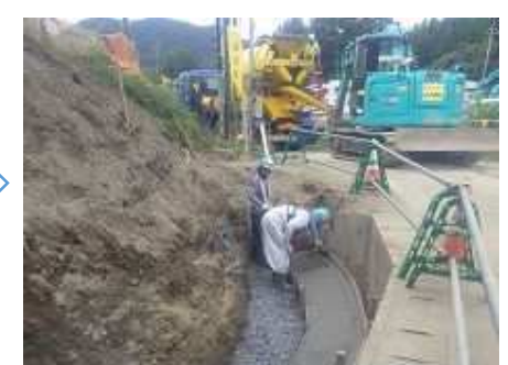
コンクリート打設
