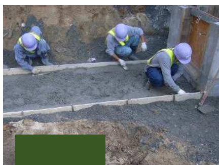
均しコンクリート打設
