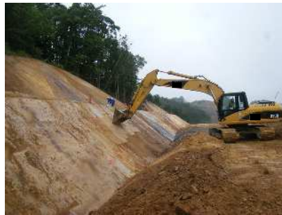
切土のり面仕上げ（土砂）
