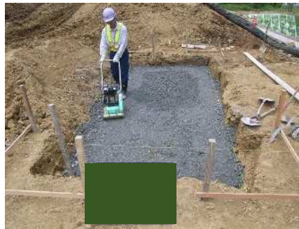
基礎材敷均し・締固め
