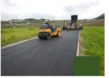
簡易舗装工（締固め）
