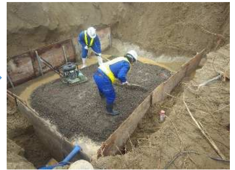
基礎材敷均し・締固め
