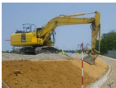
盛土のり面仕上げ（削取り）
