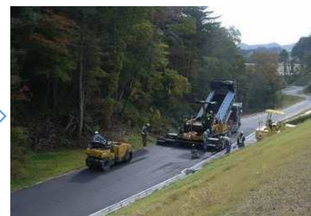
簡易舗装工（締固め）
