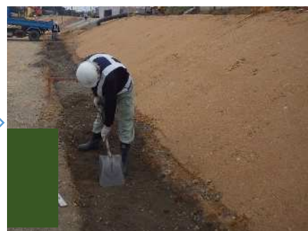
基礎材敷均し・締固め
