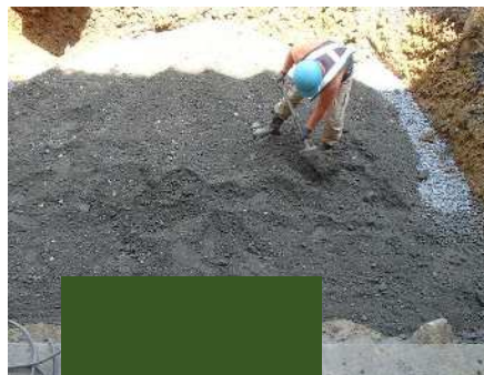
基礎材敷均し・締固め
