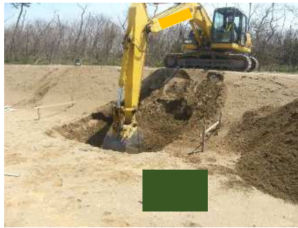
掘削・整正（床付）
