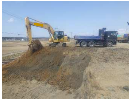
掘削・積み込み
