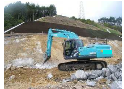
切土のり面仕上げ（硬岩）
