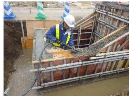
コンクリート打設
