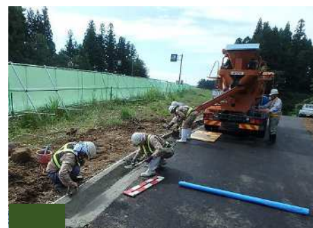
コンクリート打設
