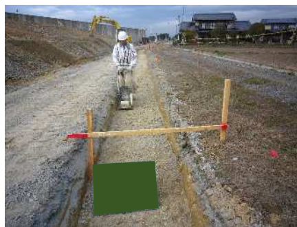
掘削・整正（床付）
