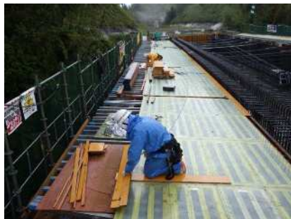
張出床版型枠設置
