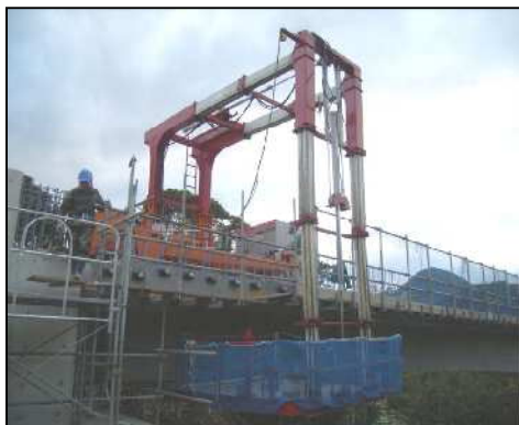
地 覆 高 欄 作 業 車
