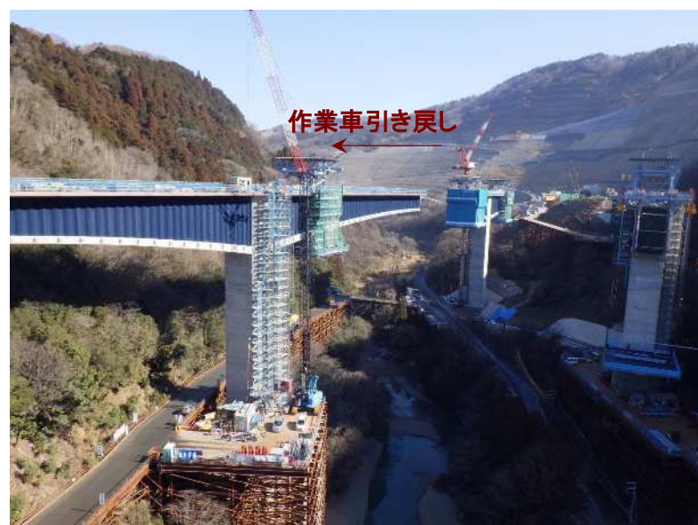
移動作業車後退・解体
