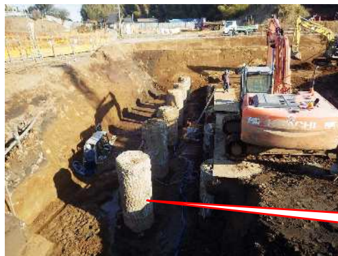
場所打ち杭 (杭頭処理前)
