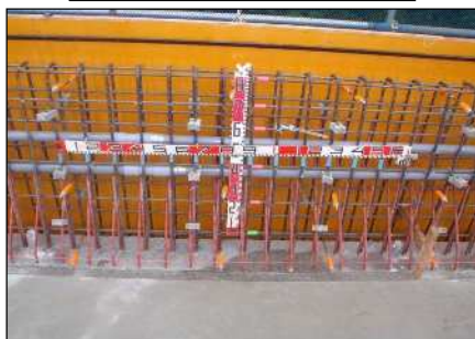
壁高欄コンクリート打設
