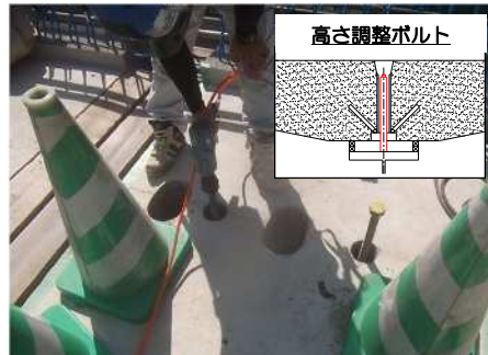
調整工（高さ調整ボルトによる）
