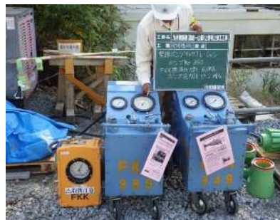
緊張ポンプキャリブレーション
