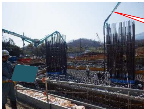
コンクリート工
