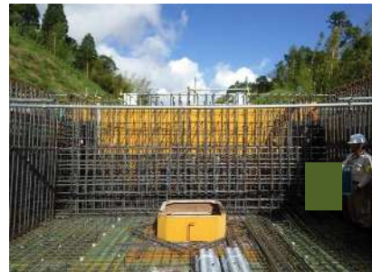
鉄筋・縦締め組立完了
