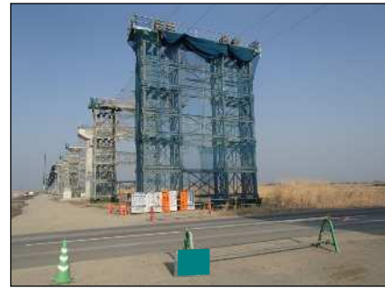
ベント設備組立完了
