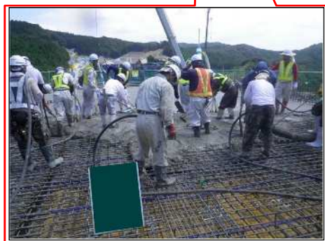
打設状況（上床版部）
