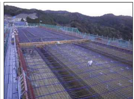
床版横締めケーブル配置完了
