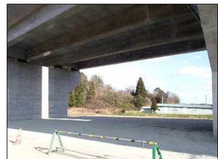
型枠支保工撤去完了
