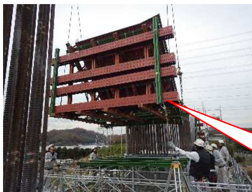
型枠工（底枠）
