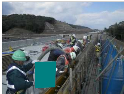
コンクリート打設
