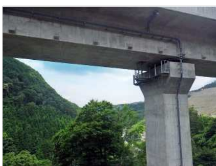
排水管（桁外）
