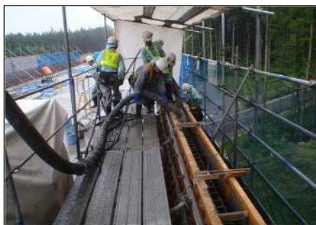
壁高欄コンクリート打設
