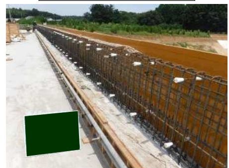
コンクリート打設(壁高欄)
