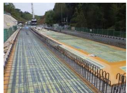
床版型枠設置完了
