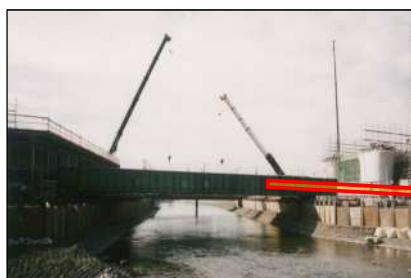
梁（架設桁）架設状況
