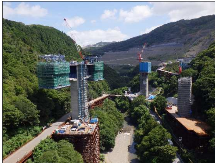
移動作業車移動
