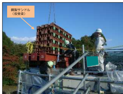
降下設備組立
