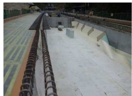
内型枠脱枠
