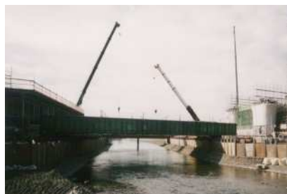
梁(架設桁)架設状況
