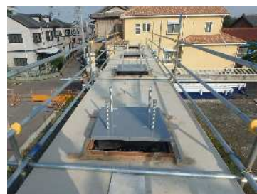
ゴム支保据付状況
