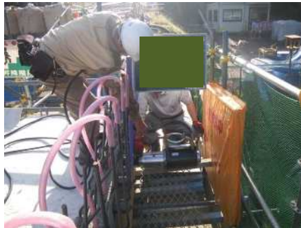
緊張状況(緊張側)
