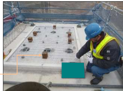
沓座鉄筋設置
