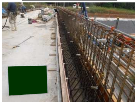
コンクリート打設(地覆)
