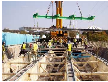
調整工（高さ調整ボルトによる）
