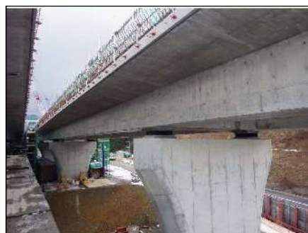
型枠支保工撤去完了
