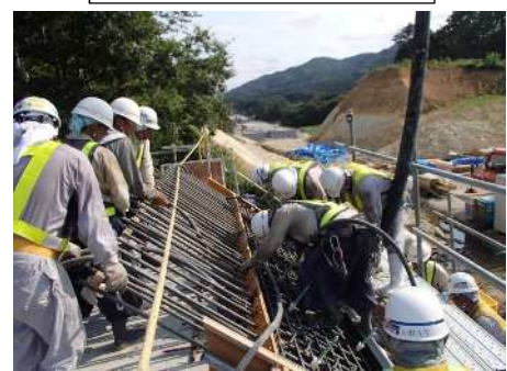
コンクリート打設
