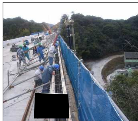
壁 高 欄 の 施 工
