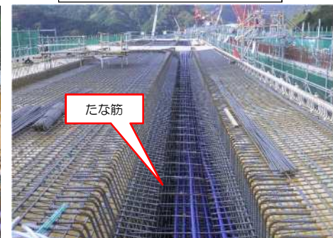
PCケーブル組立完了
