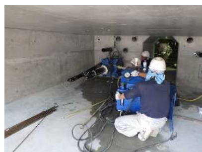
外ケーブル緊張状況
