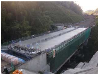
コンクリート打設完了
