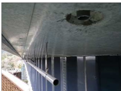
排水管（桁外）
