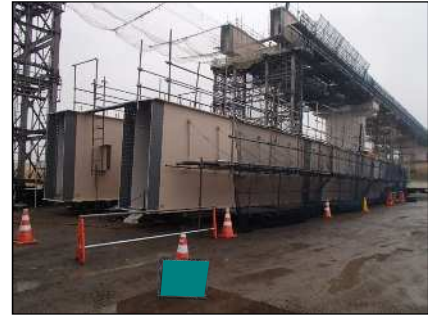
地組立（ボルト接合）
