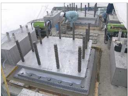
無収縮モルタル打設
