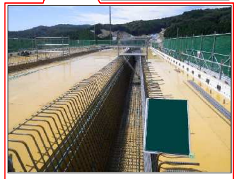
ウ ェ ブ 部 鉄 筋 組 立
