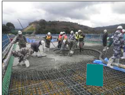
コンクリート打設
