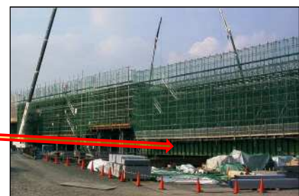
梁（架設桁）+くさび結合式支保工
