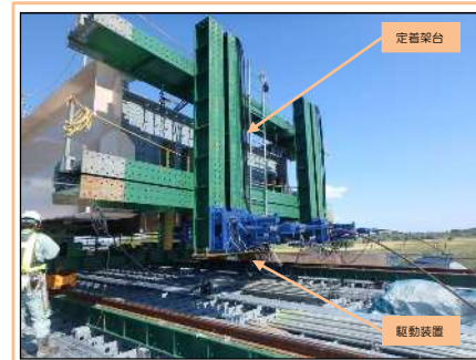
駆動装置・定着装置
