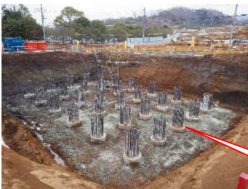
場所打ち杭 (杭頭処理後)
