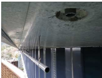
排水管（桁外）
