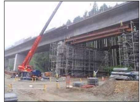
支保工撤去状況(参考例)
