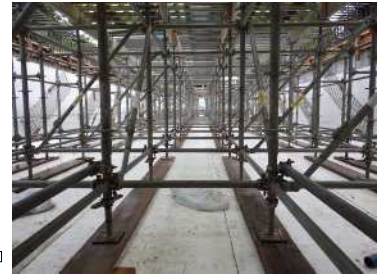
床版型枠設置完了
