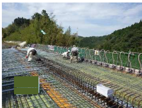
鉄筋・横締め設置状況
