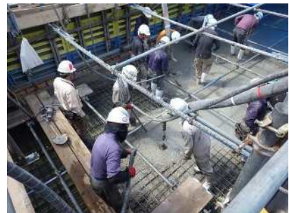
下床版コンクリート打設
