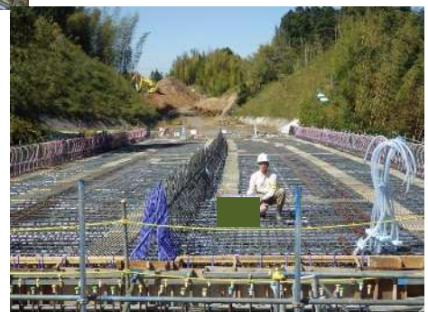
上床版打設前状況全景
