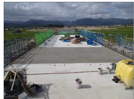
上床版コンクリート打設
