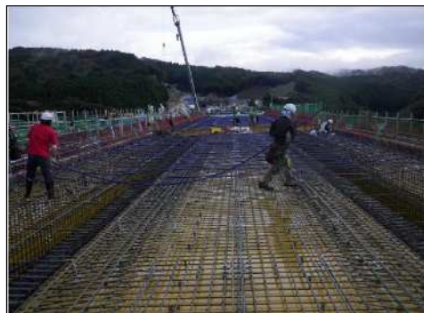
床版横締めケーブル配置状況
