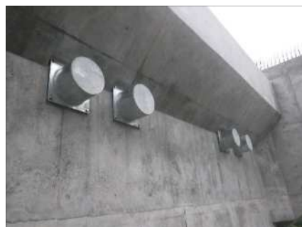
落橋防止構造 橋台側
