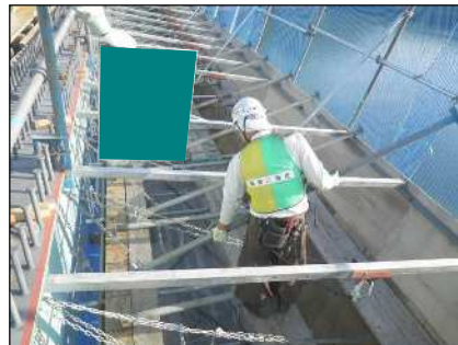
張 出 部 支 保 工
