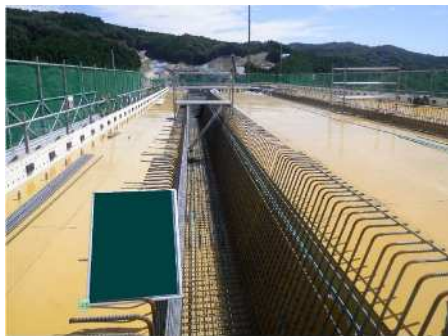
鉄筋組立作業状況
