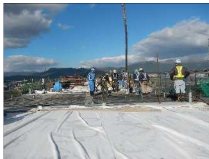
上床版コンクリート打設
