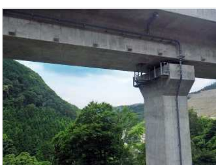
排水管（桁外）
