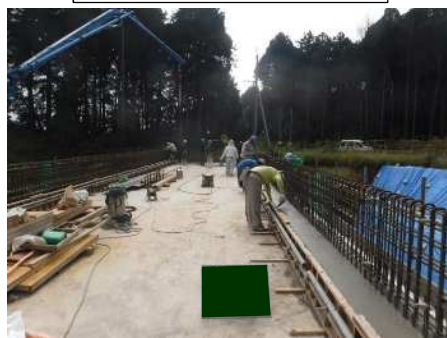
コンクリート打設(地覆)
