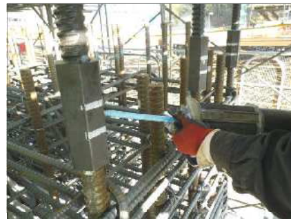
鉄筋継ぎ手
