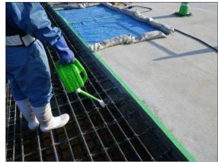
上床版コンクリート打設
