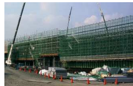
梁(架設桁)+くさび結合式支保工
