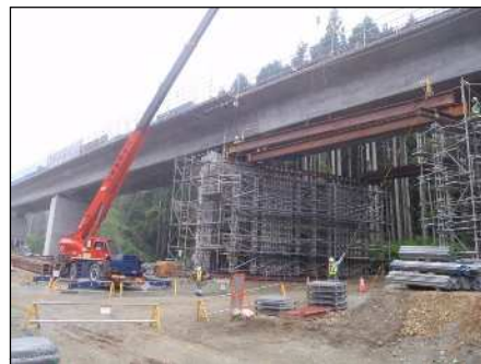
型枠支保工撤去完了
