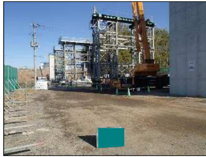
ベント設備組立
