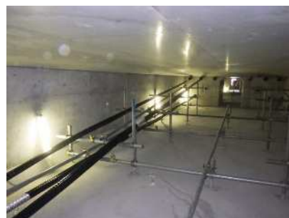
外ケーブル組立状況
