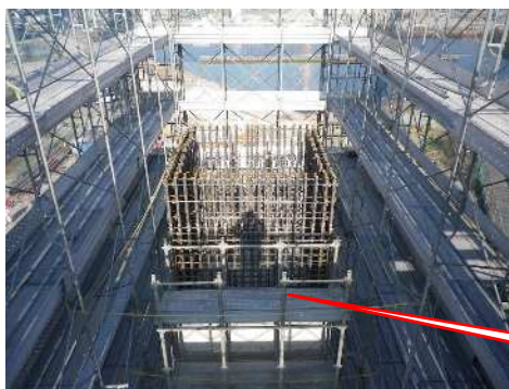
横梁用支保工（支柱式）
