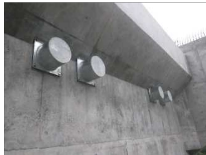
落橋防止構造 橋台側
