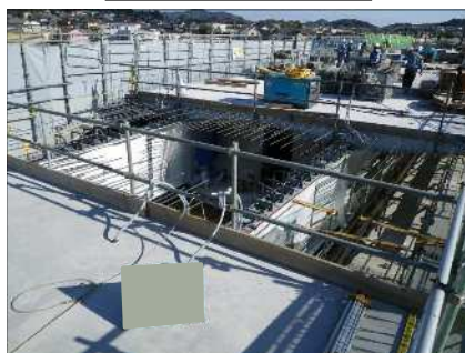
波形鋼板架設
