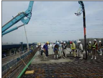
コンクリート打設
