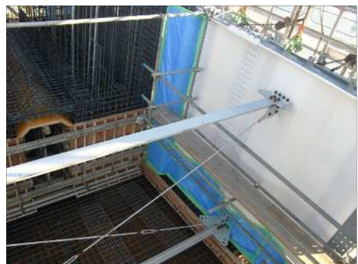
波形鋼板養生
