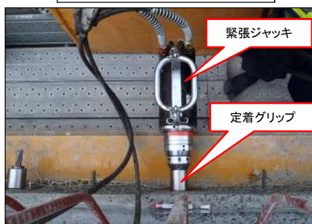
横 締 め 緊 張 状 況
