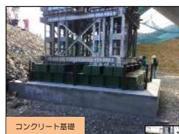
コンクリート基礎
