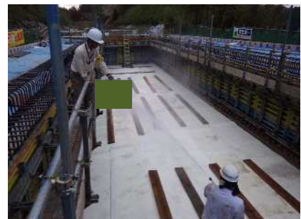
内型枠脱枠
