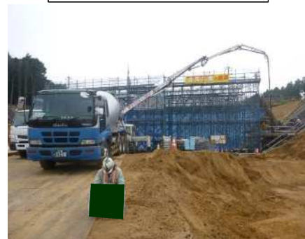
コンクリート打設
