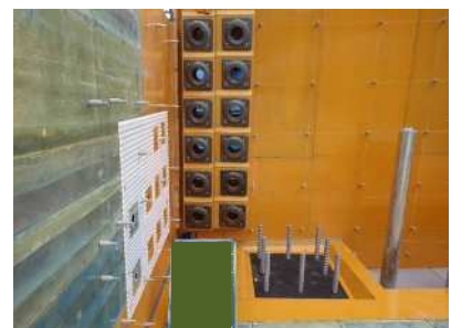
緊張端付近の型枠状況
