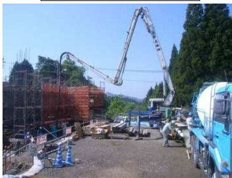
コンクリート工
