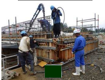
コンクリート打設
