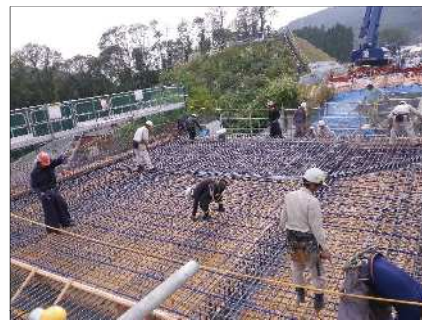
上床版コンクリート打設
