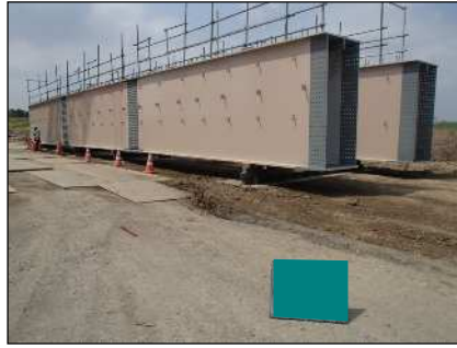
地組立（ボルト接合）
