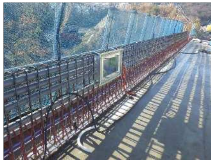
落橋防止構造 橋台側
