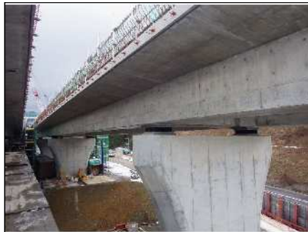
支保工撤去完了(参考例)
