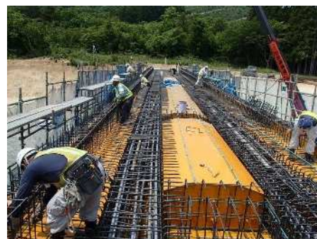
鉄筋組立作業状況
