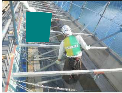
張出部支保工
