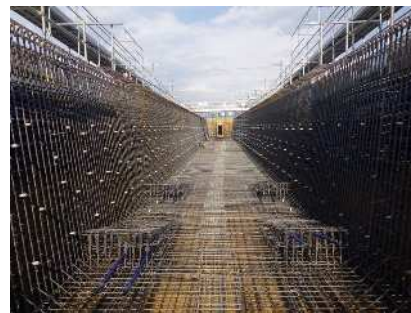
鉄筋・縦締め組立完了
