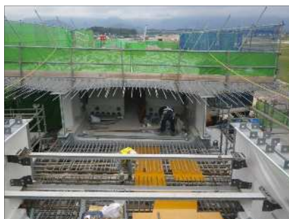
波形鋼板架設
