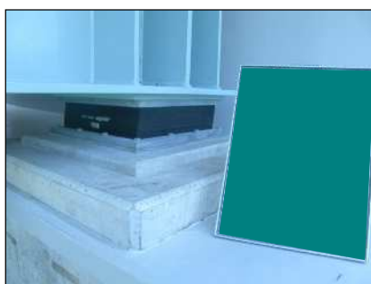
モルタル打設完了
