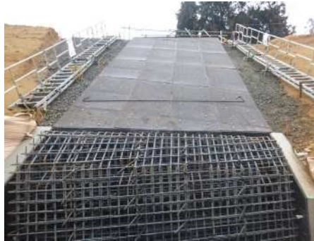
コンクリート打設
