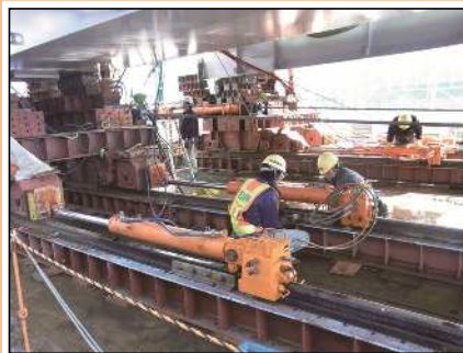
送出し装置用逸走防止装置
