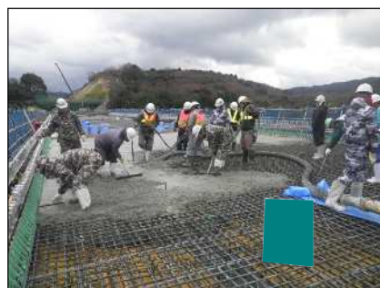
コンクリート打設
