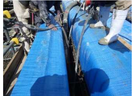
下床版コンクリート打設
