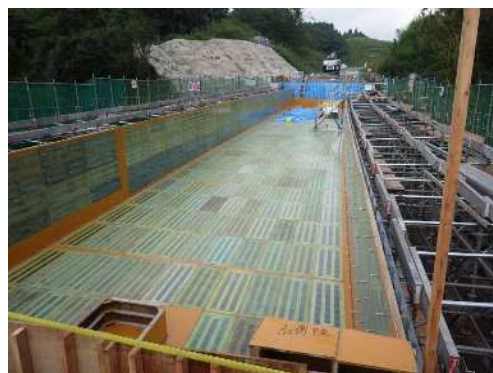
底板・側型枠組立
