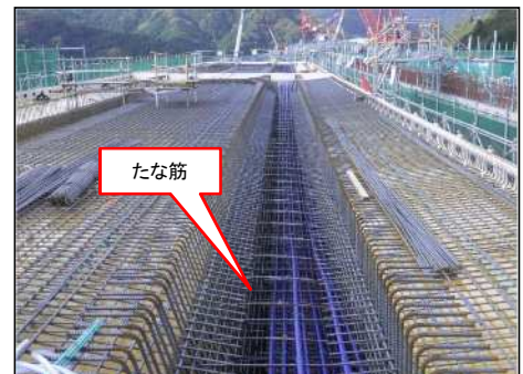
縦締めケーブル配置完了
