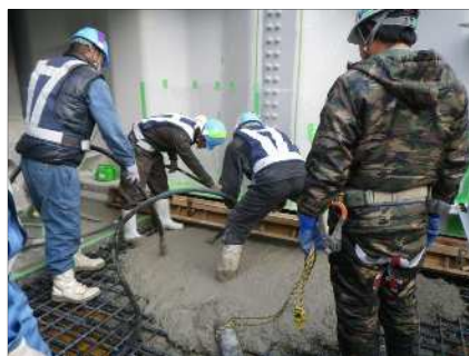
下床版コンクリート打設
