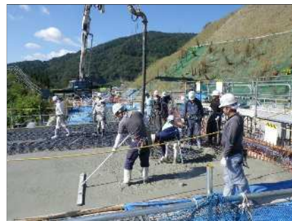
上床版コンクリート打設
