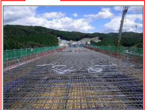
鉄 筋 組 立 完 了
