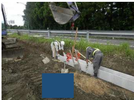
プレキャスト製品(U字溝)の据付
