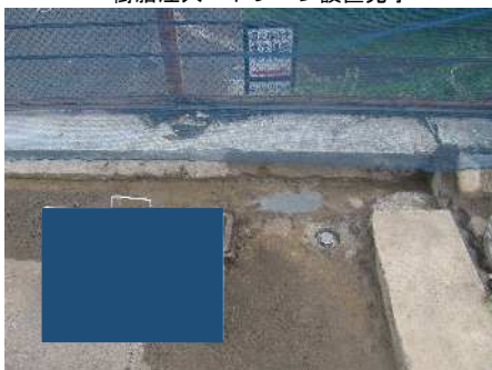
樹脂注入・ドレーン設置完了
