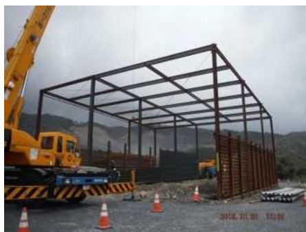
骨材仕切、上屋設置
