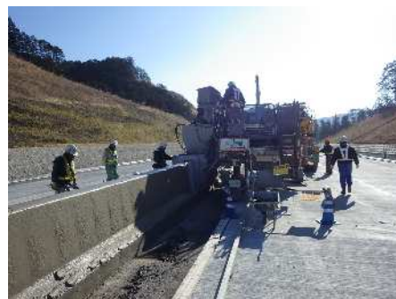
コンクリート打設
