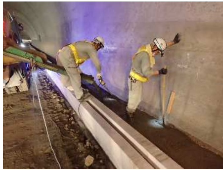
均しコンクリート打設
