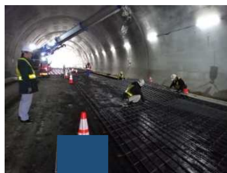
鉄筋設置状況
