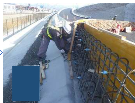
鉄筋工・型枠工
