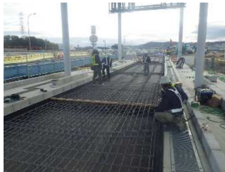
鉄網・補強鉄筋配置
