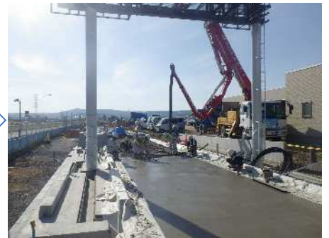
コンクリート打設
