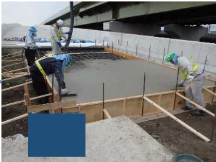
コンクリート打設
