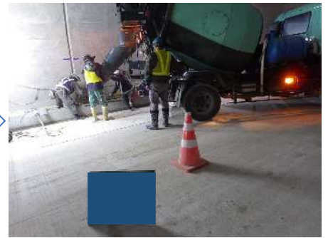
コンクリート打設
