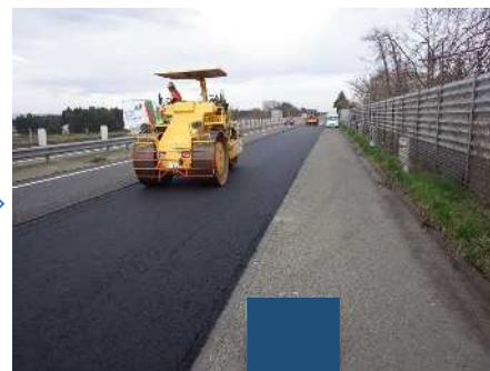
アスファルト混合物締固め
