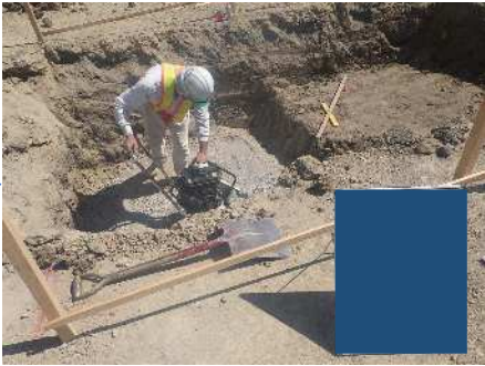
基礎材締固め
