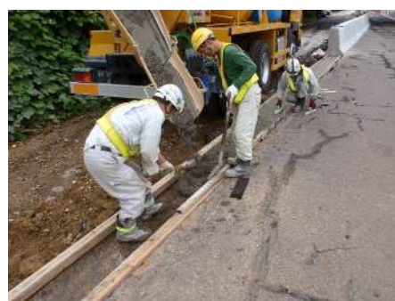
基礎コンクリート打設
