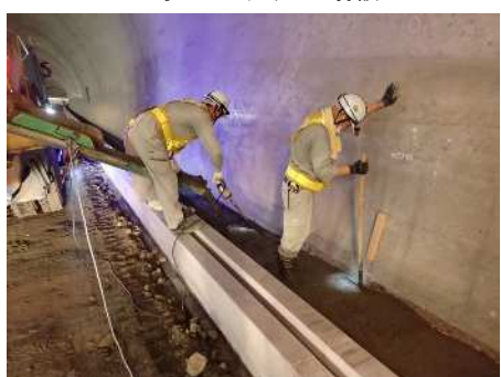
均しコンクリート打設
