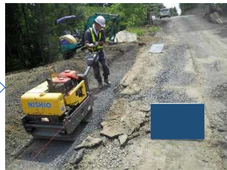
基礎材締固め
