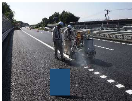
路面標示（ライン）施工
