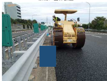
鉄輪に型枠設置
