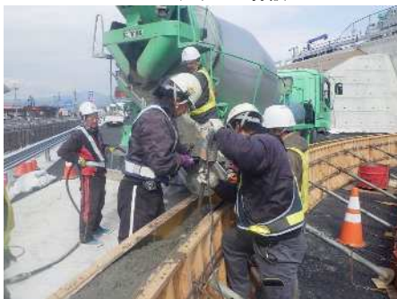
コンクリート打設
