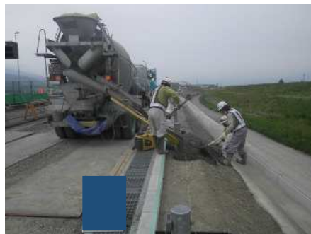
コンクリート打設
