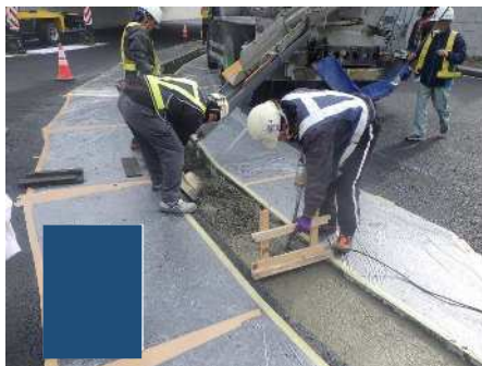
基礎コンクリート打設
