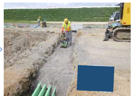
保護砂埋戻し・締固め
