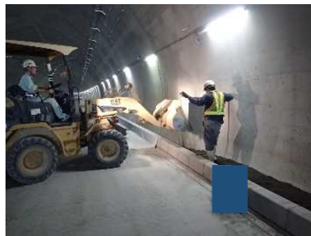
中詰土充填・締固め
