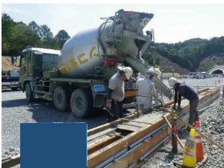
コンクリート打設
