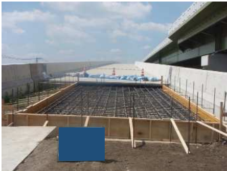
型枠設置・鉄筋工
