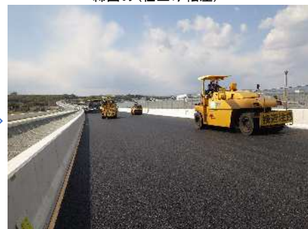
締固め(仕上げ転圧)
