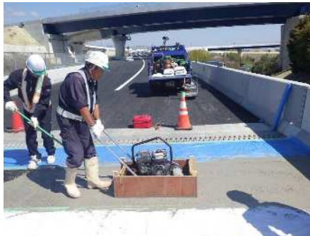
セメントミルク振動・締固め
