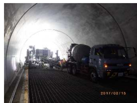
コンクリート打設
