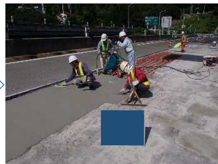
断面修復（コンクリート打設）
