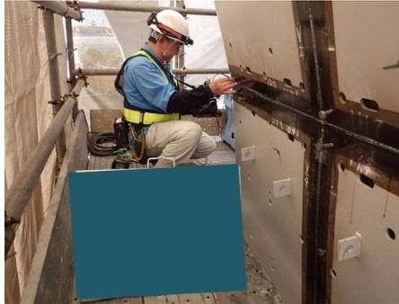
・内部きずの検査は、『鋼溶接部の超音波探傷試験方法』による。
