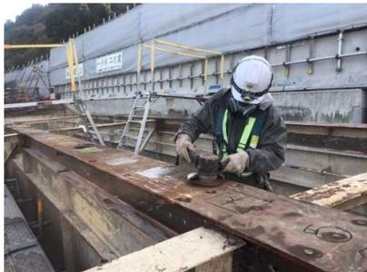
桁上に残存した床版を撤去し、ずれ止めをガス切断機等で切断する。
