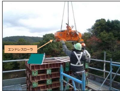
・写真は水平ジャッキ（駆動装置）とエンドレスローラを使用した送出しの例である。
