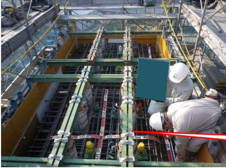
形鋼を用いて所定の位置・高さにボイドを設置する。
