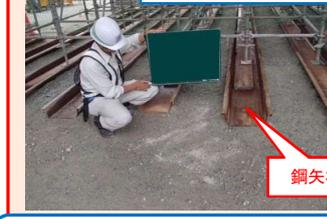
支保工基礎は、敷き均した砕石上に鋼矢板を用いる方法が一般的であるが、地耐力が不足する場合は、杭とH型鋼梁を使用した基礎を設けることもある。
