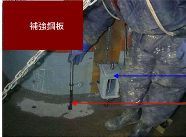
※ 補強鋼板架設完了後、無収縮モルタル充填前に、取付プレートとアンカーボルトを設置する。
