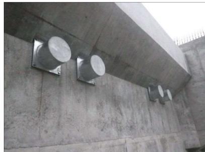
落橋防止構造 桁側
