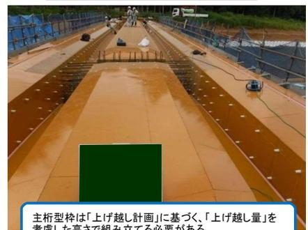
主桁型枠は「上げ越し計画」に基づく、「上げ越し量」を考慮した高さで組み立てる必要がある。
