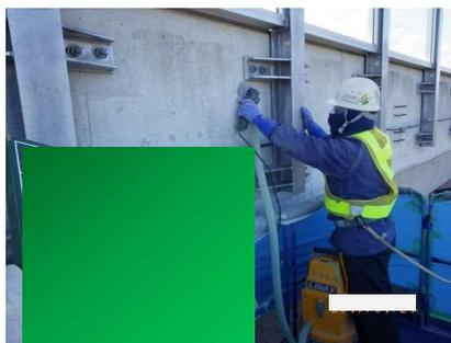
ディスクサンダー工法とは、ウォータージェット工法を用いることが困難な狭隘な場所、光ケーブル等の近接施工箇所などに使用する。支障物から100mmまでを基本とする。
