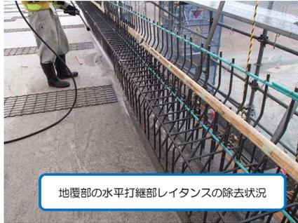
地覆部の水平打継部レイトランスの除去状況
