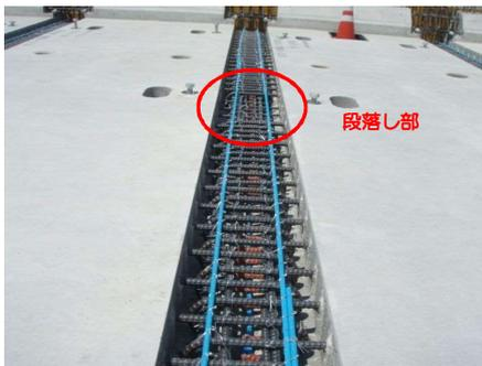
接合部の鉄筋は、床版の調整後、組立を行う。配力筋は、高所作業車等を使用してサイドから挿入するが、作業が無理な場合は(上空制限がある場合等)、ループ鉄筋の一部を段落しとし橋面上から挿入できるような配慮が必要である。
