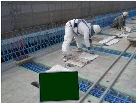
無収縮モルタルについては、スタッドジベルを溶植したら速やか打設する。無収縮モルタルはプレミックスタイプを使用するものとし、低い方から打設を行う。
