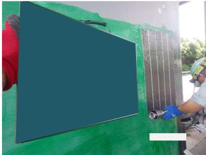
※本工事では、目付量200g/m<sup>2</sup>の炭素繊維シートを柱軸方向に2層、周方向に1層施工。
