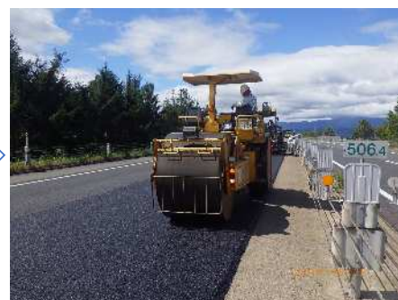
締固め（1次転圧）
