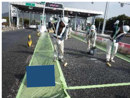
プライマー塗布
