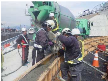
コンクリート打設
