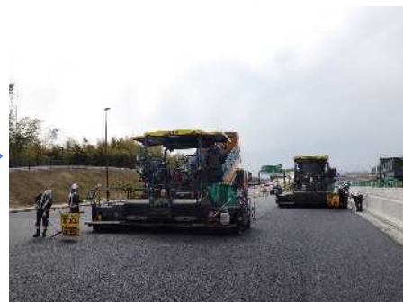
アスファルト混合物敷均し
