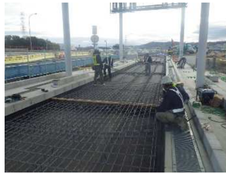
鉄網・補強鉄筋配置
