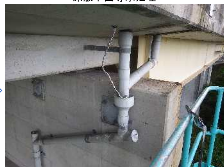
床版下面導水処理
