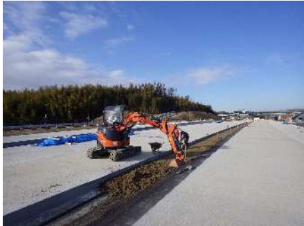
【中央分離帯部】 敷均し
