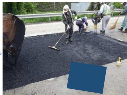
敷均し・締固め
