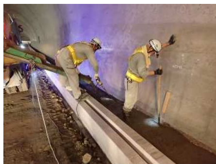
均しコンクリート打設
