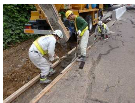
基礎コンクリート打設
