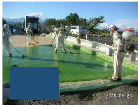
舗装接着材塗布
