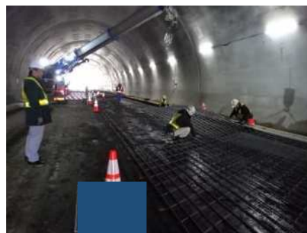
鉄筋設置状況
