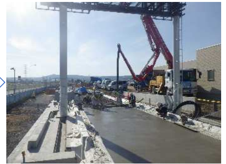
コンクリート打設
