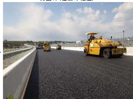
締固め(仕上げ転圧)
