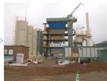
仮設完了(電気配線など)
