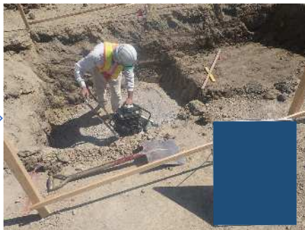
基礎材締固め
