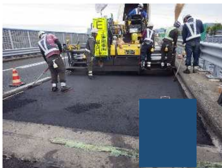
アスファルト混合物敷均し
