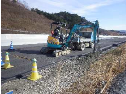
【舗装端部】 敷均し
