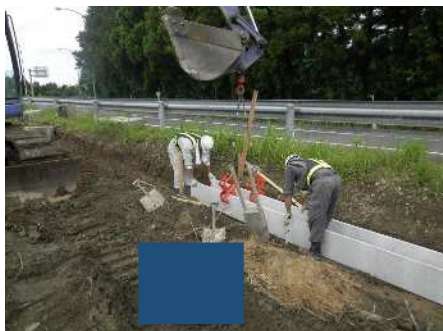
プレキャスト製品(U字溝)の据付
