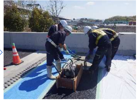
セメントミルク注入
