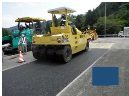
試験舗装(2次転圧)
