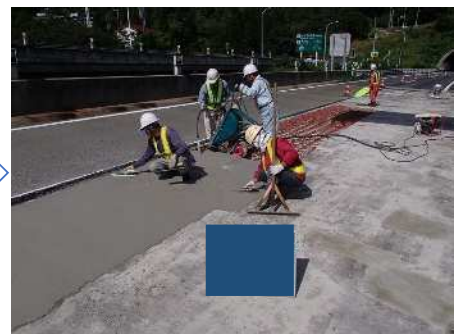
断面修復（コンクリート打設）
