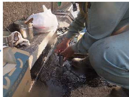
ドレーン設置
