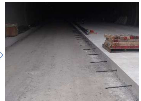
1車線分打設完了
