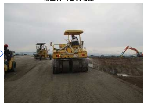
締固め（2次転圧）
