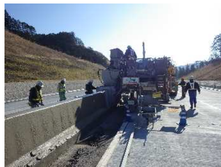
コンクリート打設
