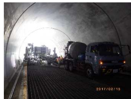
コンクリート打設
