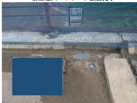
樹脂注入・ドレーン設置完了
