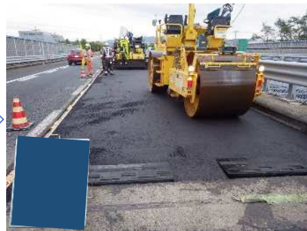
締固め（1次転圧）
