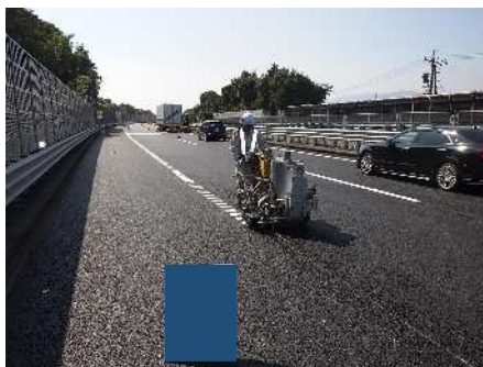
リブのみ施工
