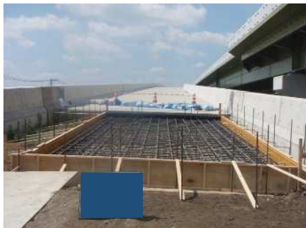
型枠設置・鉄筋工
