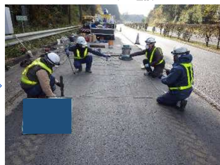
ループコイル埋設
