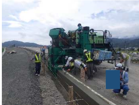
コンクリート打設（スリップフォーム）
