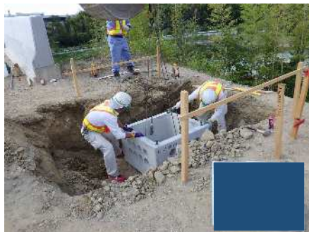
ハンドホール据付
