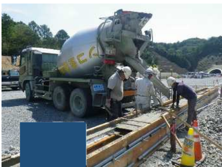
コンクリート打設
