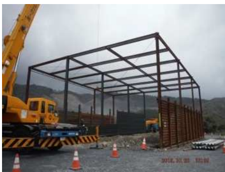
骨材仕切、上屋設置
