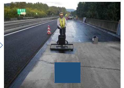
プライマー塗布
