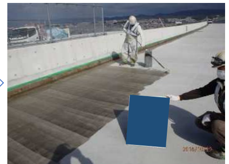
床版用接着材塗布
