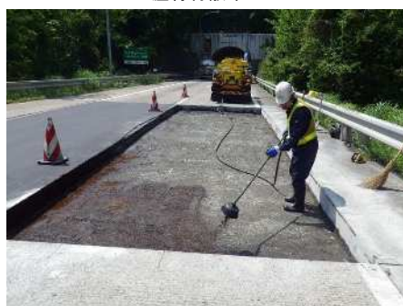
瀝青材散布工
