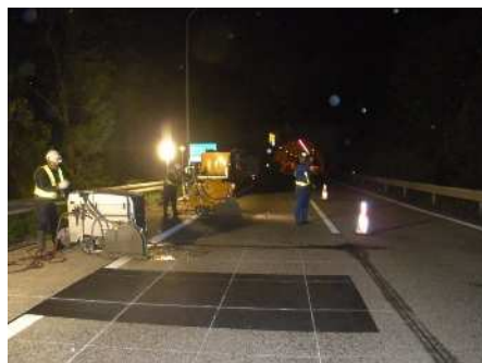
既設舗装の切断
