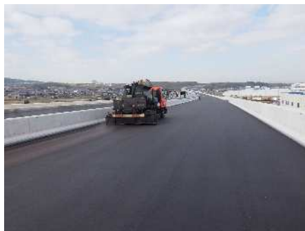
瀝青材散布工
