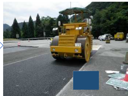
試験舗装(1次転圧)
