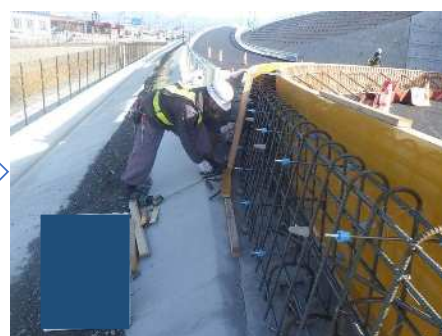
鉄筋工・型枠工
