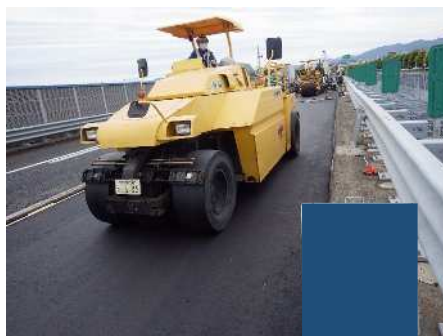
締固め（2次転圧）
