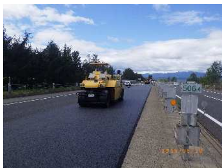
締固め（2次転圧）
