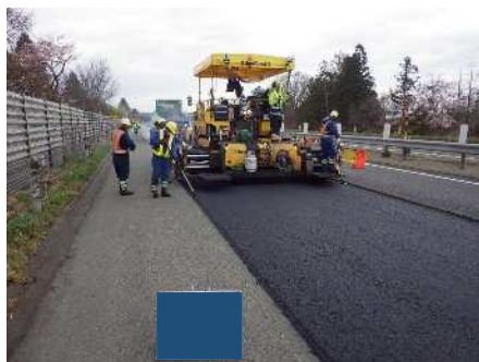
アスファルト混合物敷均し
