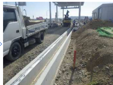
用排水溝完成
