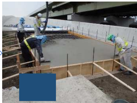
コンクリート打設
