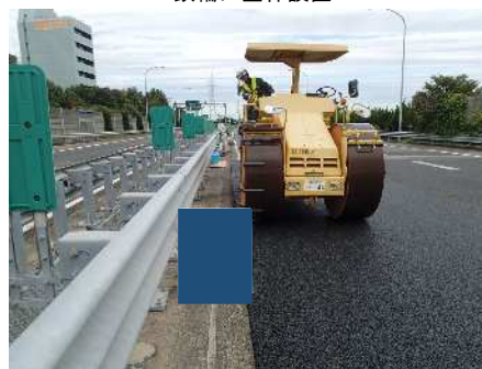
鉄輪に型枠設置
