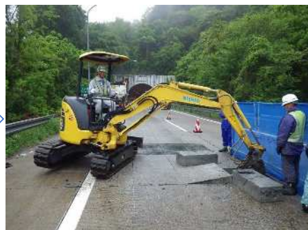
既設舗装の剥取り
