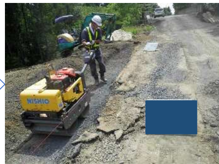
基礎材締固め
