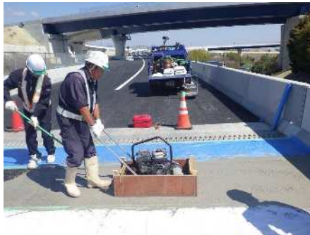
セメントミルク振動・締固め
