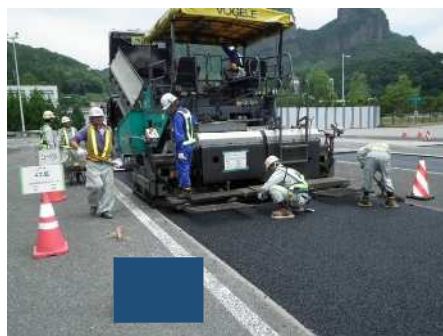
試験舗装(敷均し)
