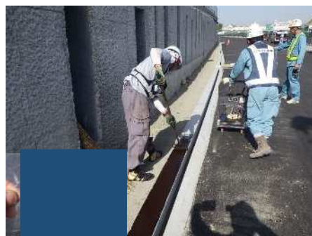
乳剤散布(タックコート)
