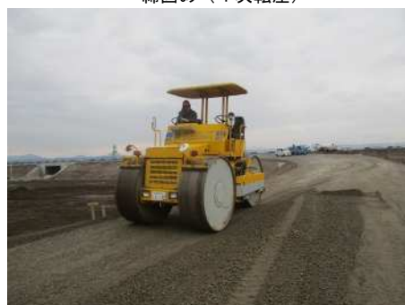
締固め（1次転圧）
