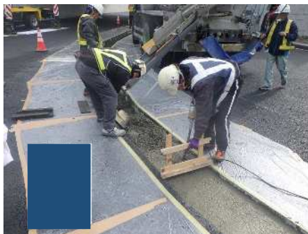
基礎コンクリート打設
