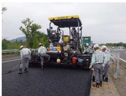
アスファルト混合物敷均し
