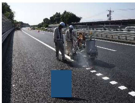
路面標示（ライン）施工
