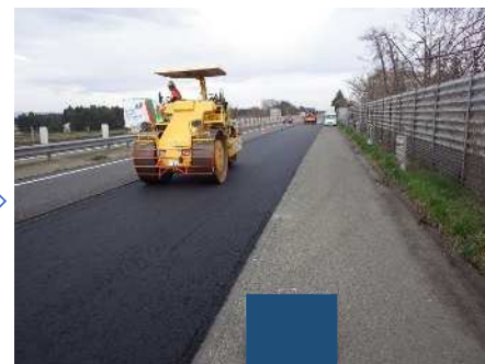
アスファルト混合物締固め
