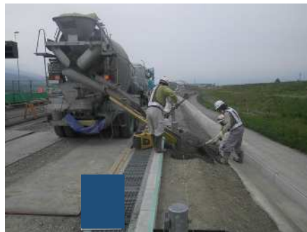
コンクリート打設
