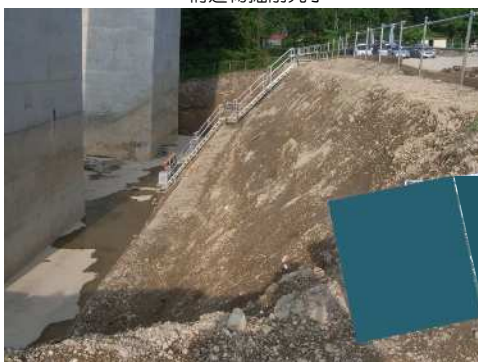
構造物掘削完了
