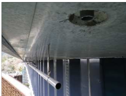
排水管（桁外）
