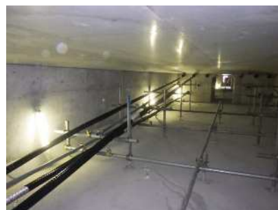
外ケーブル組立状況
