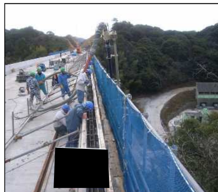
壁 高 欄 の 施 工
