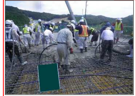
打設状況（上床版部）
