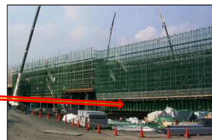
梁（架設桁）+くさび結合式支保工
