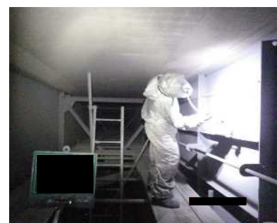
塗膜剥離剤塗布
