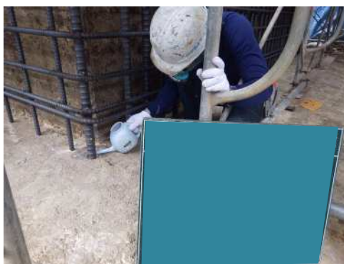
アンカー鉄筋樹脂定着
