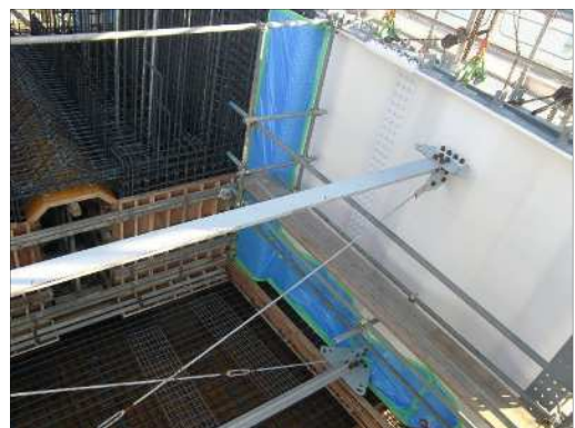
波形鋼板養生
