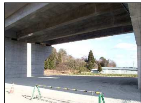
型枠支保工撤去完了
