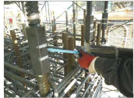
鉄筋継ぎ手
