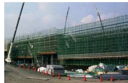
梁(架設桁)+くさび結合式支保工
