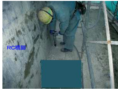
取付アンカー削孔状況
