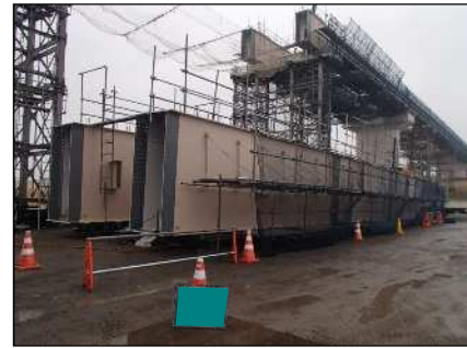
地組立（ボルト接合）
