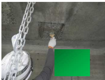
鉄筋防錆処理
