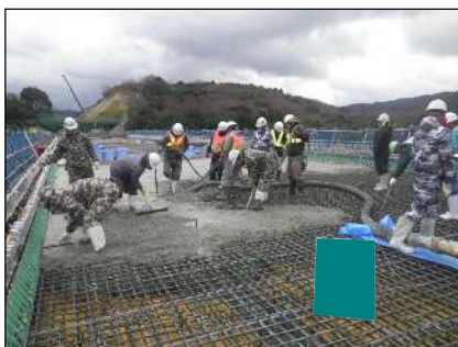
コンクリート打設
