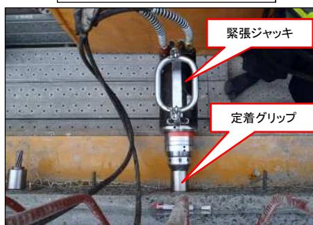
横 締 め 緊 張 状 況
