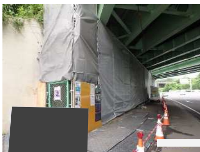
足場設置（外観）
