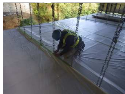
シート張り防護
