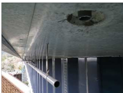
排水管（桁外）
