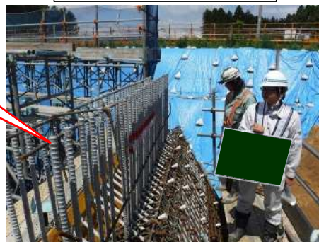
メナーゼヒンジ鉄筋 (亜鉛メッキ処理)
