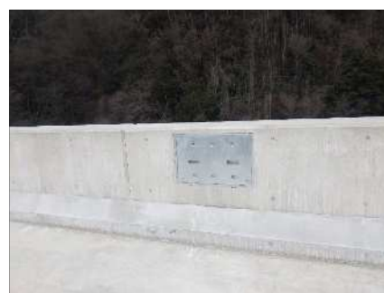
落橋防止構造 桁側
