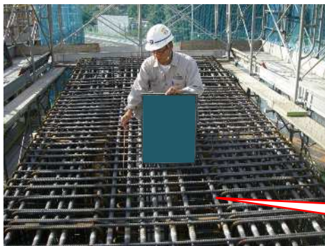
支承アンカー用の箱抜きを設置するために、鉄筋をすまして配置する。
