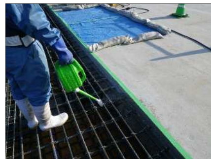
上床版コンクリート打設
