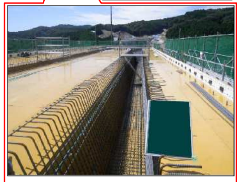
ウ ェ ブ 部 鉄 筋 組 立
