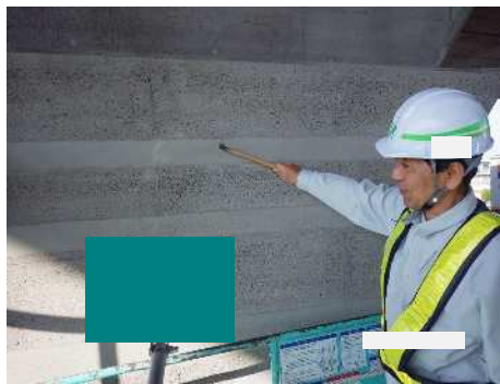
目視、打音検査
