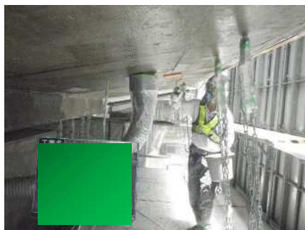
①プライマー塗布
