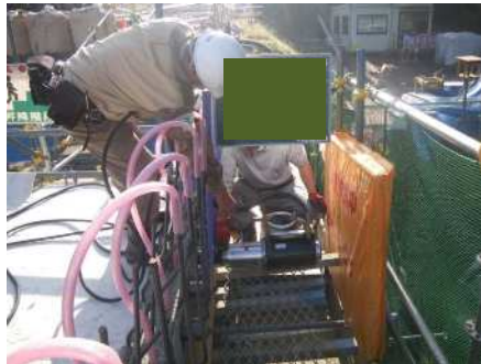
緊張状況(緊張側)
