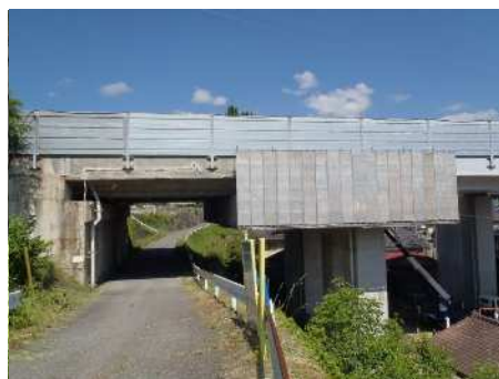
システム足場組立
