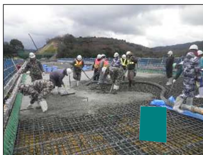
コンクリート打設
