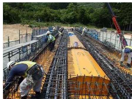
鉄筋組立作業状況
