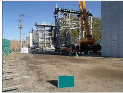
ベント設備組立
