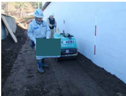
構造物掘削（掘削後転圧）
