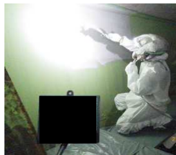
塗膜剥離剤塗布
