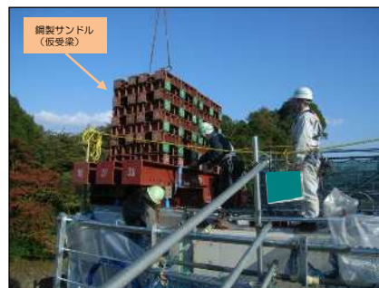
降下設備組立
