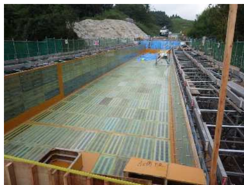
底板・側型枠組立
