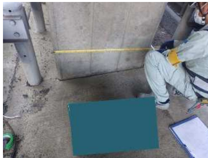
躯体寸法確認
