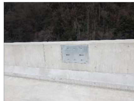
落橋防止構造 桁側
