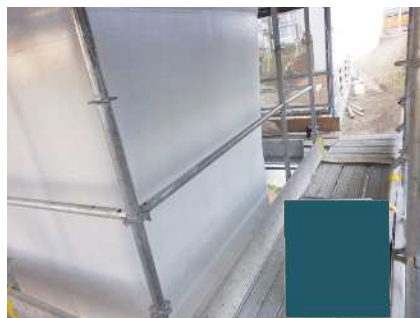
下塗り塗布完了
