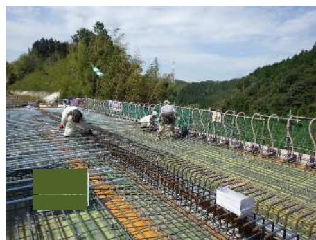
鉄筋・横締め設置状況
