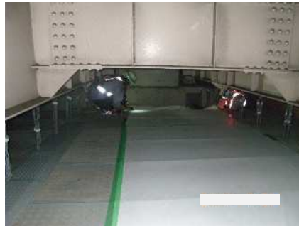
シート張り防護
