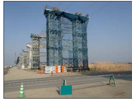
ベント設備組立完了
