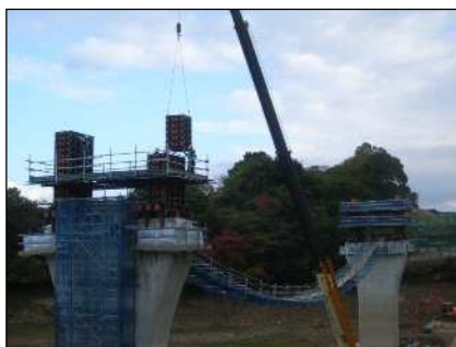
降下設備組立
