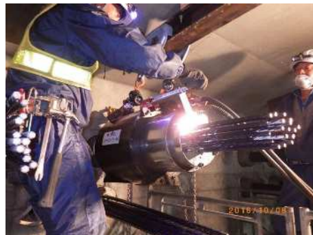
外ケーブル施工完了
