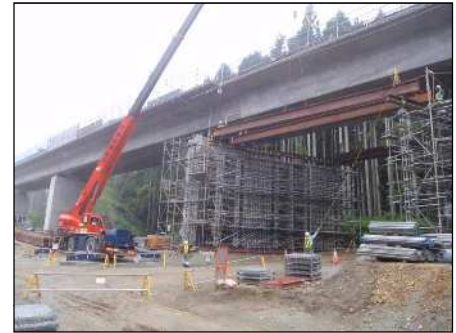
支保工撤去状況(参考例)
