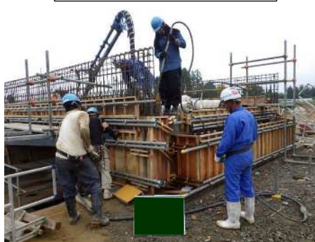
コンクリート打設
