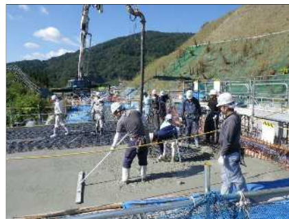
上床版コンクリート打設
