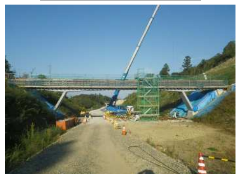
支保工撤去完了
