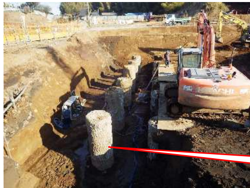
場所打ち杭 (杭頭処理前)
