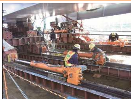
送出し装置用逸走防止装置
