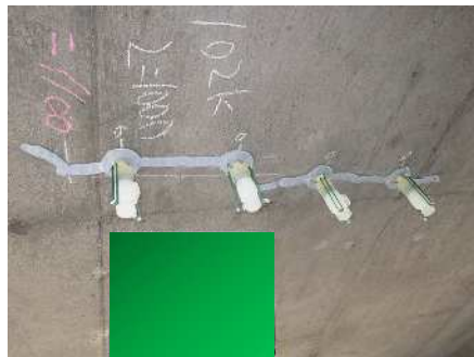
シーリング材塗布
