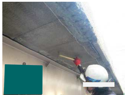
変状部分の確認・除去
