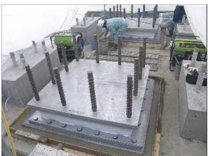
無収縮モルタル打設
