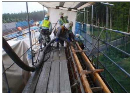
壁高欄コンクリート打設
