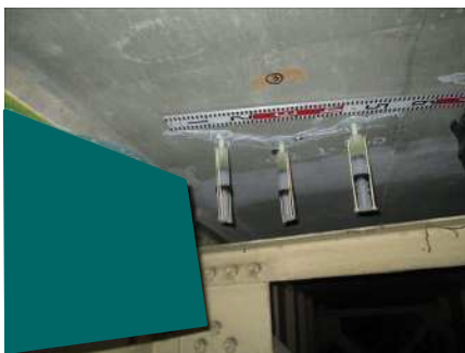
ひび割れ注入
