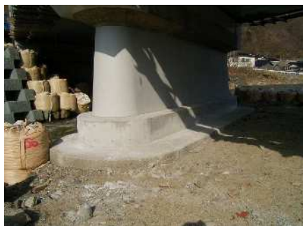
コンクリート打設完了
