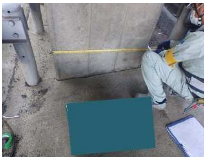
躯体寸法確認
