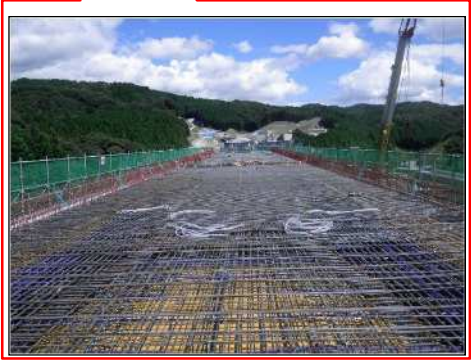
鉄 筋 組 立 完 了
