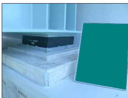
モルタル打設完了
