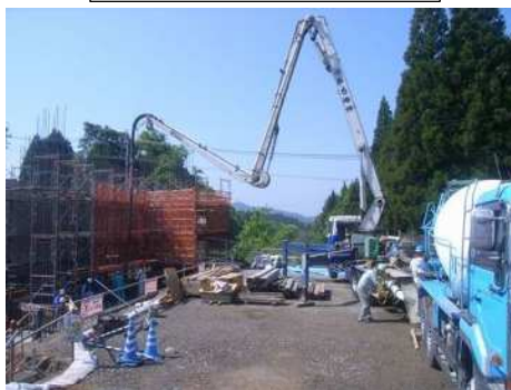
コンクリート工
