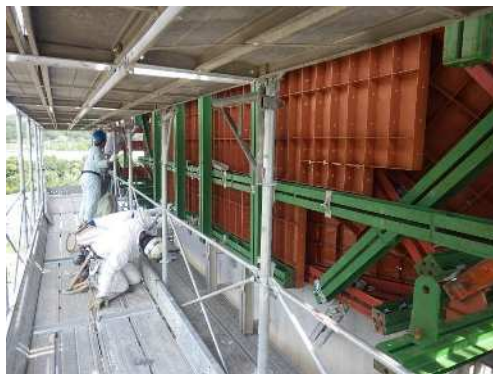
型枠工（側枠）
