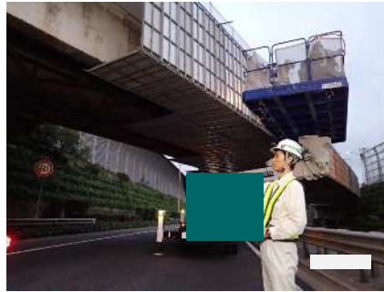
システム足場組立
