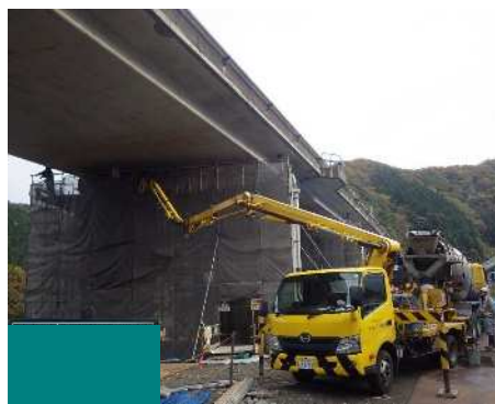
コンクリート打設
