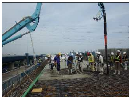
コンクリート打設
