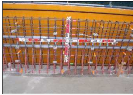
壁高欄コンクリート打設
