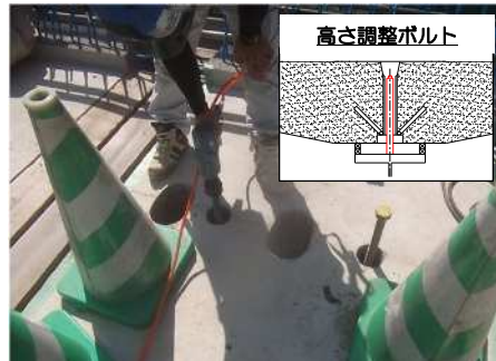
調整工（高さ調整ボルトによる）
