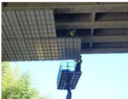
システム足場組立
