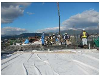
上床版コンクリート打設
