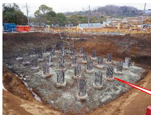
場所打ち杭 (杭頭処理後)
