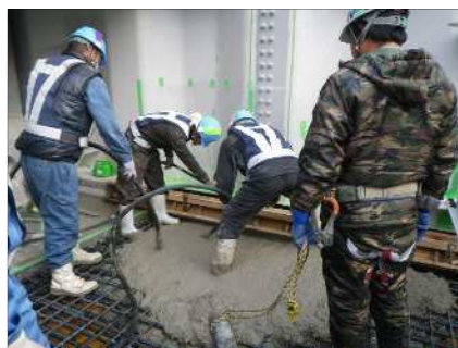
下床版コンクリート打設
