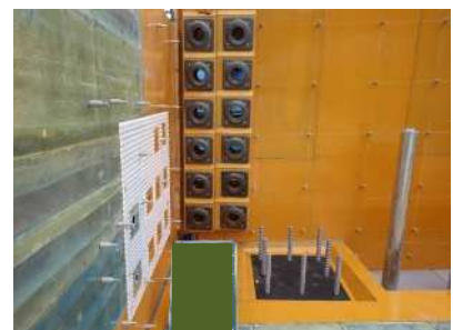
緊張端付近の型枠状況
