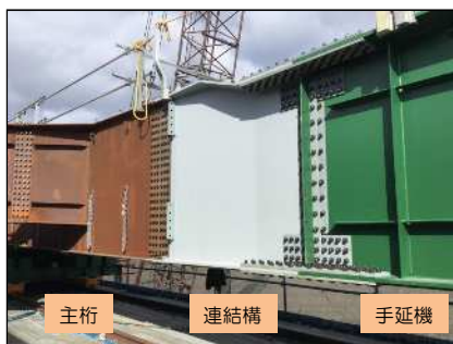
手延機・連結構
