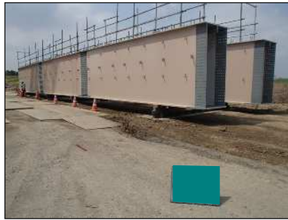
地組立（ボルト接合）
