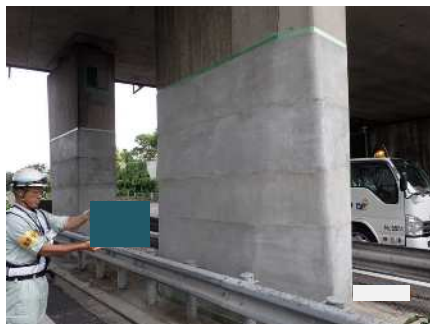
保護塗装（下塗り）完了
