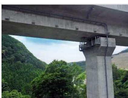
排水管（桁外）
