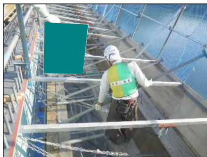
張 出 部 支 保 工
