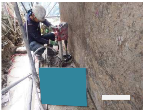
アンカー鉄筋樹脂定着
