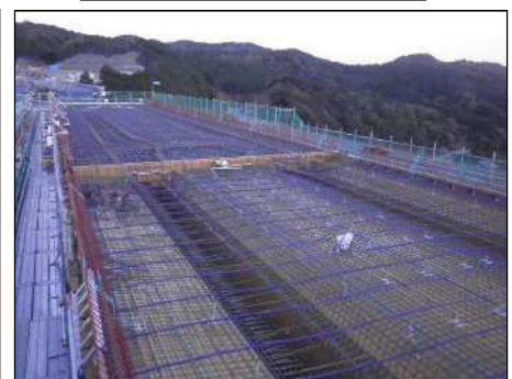
床版横締めケーブル配置完了
