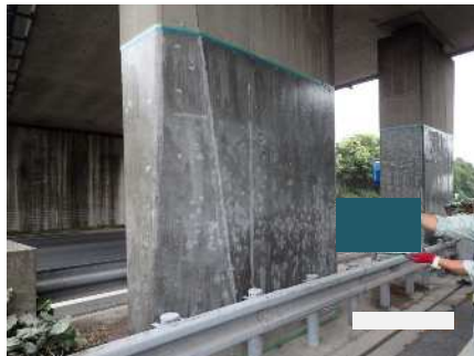
プライマー塗布完了
