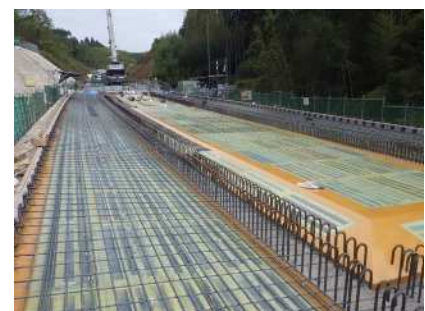
床版型枠設置完了
