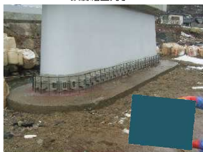
鉄筋組立完了
