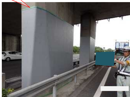
不陸修正完了
