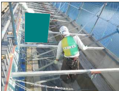
張出部支保工
