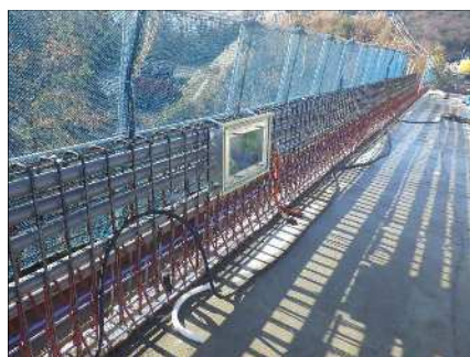
落橋防止構造 橋台側
