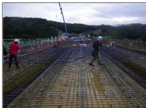
床版横締めケーブル配置状況
