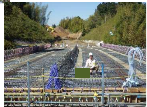
上床版打設前状況全景
