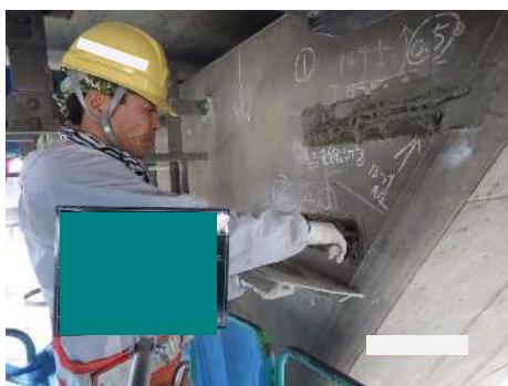
断面修復材塗布
