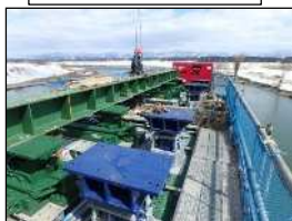
送出し装置（ジャッキ式）
