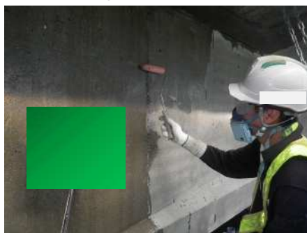
①プライマー塗布
