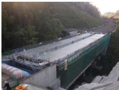
コンクリート打設完了
