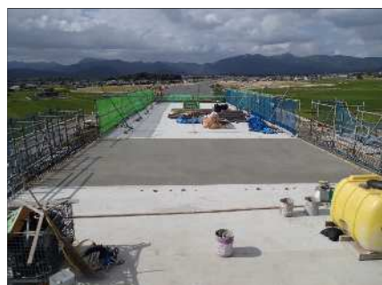
上床版コンクリート打設
