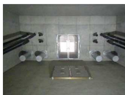
落橋防止構造 桁側
