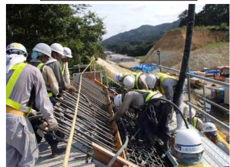
コンクリート打設
