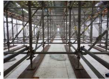
床版型枠設置完了
