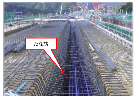
縦締めケーブル配置完了
