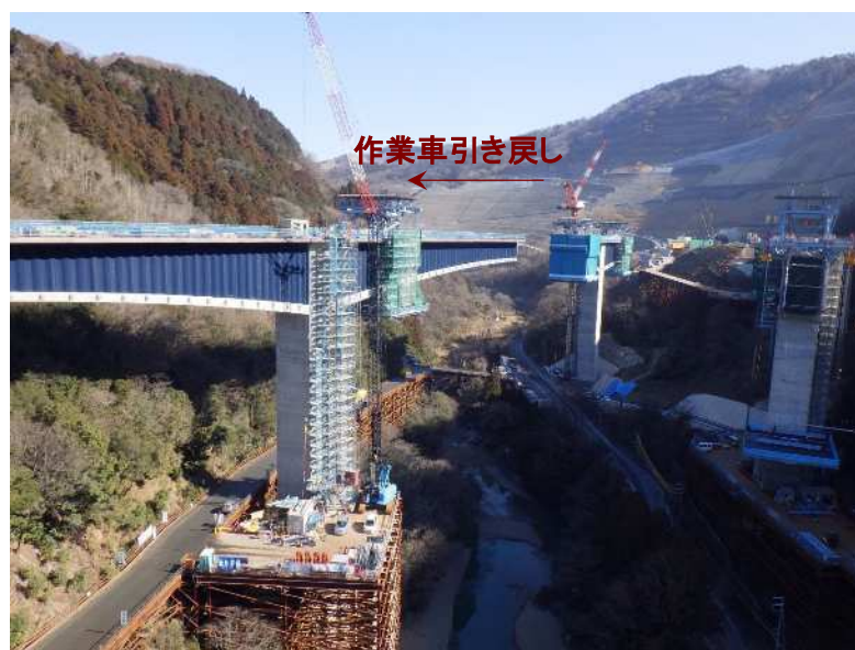
移動作業車後退・解体
