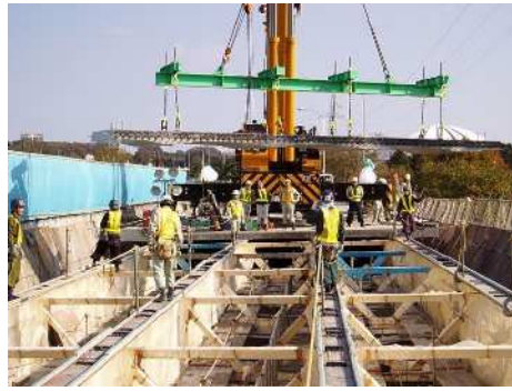
調整工（高さ調整ボルトによる）
