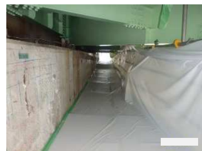
足場設置（内観）
