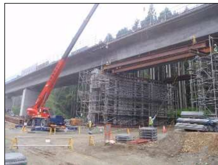
型枠支保工撤去完了
