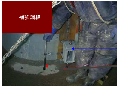
アンカーボルト取付状況
