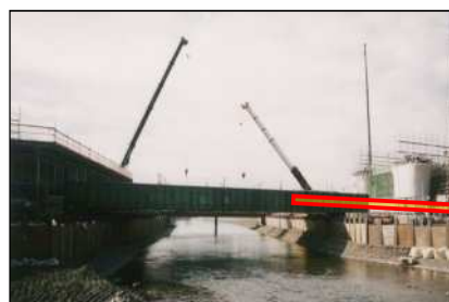
梁（架設桁）架設状況
