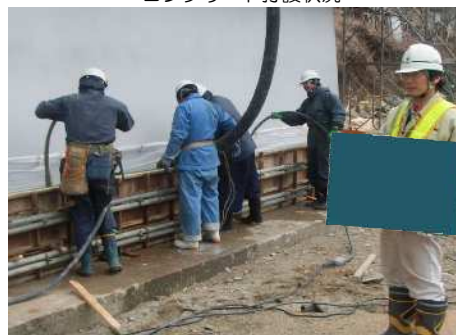
コンクリート打設状況
