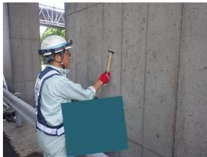
目視、打音検査
