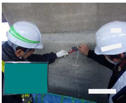
②ひび割れ幅の確認
