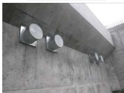
落橋防止構造 橋台側
