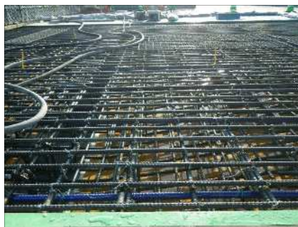
上床版コンクリート打設
