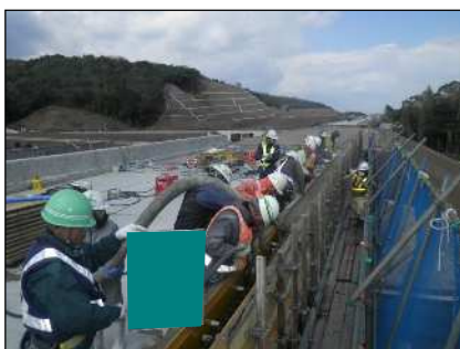
コンクリート打設
