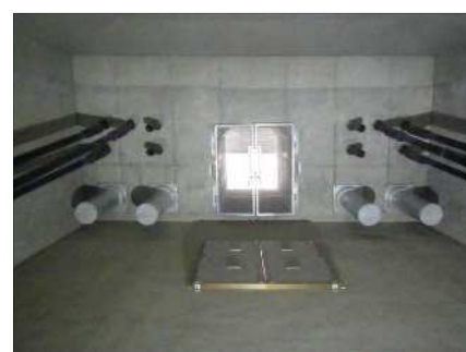
落橋防止構造 桁側
