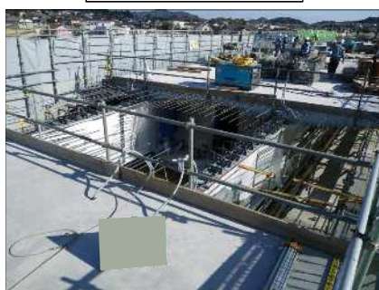
波形鋼板架設
