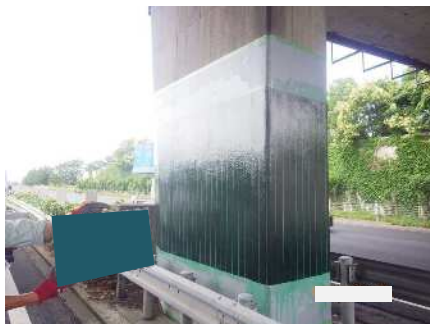
含浸接着樹脂塗布完了
