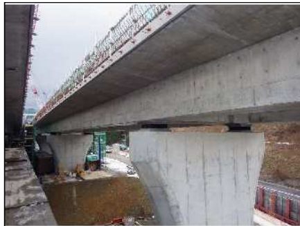
支保工撤去完了(参考例)
