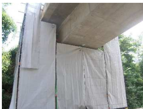
シート防護設置
