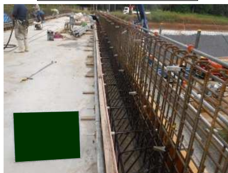
コンクリート打設(地覆)
