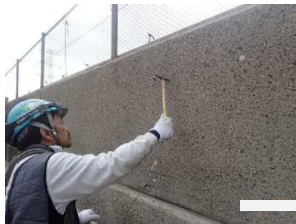
目視、打音検査
