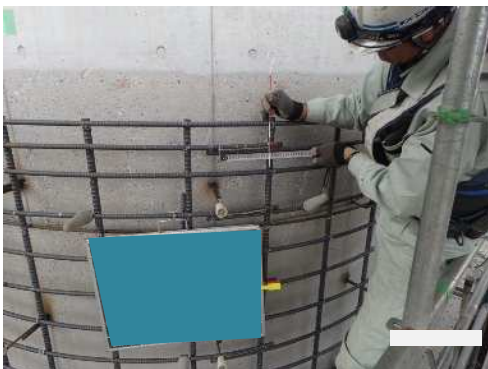
フレア溶接 外観形状寸法確認
