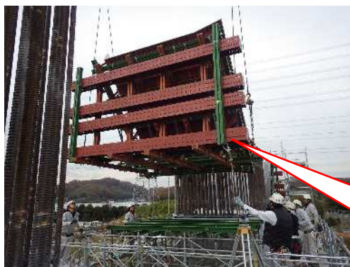
型枠工（底枠）
