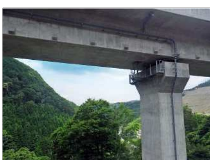
排水管（桁外）
