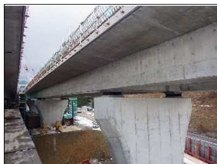
型枠支保工撤去完了
