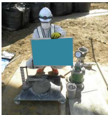
コンクリート受入検査
