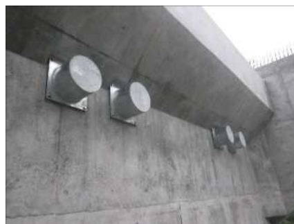
落橋防止構造 橋台側
