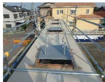
ゴム支保据付状況
