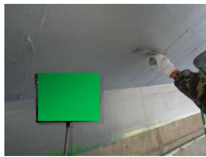
④仕上材塗布
