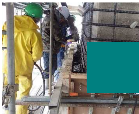
コンクリート打設
