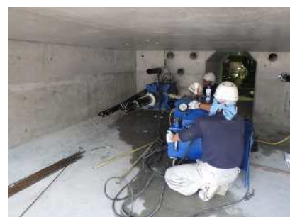
外ケーブル緊張状況
