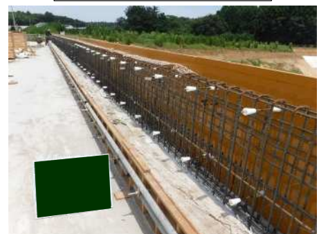
コンクリート打設(壁高欄)
