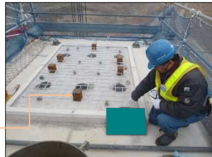
沓座鉄筋設置
