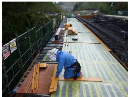
張出床版型枠設置
