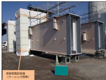
地組立（溶接接合）
