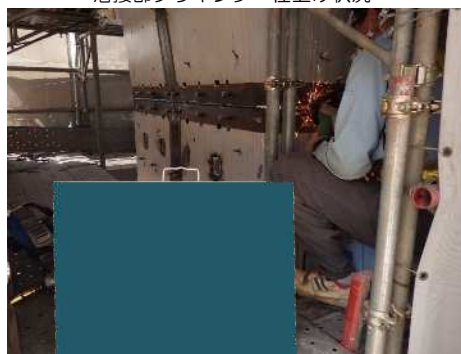
溶接部グラインダー仕上げ状況
