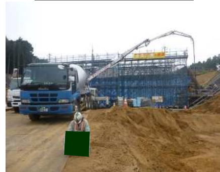
コンクリート打設
