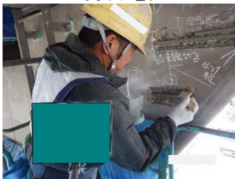
プライマー塗布
