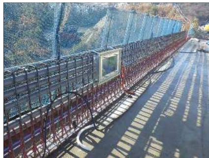
落橋防止構造 橋台側
