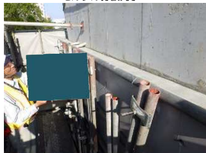
モルタル打設完了
