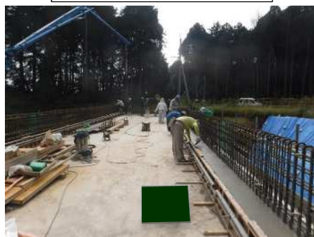
コンクリート打設(地覆)
