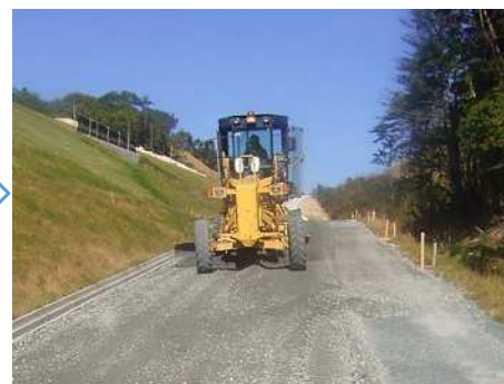
簡易舗装路盤工
