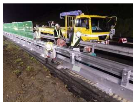
固定用アンカーピン打込み
