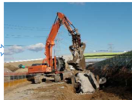
取壊し（圧碎機）
