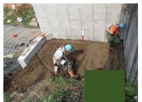
構造物裏込め
