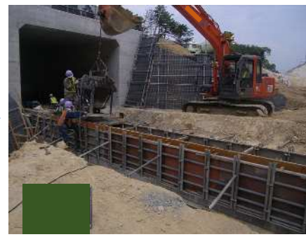
コンクリート打設
