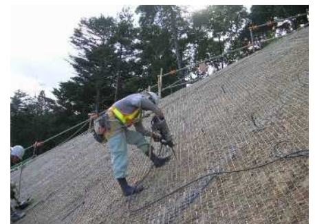
アンカーピン設置
