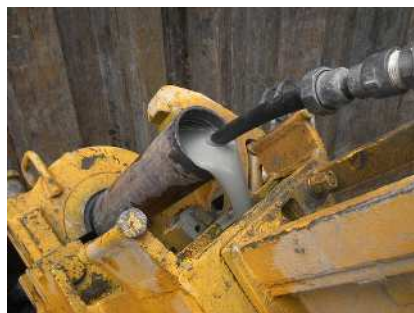
グラウト注入
