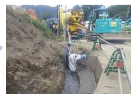
コンクリート打設
