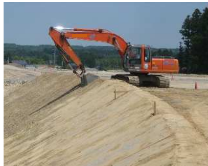
盛土のり面仕上げ（削取り）
