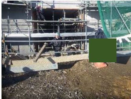
支保・型枠・足場撤去
