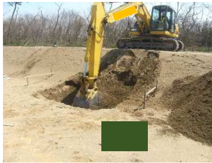
掘削・整正（床付）
