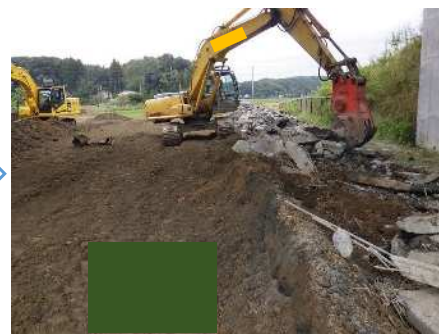
取壊し（圧碎機）
