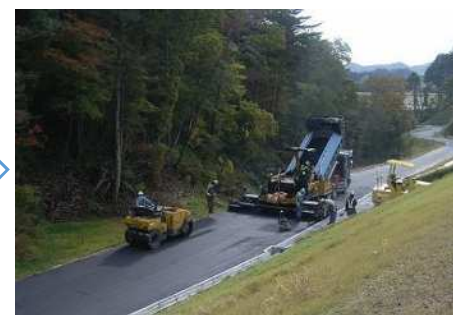
簡易舗装工（締固め）
