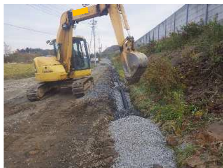
フィルター材設置
