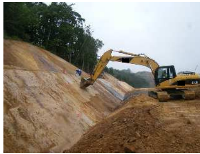
切土のり面仕上げ（土砂）
