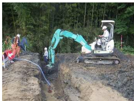
掘削・整正（床付）
