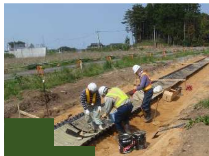
パイプ組立（ボトムセクション）
