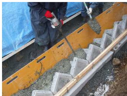
胴込め（※コンクリート打設の場合）
