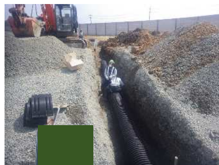
用排水管設置
