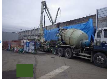
コンクリート打設・養生
