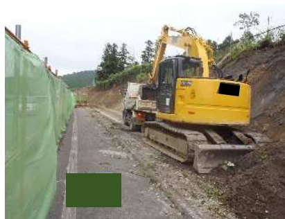
掘削・積込み
