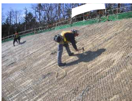
アンカーピン設置
