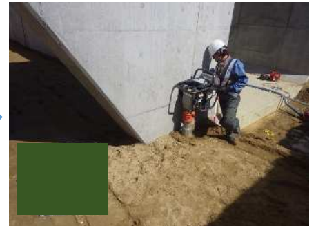
構造物裏込め
