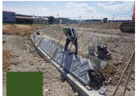
胴込め（コンクリート）
