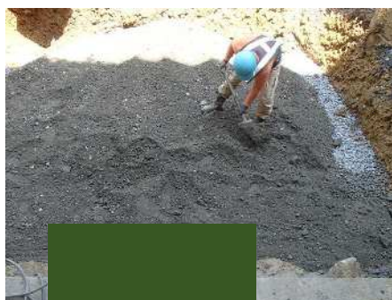
基礎材敷均し・締固め
