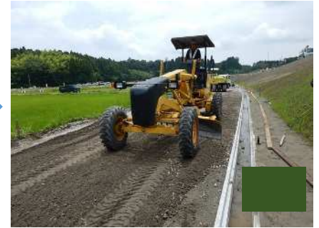
簡易舗装路盤工
