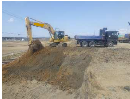
掘削・積み込み
