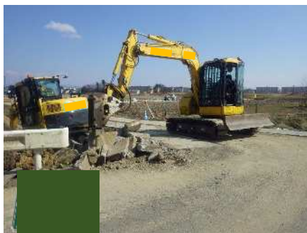
取壊し（大型ブレーカ）
