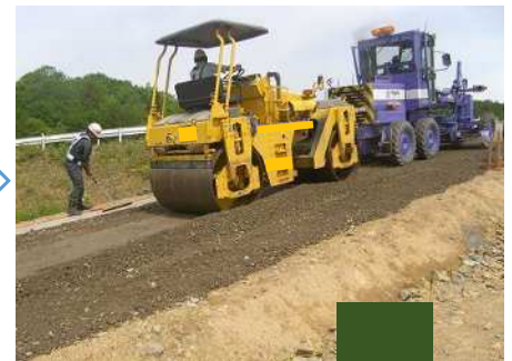
簡易舗装路盤工 (転圧)
