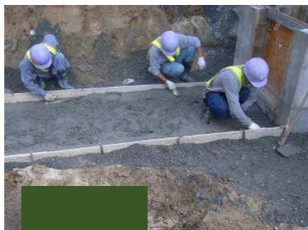
均しコンクリート打設
