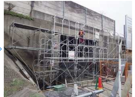
足場・支保設置
