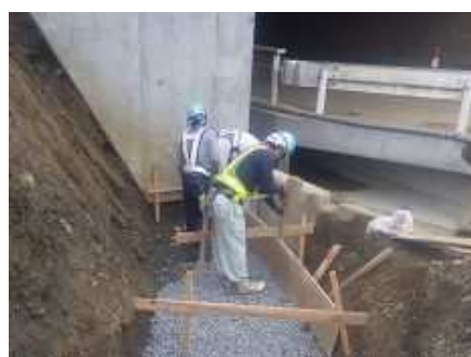
型枠製作・組立て
