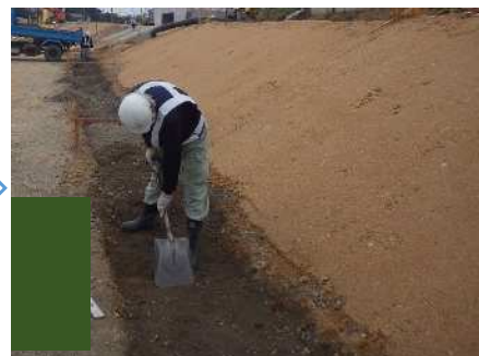
基礎材敷均し・締固め
