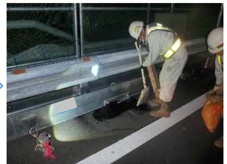
仮設防護柵据付
