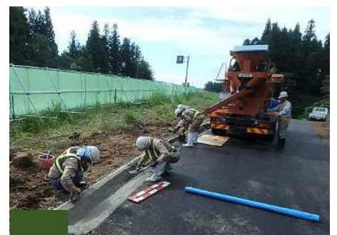
コンクリート打設
