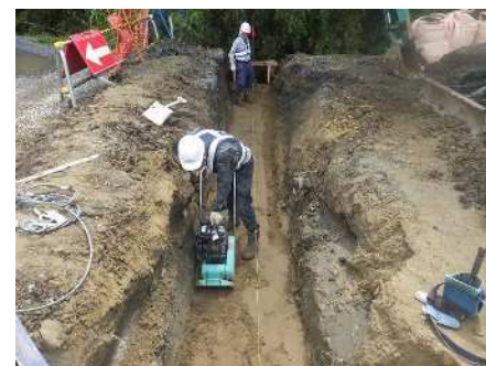
基礎材敷均し・締固め
