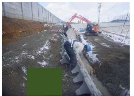
コンクリートブロック積み②
