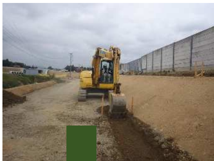
掘削・整正（床付）
