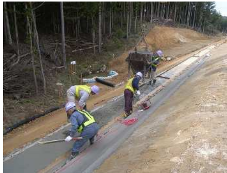
コンクリート打設
