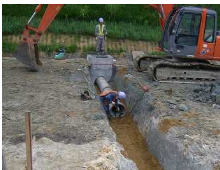
用排水管設置
