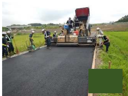
簡易舗装工（敷均し）
