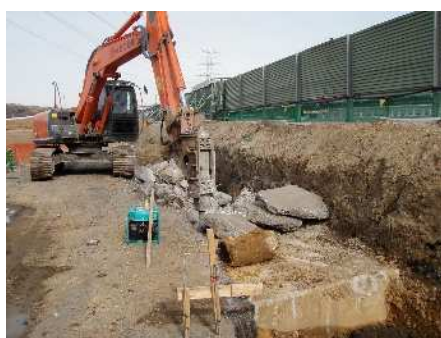
取壊し（大型ブレーカ）
