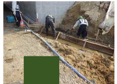
コンクリート打設
