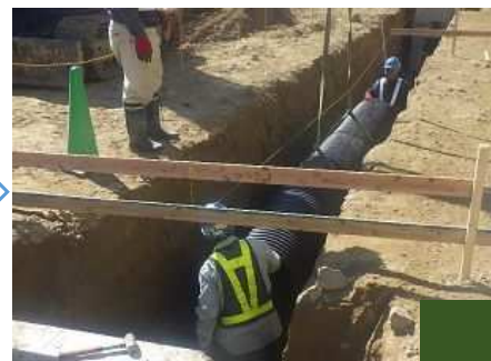
用排水管設置
