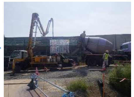
コンクリート打設・養生
