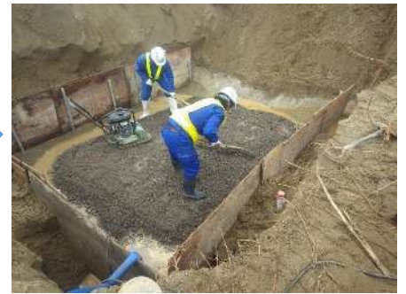
基礎材敷均し・締固め
