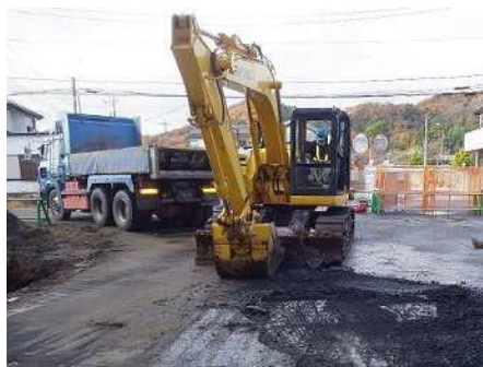
舗装版取壊し
