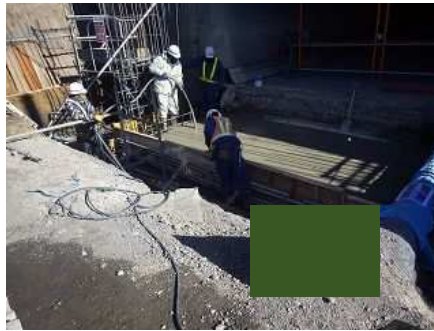
底版コンクリート打設
