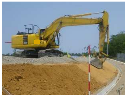
盛土のり面仕上げ（削取り）
