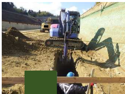
掘削・整正 (床付)
