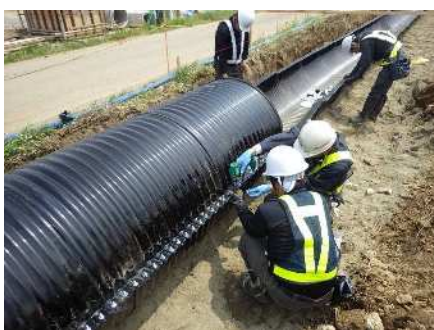
パイプ組立（トップセクション）
