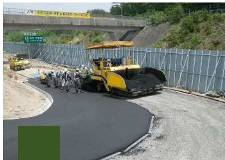
簡易舗装工 (敷均し)
