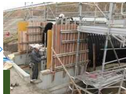
型枠組立②
