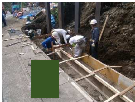
型枠製作・組立て
