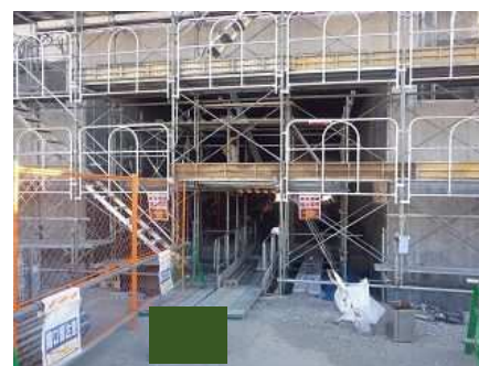
支保・型枠・足場撤去
