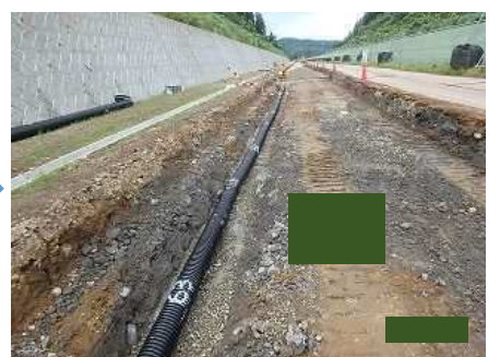
地下排水管設置
