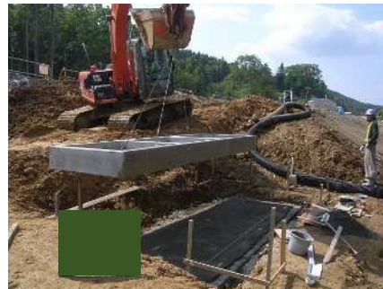
油水分離ます設置
