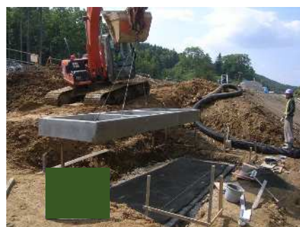
油水分離ます設置
