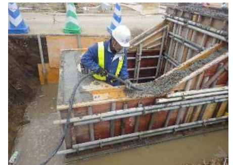
コンクリート打設
