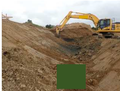
切土のり面仕上げ（土砂）
