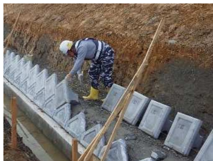
コンクリートブロック積み①
