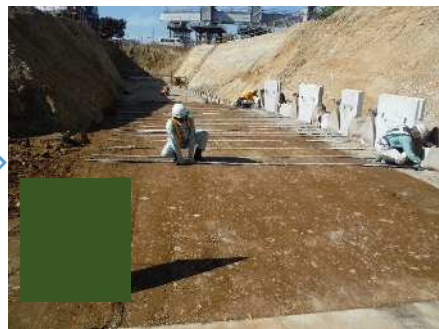
補強材設置
