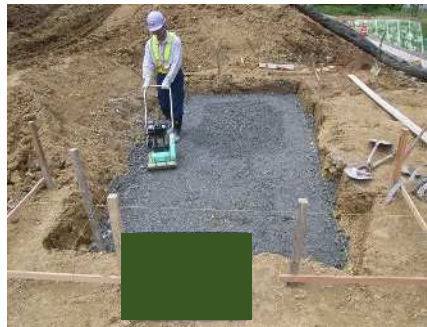
基礎材敷均し・締固め
