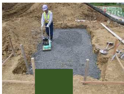
基礎材敷均し・締固め
