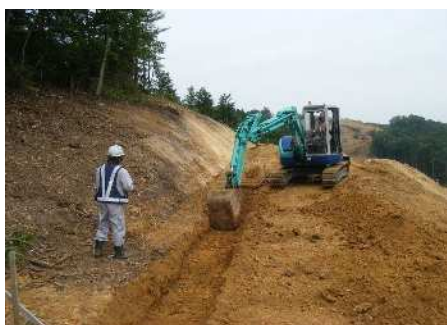
掘削・整正（床付）
