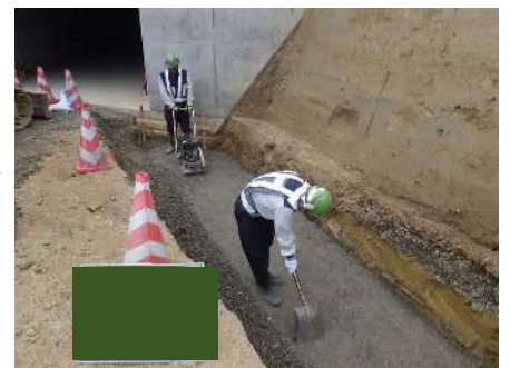
基礎材敷均し・締固め
