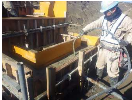
コンクリート打設
