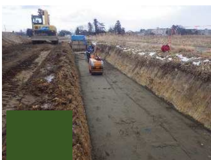
基礎材敷均し・締固め
