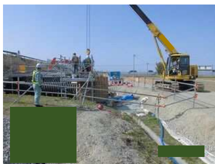
コンクリート打設①
