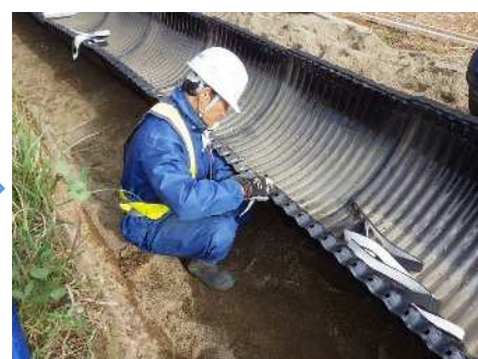
パイプ組立（ボトムセクション）
