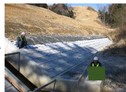
コンクリートブロック張り
