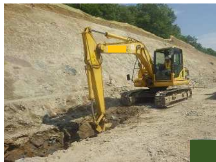
掘削・整正（床付）
