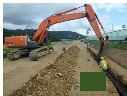
フィルター材設置
