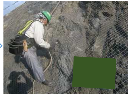
アンカーピン設置
