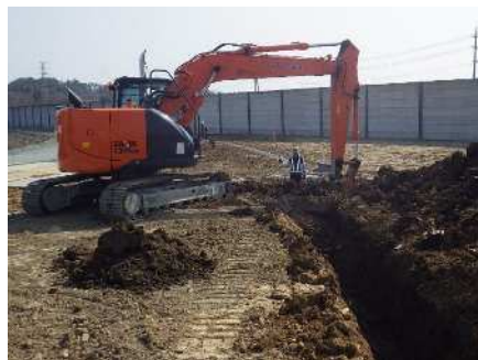
掘削・整正（床付）
