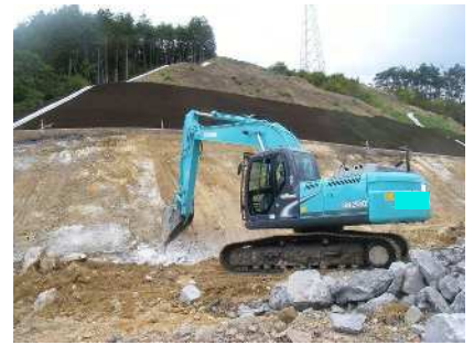
切土のり面仕上げ（硬岩）
