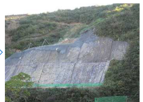
モルタル吹付
