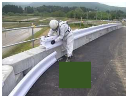
レール等設置
