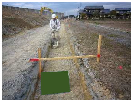
掘削・整正（床付）
