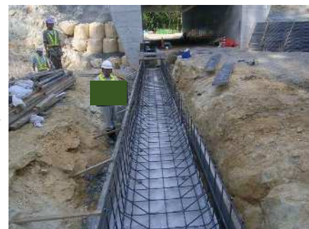
鉄筋加工・組立て
