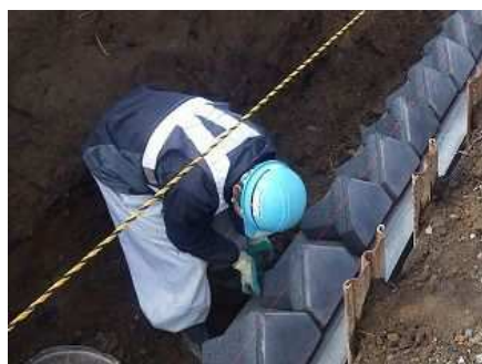
コンクリートブロック積み①
