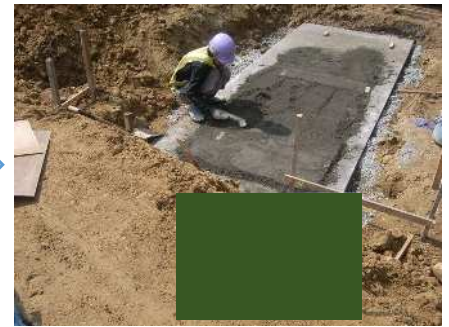
敷モルタル設置
