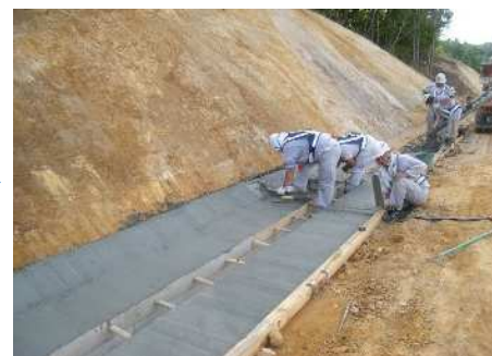
コンクリート打設
