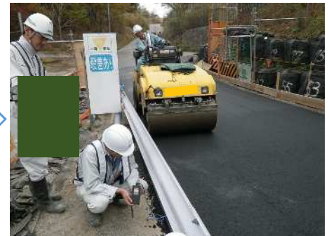
簡易舗装工 (締めめ)
