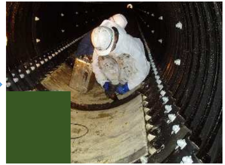
パイプ組立（目地仕上げ）
