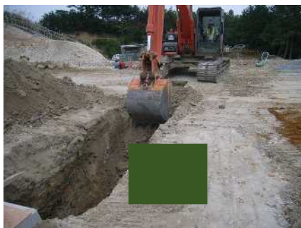
掘削・整正 (床付)
