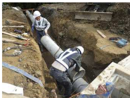
用排水管設置
