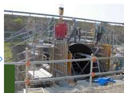
コンクリート打設②
