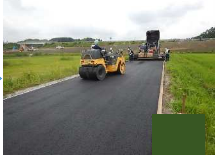
簡易舗装工（締固め）
