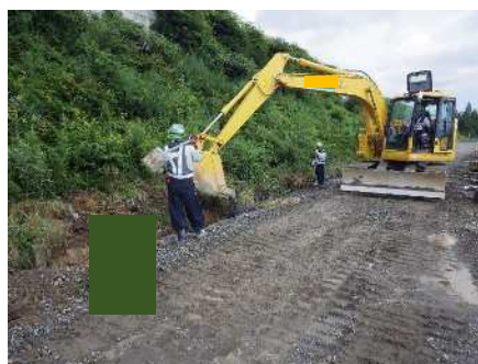
掘削・整正（床付）
