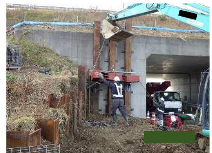
鋼製山留材設置
