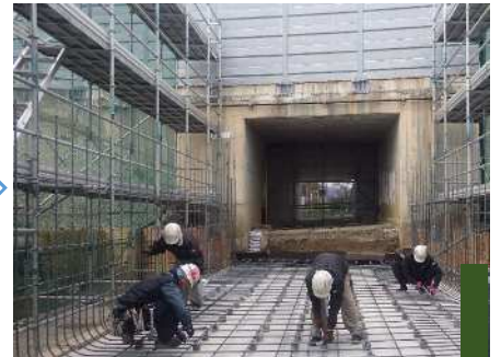
底版鉄筋加工・組立て
