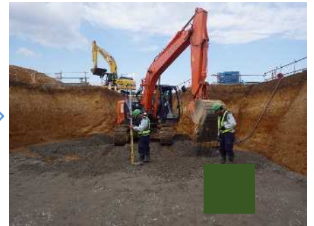
基礎材敷均し
