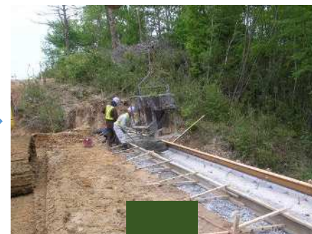
天端コンクリート打設
