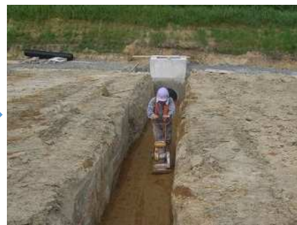
基礎材敷均し・締固め
