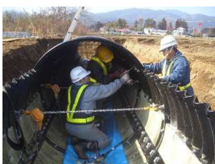
パイプ組立（トップセクション）
