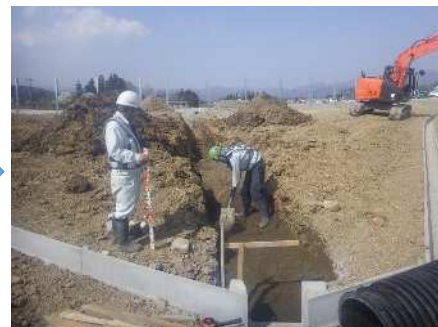
基礎材敷均し・締固め
