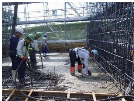
底版コンクリート打設
