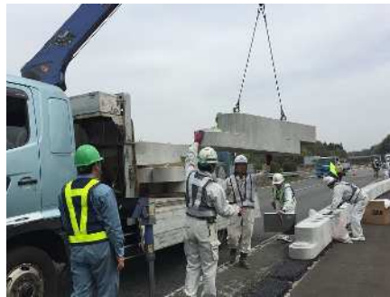
連続基礎ブロック設置
