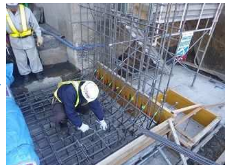
底板鉄筋加工・組立て
