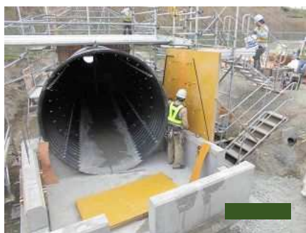
型枠組立①
