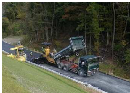
簡易舗装工（敷均し）
