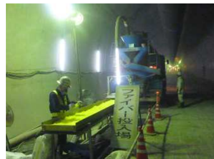
繊維現地混合（覆工コンクリート）
