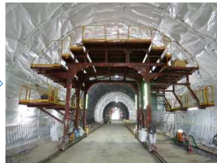
覆工防水工作業台車
