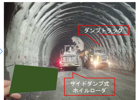
すり処理（すり積み・運搬）
