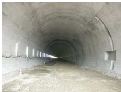
覆工コンクリート打設完了
