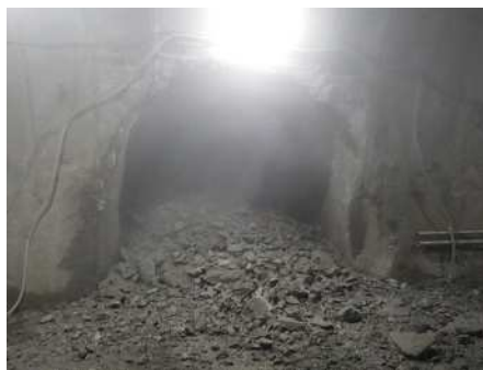
ずり処理（ずり積込み）
