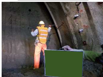
打設（ロックボルト）
