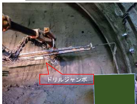
削孔（ロックボルト）
