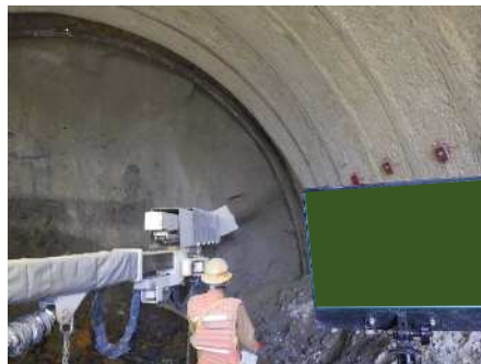
吹付コンクリート
