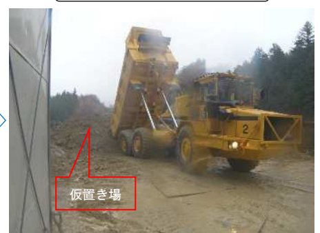
すり処理（すり荷卸し）
