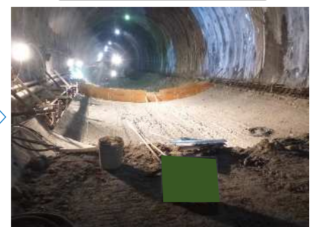
インバート型枠
