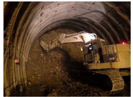
上半掘削（油圧切削機）
