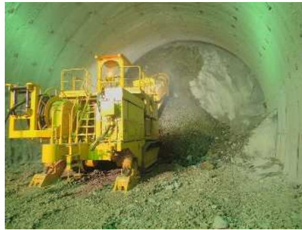
上半掘削（トンネル掘進機）
