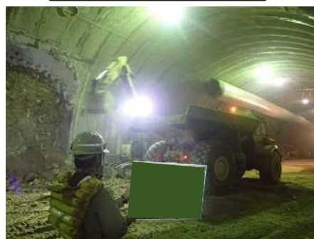
ずり処理（ずり積込み）
