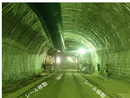
型枠移動（養生完了後）
