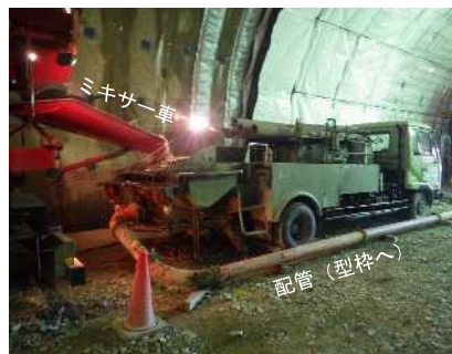
覆工コンクリート（打設）
