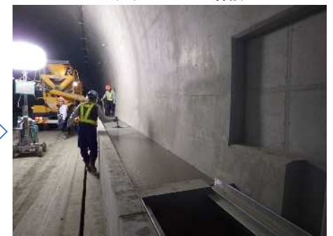
コンクリートシール打設
