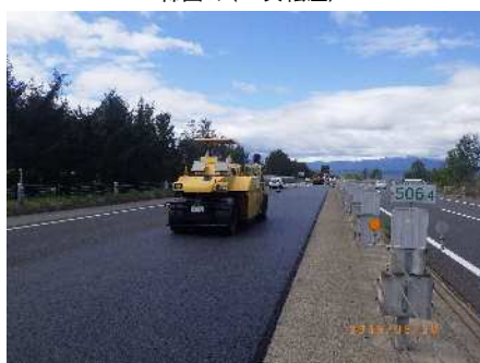
締固め（2次転圧）
