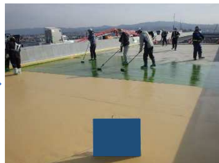
舗装用接着材塗布
