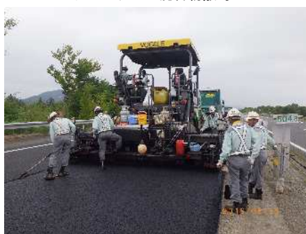
アスファルト混合物敷均し
