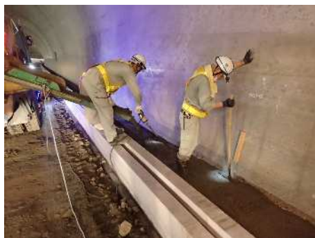
均しコンクリート打設
