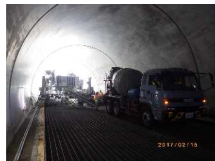
コンクリート打設
