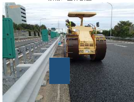
鉄輪に型枠設置
