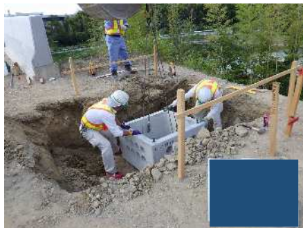
ハンドホール据付
