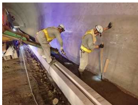
均しコンクリート打設
