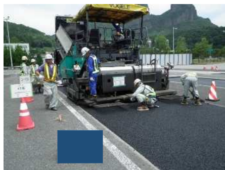
試験舗装(敷均し)
