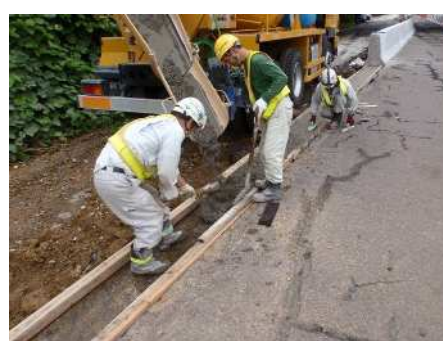
基礎コンクリート打設
