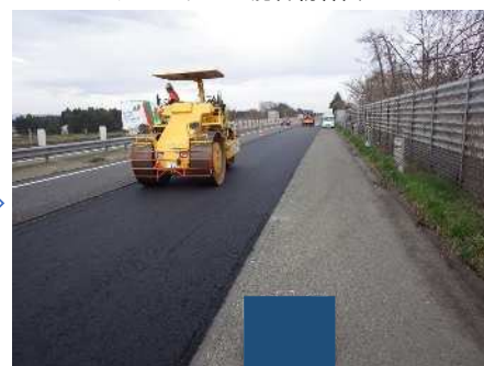
アスファルト混合物締固め
