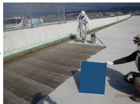
床版用接着材塗布
