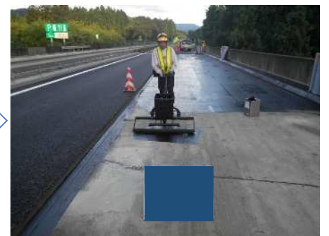
プライマー塗布
