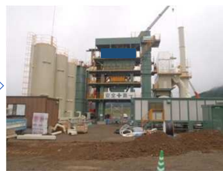
仮設完了(電気配線など)
