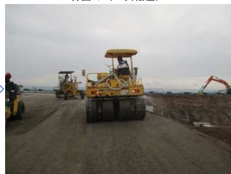
締固め（2次転圧）
