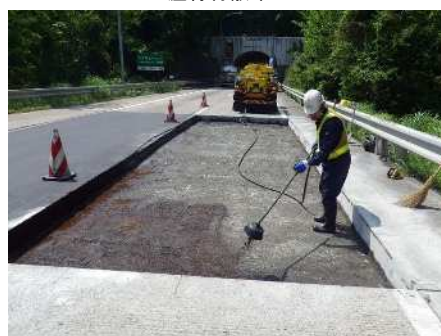
瀝青材散布工
