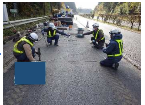
ループコイル埋設
