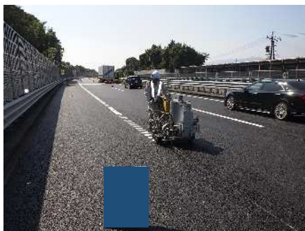
リップのみ施工
