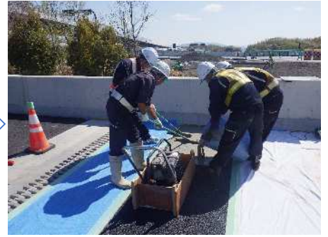
セメントミルク注入
