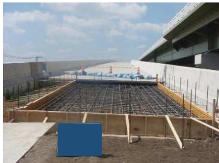
型枠設置・鉄筋工
