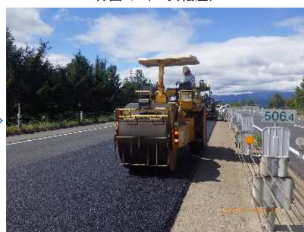
締固め（1次転圧）
