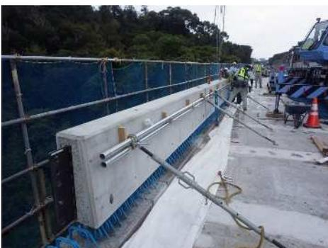
壁高欄については、従来は現場打ちで行ってきたが、最近では壁高欄を工場にて打設し、プレキャスト床版と一体化して架設する試みも行われている。
