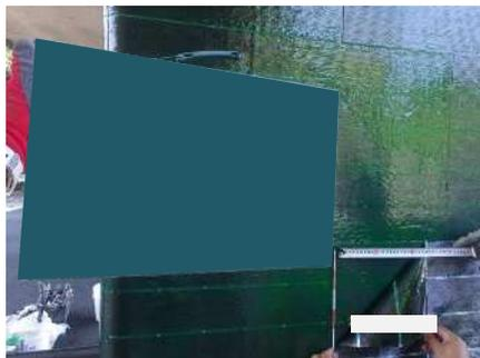
※一つの補強箇所には2層以上の炭素繊維を張り付ける場合、下層の含浸接着樹脂上塗り完了後、4時間以上経過し指触硬化状態になるのを待ってから、次層の含浸接着樹脂下塗りを開始する。
