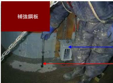
※ 補強鋼板架設完了後、無収縮モルタル充填前に、取付ブラケットとアンカーボルトを設置する。
