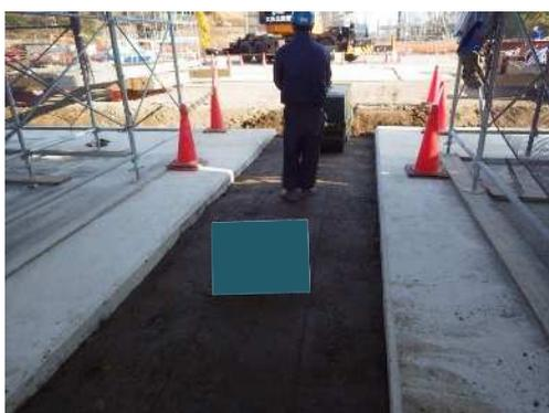
所定の厚さ毎に振動ローラーで締固めながら埋め戻す。
