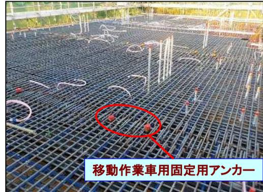
移動作業車用固定用アンカー
