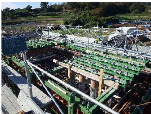
予め所定の間隔に配置された鋼製のボイドを所定の位置・高さにセットする。
