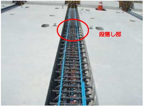
接合部の鉄筋は、床版の調整後、組立を行う。配力筋は、高所作業車等を使用してサイドから挿入するが、作業が無理な場合は(上空制限がある場合等)、ループ鉄筋の一部を段落しとし橋面上から挿入できるような配慮が必要である。
