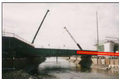
梁（架設桁）+くさび結合式支保工
