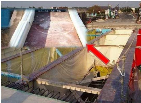
既設床版撤去後、上フランジ先端に残存するコンクリート片をチッパー等で撤去する。
