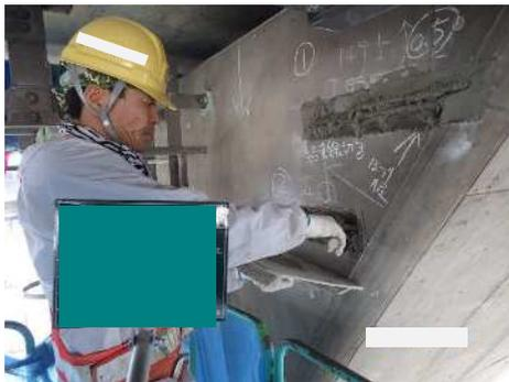
・施工条件として注意しなければならないことは、施工時の天候／気温／温度／被着面の状態・塗り間隔であり、使用する材料に適した条件で行わなければならない。
