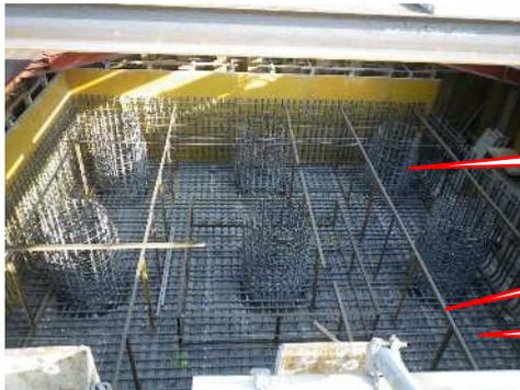
杭頭補強鉄筋
