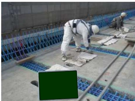
スタッドジベルについては、施工に先立って溶植を行う者の資格の確認と基準試験を行い、技量と必要とされる品質が確保されているか確認する。
