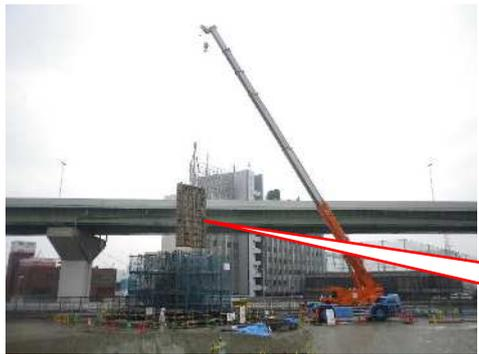
当該現場では、予めパネル状に大組みした型枠をクレーンを用いて設置している。
