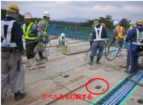
接合部のコンクリートは、PC床版の強度と同等のものを使用し、ジベル孔についても打設することを標準とする。
