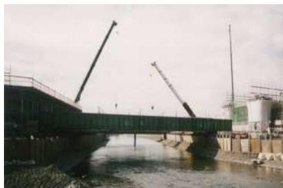
梁(架設桁)+くさび結合式支保工
