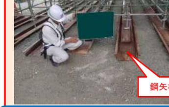
支保工基礎は、敷き均した砕石上に鋼矢板を用いる方法が一般的であるが、地耐力が不足する場合は、杭とH型鋼梁を使用した基礎を設けることもある。
