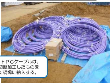
プレグラウトPCケーブルは、必要長に切断加工したものを丸く束ねて現場に納入する。
