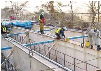
新設床版の搬入に関しては、製作工場より現場に直送するのが標準とする。
