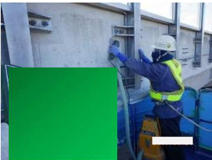
ディスクサンダー工法とは、ウォータージェット工法を用いることが困難な狭隘な場所、光ケーブル等の近接施工箇所などに使用する。支障物から100mmまでを基本とする。
