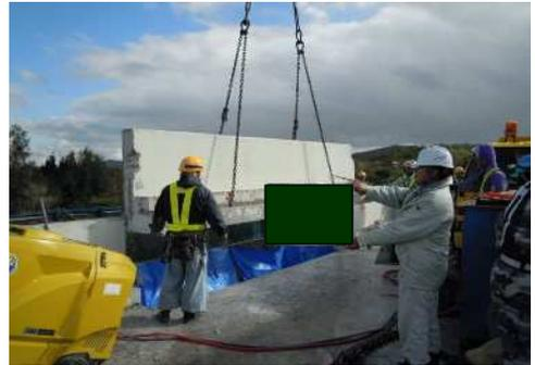
地覆・壁高欄の撤去に関しては、4mに切断し、搬出するものとする。
