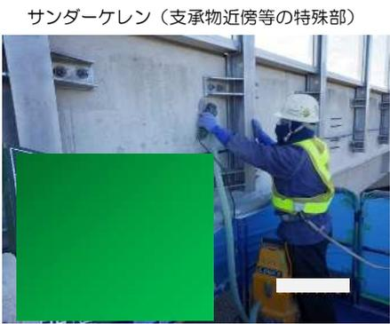
ディスクサンダー工法とは、ウォータージェット工法を用いることが困難な狭隘な場所、光ケーブル等の近接施工箇所などに使用する。支障物から100mmまでを基本とする。
