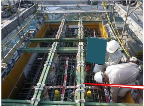
形網を用いて所定の位置・高さにボイドを設置する。
