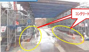
くさび式支保工に比べ大きな反力が生ずる支保工基礎には、コンクリート製基礎を用いるのが一般的である。
