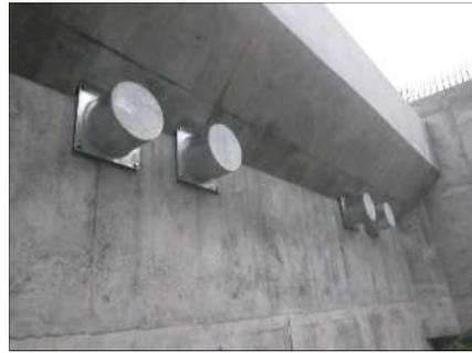
落橋防止構造 桁側
