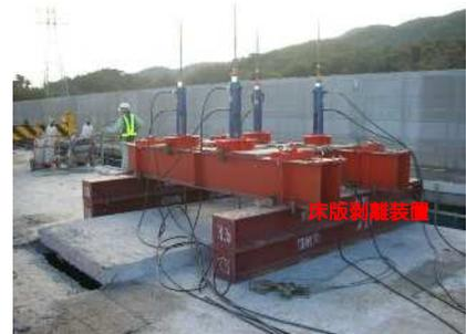
既設床版の剥離は、主桁に無理な力をかけないよう床版剥離装置を使用する事を標準とする。
