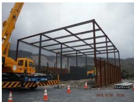
骨材仕切、上屋設置
