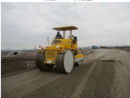
締固め（1次転圧）
