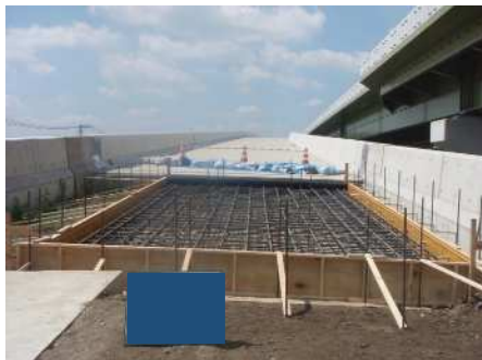
型枠設置・鉄筋工
