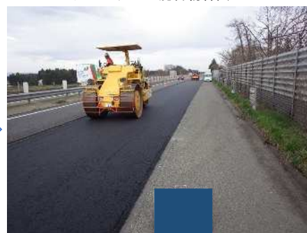
アスファルト混合物締固め
