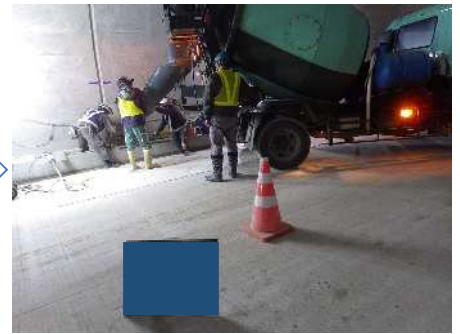
コンクリート打設
