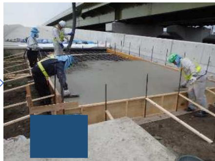
コンクリート打設
