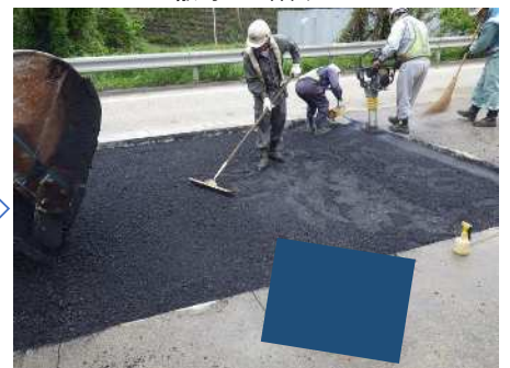
敷均し・締固め
