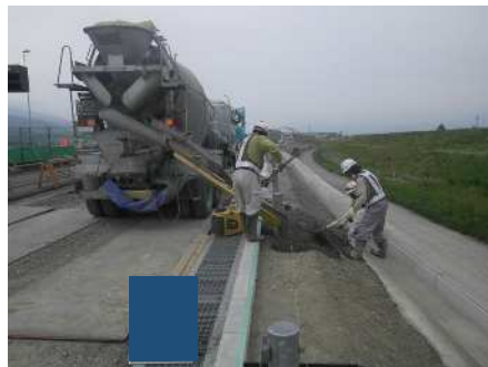
コンクリート打設
