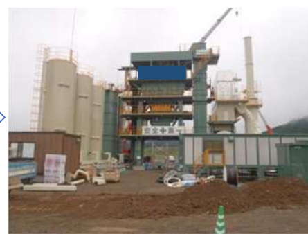
仮設完了(電気配線など)
