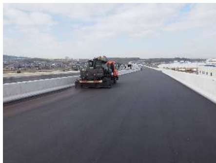
瀝青材散布工
