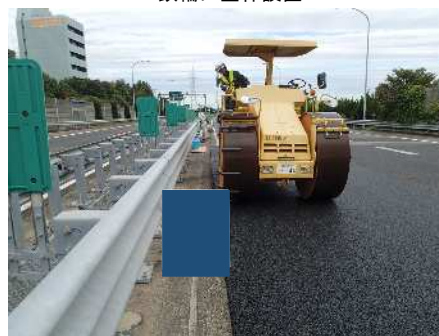
鉄輪に型枠設置
