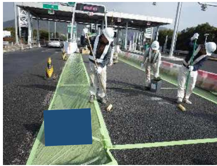
プライマー塗布
