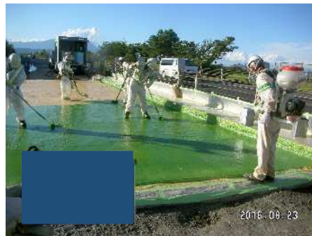
舗装接着材塗布
