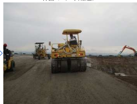
締固め（2次転圧）
