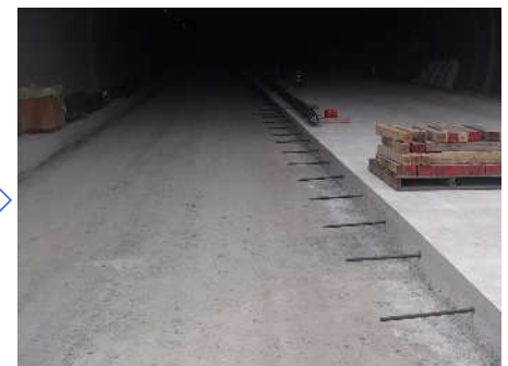
1車線分打設完了
