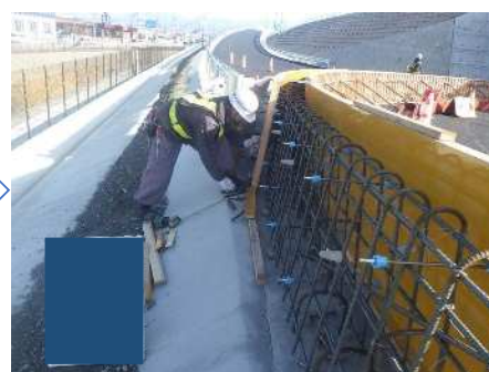
鉄筋工・型枠工
