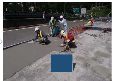
断面修復（コンクリート打設）
