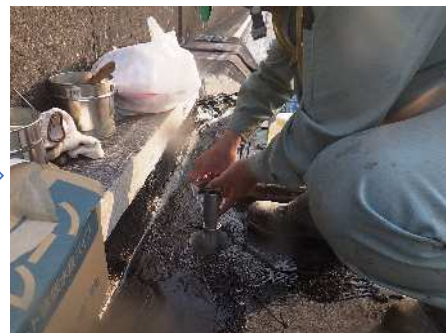
ドレーン設置
