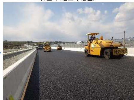
締固め(仕上げ転圧)
