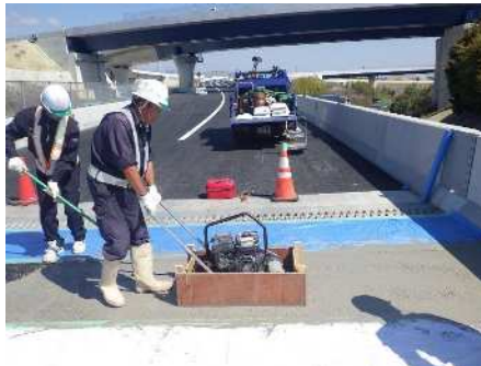
セメントミルク振動・締固め
