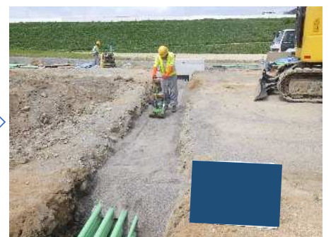
保護砂埋戻し・締固め
