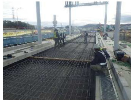
鉄網・補強鉄筋配置
