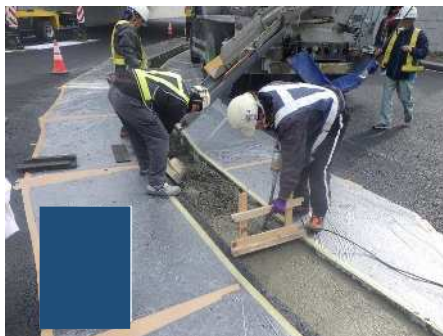
基礎コンクリート打設
