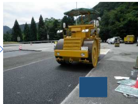
試験舗装(1次転圧)
