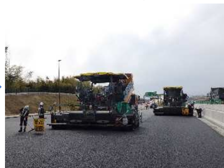
アスファルト混合物敷均し
