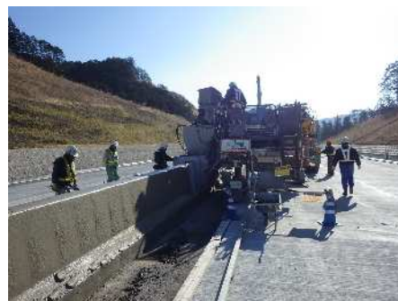
コンクリート打設
