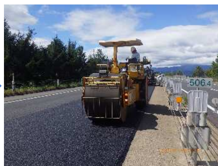
締固め（1次転圧）
