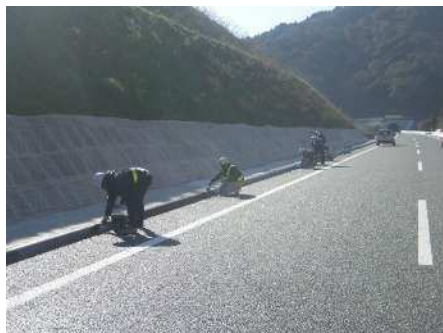
乳剤散布(シールコート)
