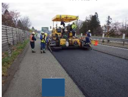
アスファルト混合物敷均し
