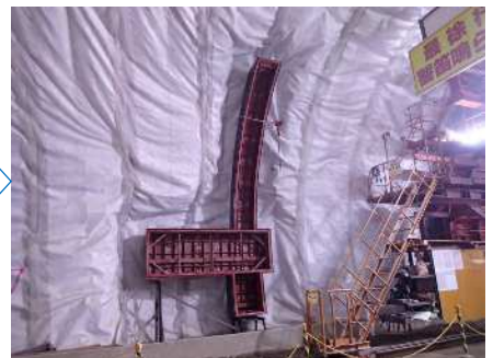
型わく据付(箱抜き型わく)
