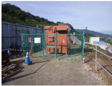
汚濁水処理工（設置状況）
