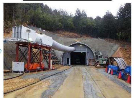
換気設備工（設置完了）
