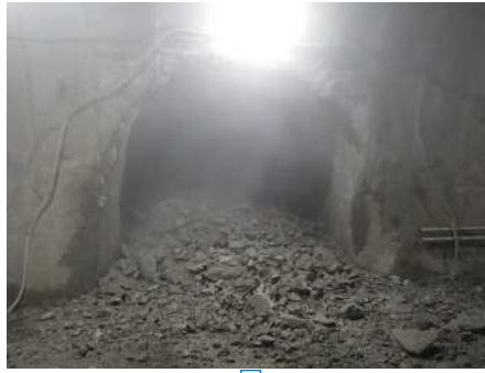
ずり処理（ずり積込み）
