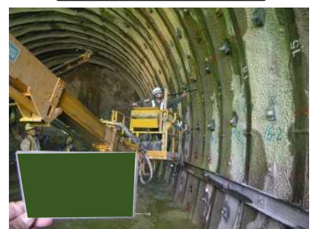
計測工B（地中変位測定）
