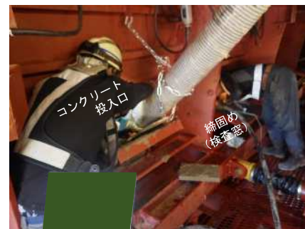
覆工コンクリート（打設）
