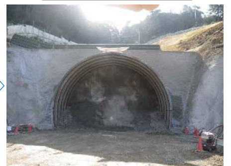
坑口切付け施工完了
