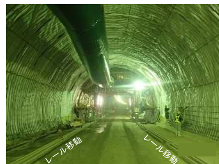
型枠移動（養生完了後）
