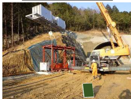
換気設備工（設置状況）
