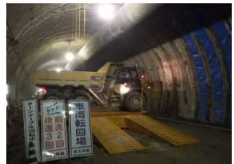
ターンテーブル設備工（必要に応じて）
