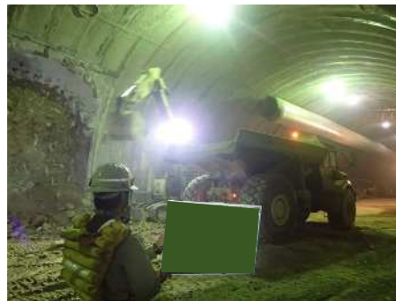
ずり処理（ずり積込み）
