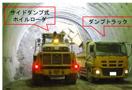
ずり処理（ずり積み）
