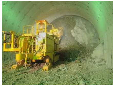
上半掘削（トンネル掘進機）
