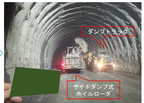
すり処理（すり積み・運搬）
