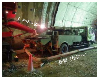
覆工コンクリート（打設）
