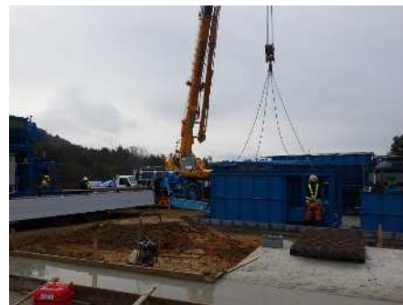
汚濁水処理工（設置状況）
