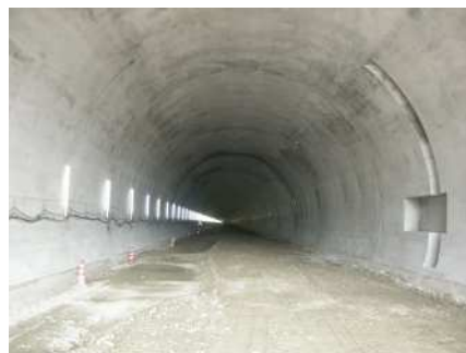
覆工コンクリート打設完了
