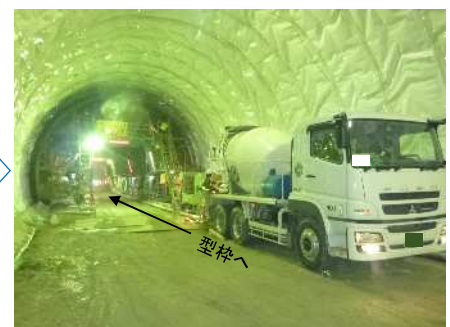
覆工コンクリート（ミキサー車）
