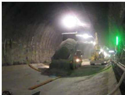
インバート締め完了
