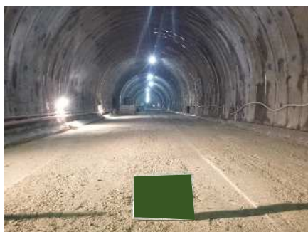
インバート締め完了
