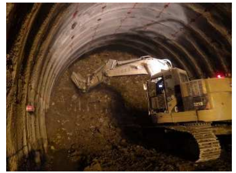
上半掘削（油圧切削機）
