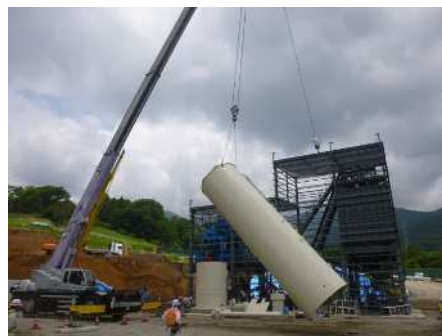
吹付設備工（搬入設置状況）
