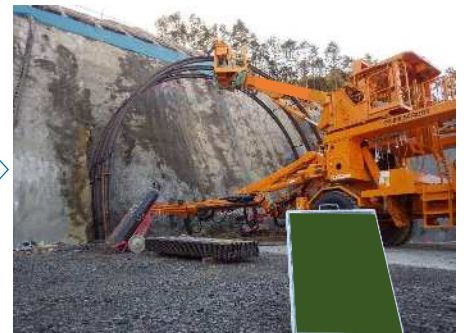
坑口切付け施工完了
