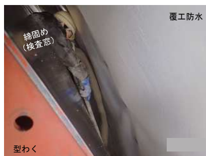
覆工コンクリート（打設）
