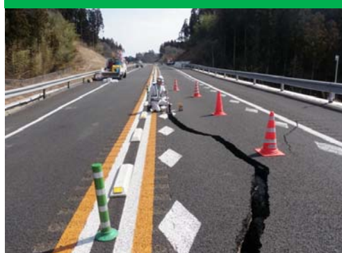
盛土崩落による路面亀裂
