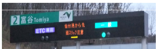
ETC車線表示板（LED） 信号灯（LED） C型情報板（光源：LED）
